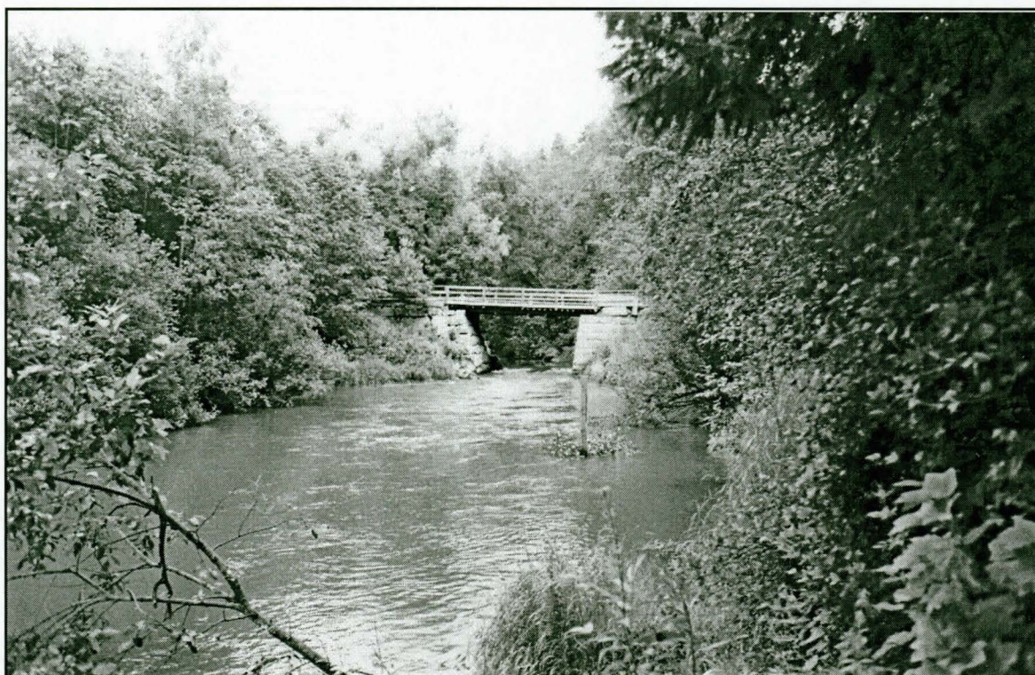
LKM neg. 130 516. Lahti Renkomäki ja Okeroinen Patosilta. Porvoonjoen ylittävä silta etelästä kuvattuna.
