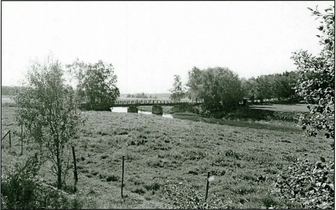
LKM neg. 130 556. Orimattila Ruha Ruhansilta luoteesta.
