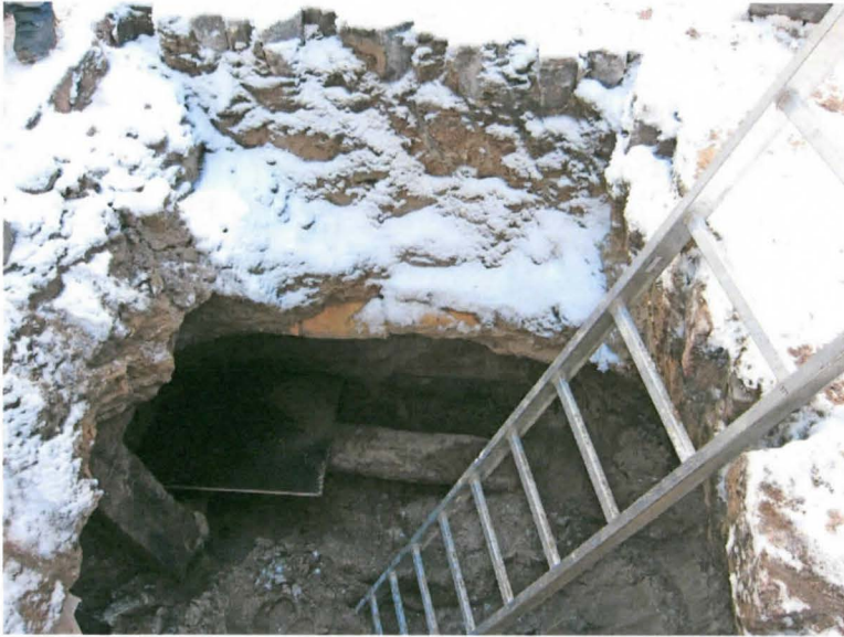
Kuva 3. Kaivannon pohjoispää. Kaivannon pohjalla on kadun suuntaisesti putki ja ylempänä kaapeli. Länsisivulla näkyy sulkuventtiilin puinen suojarakenne. Kuvaussuunta NW. 30.3.2011.
