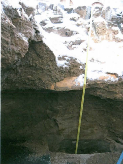
Kuva 5. Kaivannon pohjoisseinä kuvattuna kaivannon pohjalta. Kuvaussuunta NW. 30.3.2011.
