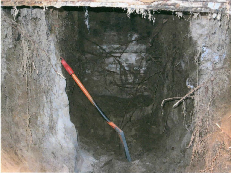
Kuva 10. Kaivanto eteläpäässä poikittaisten kaapeleiden kohdalta kuvattuna. Takana näkyy rakennuksen betoniperustus. Kuvaussuunta SE. 30.3.2011.
