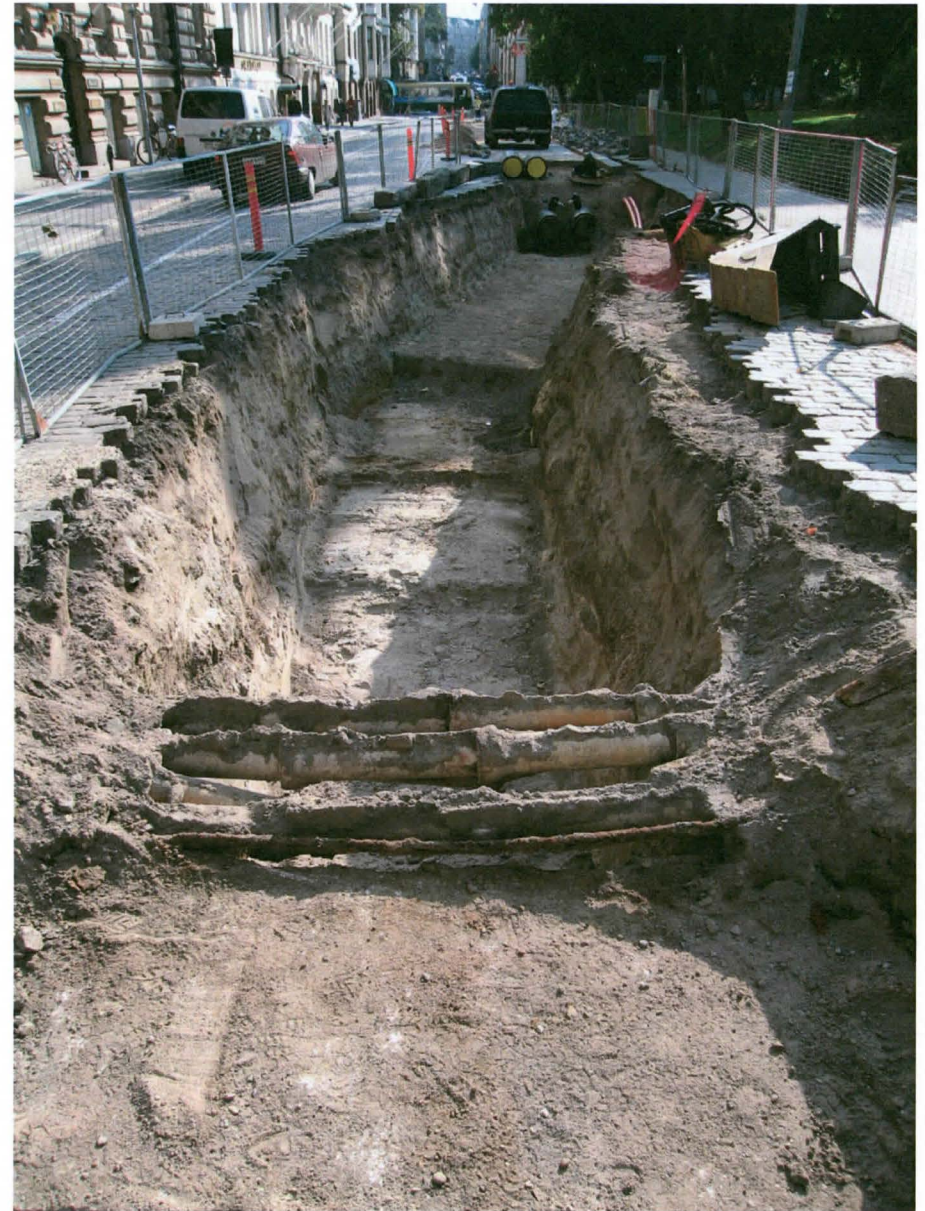
Kuva 5. Yrjönkadun kaivannon pohjoispäässä ennen Lönnrotinkatua kaivanto siirtyi keskemälle katua. Kuvaussuunta SE. 26.9.2005.
