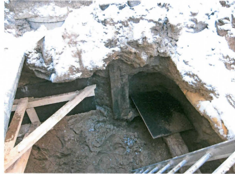
Kuva 4. Edellinen tilanne. Kuvassa on kaivannon luoteiskulma. Kaivannon länsiseinän kohdalla meni kadulta rakennukseen keraaminen putkilinja, joka näkyi itäseinän täyttökerroksina. Kuvaussuunta SW. 30.3.2011.
