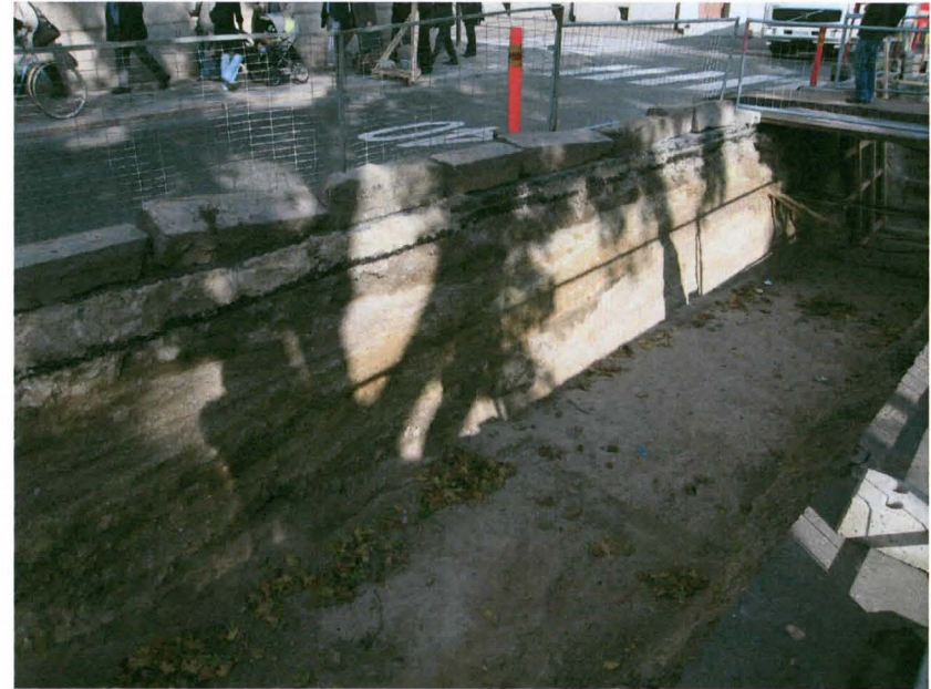
Kuva 10. Edellinen tilanne. Lähikuva kaivannon itäosan pohjoisseinästä. Kuvaussuunta N. 26.9.2005.
