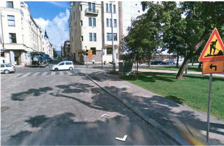
Yhteiskäyttötunnelin poistumiskotelo, vihreä kotelo, sijaitsee Vanhan kirkkopuiston luoteisnurkassa. Kuvaussuunta NW. (Kuva: Google maps, katunäkymä. Katsottu 12.5.2014)
