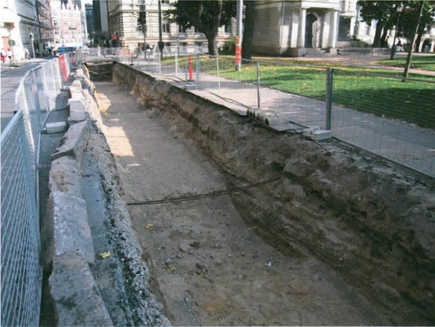
Lönrotinkadun kaivanto itäosassaan. Profiileissa on hienoa hiekkaa ja karkeata hiekkaa/soraa ennen yläosien täyttömaita. Kuvaussuunta E. (HKM/Helsinki, Kamppi 2005:9).
