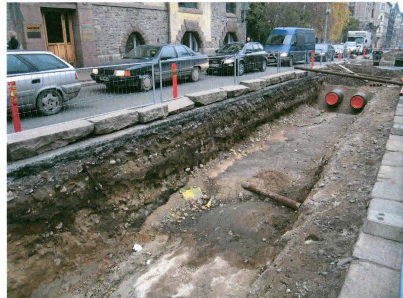
Kuva 14. Lönnrotinkadun kaivannon länsiosassa kallio tuli esiin ennen kaivannon pohjan tavoitesyvyyttä. Kuvaussuunta N. 4.11.2005.
