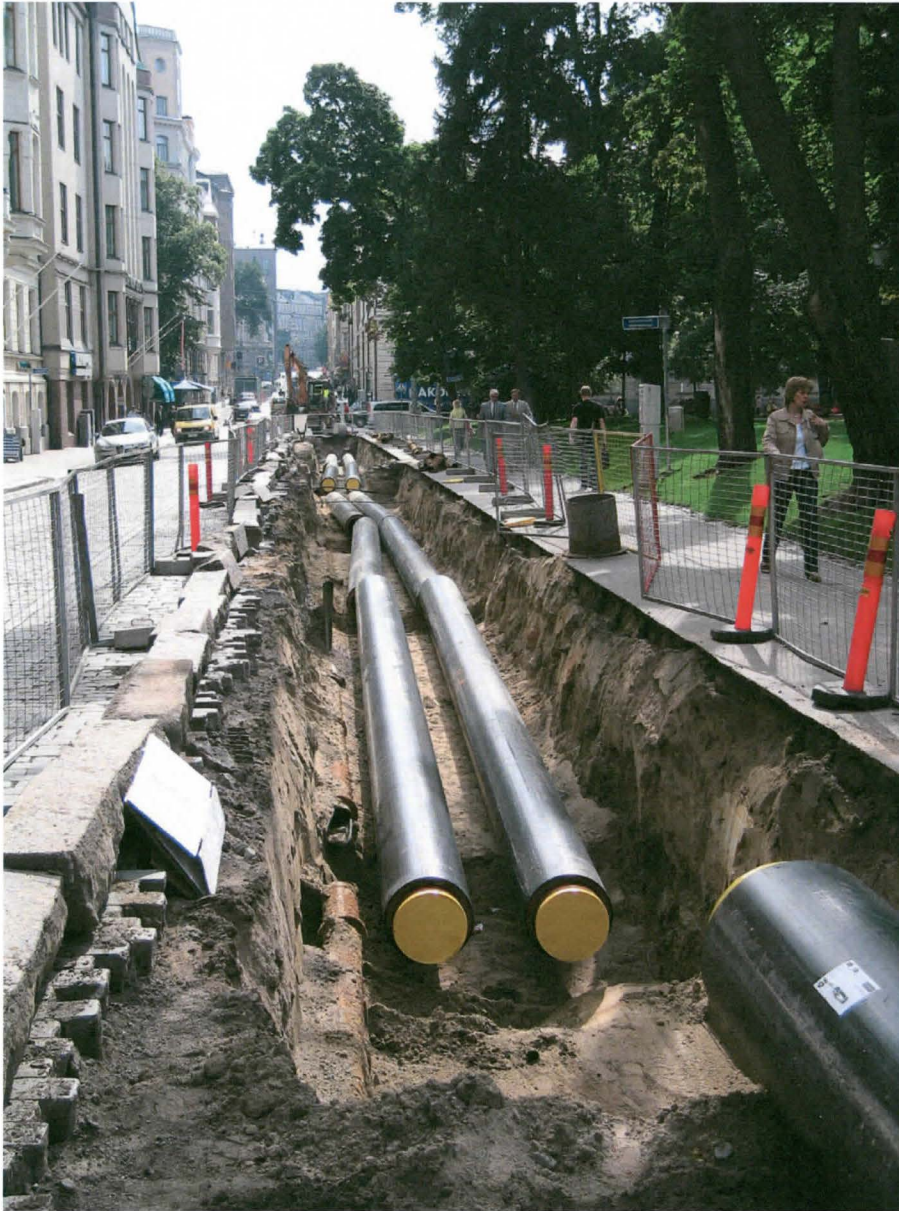
Kuva 4. Yrjönkadun kaivantoon asennetaan putkia. Kuvaussuunta SE. 23.8.2005.
