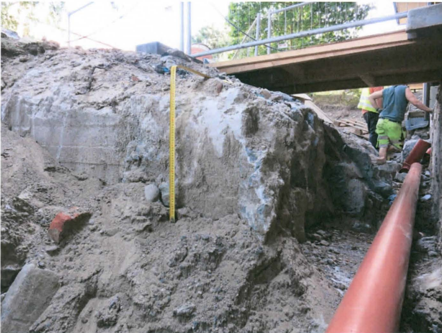
Havaintopiste 3:n rakenteet. Oikealla on Kolsarintie 8 C:n rakennuksen itäseinä, putken kohdalla 85 cm leveä kaivanto ja sen itäpuolella suurimmaksi osaksi linnoitusaseman piikatut betoniseinät. Rakenteen yläkulmassa mitan oikealla puolella näkyy rautalenkki. Kuvaussuunta S. HKM/Helsinki, Konala 2014:19.
