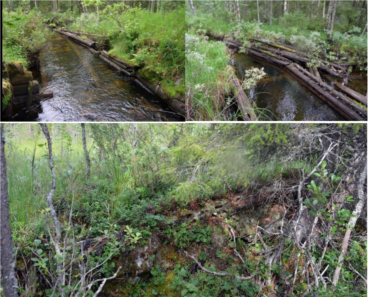
Kuvat: Ylärivi: Uoman ohjeseiniä ja pohjalavan jäänteitä. Alhaalla rakenteeseen kuuluvan pitkän maapadon valli ja sen hirsirakenteiden jäänteitä.
