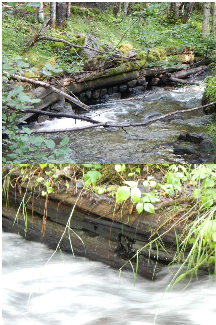
Kuva 21. Kohteen Välijoki 2 rakenteita.
