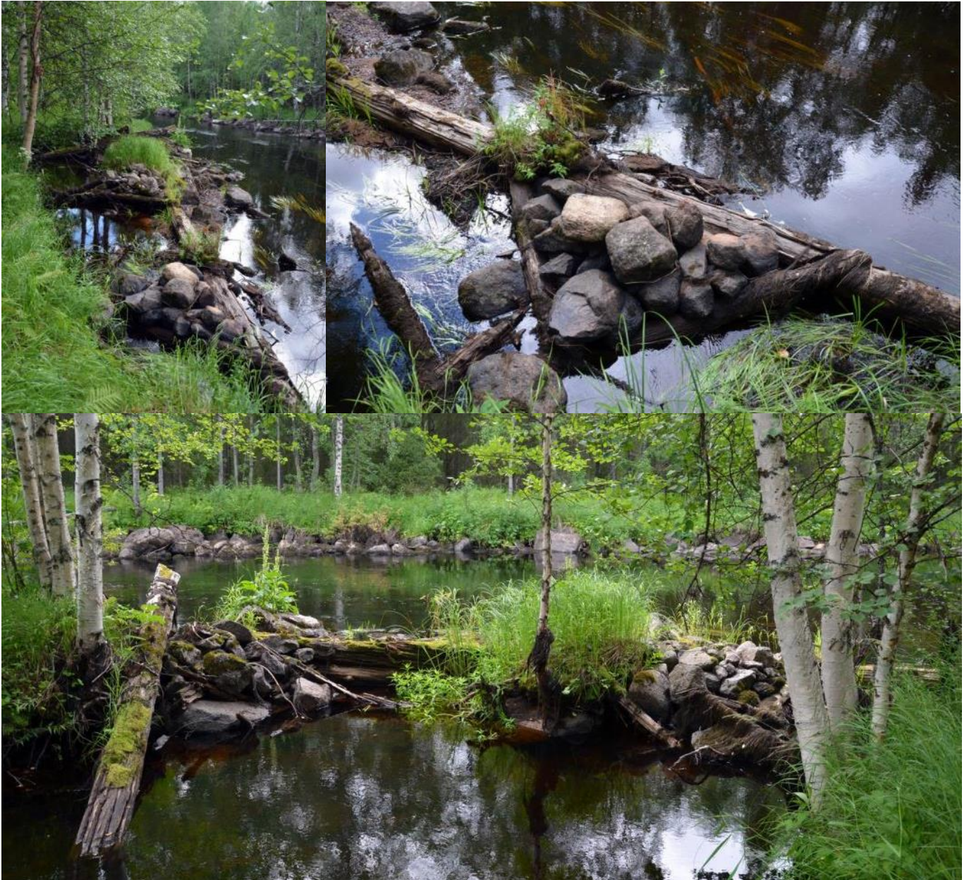
Kuvat: Kunnostusalueen sivujoen sulkevan konttiohjeseinän rakenteita. Matala ohjeseinä ja sitä tukevat kolmikulmaiset kiviarkut, kontit.
