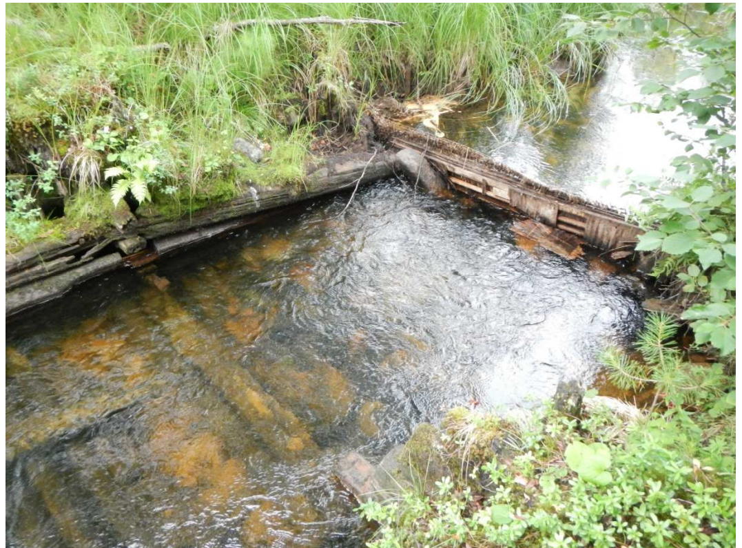
Kuva 18. Kohteen Väljoki 1 rakenteita.
