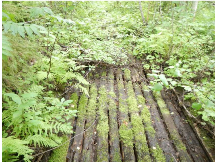
Kuva 10. Puurakennetta uittoruuhun pohjalla.
