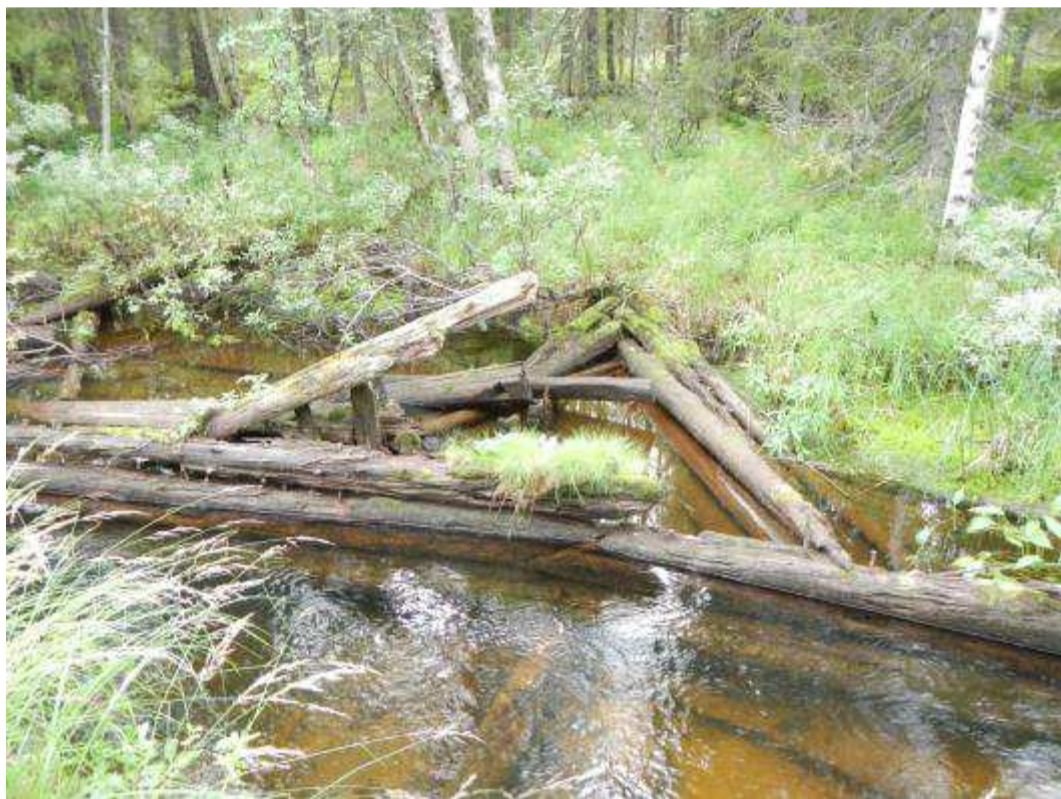
Kuva 19. Kohteen Välijoki 1 rakenteita.
