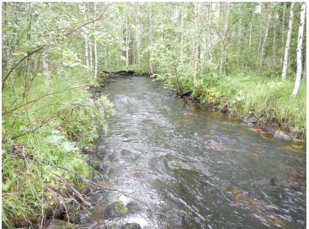
Kuva 26. Raivattua Suukosken uomaa.
