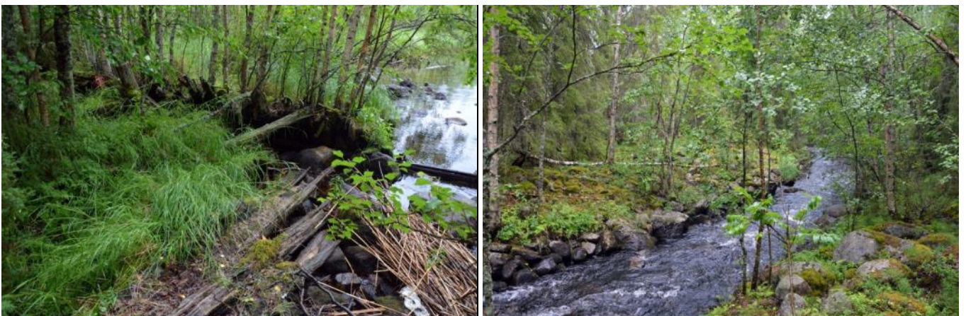
Kuvat: Niskakosken säästöpadon jäänteet, oikealla rännimäinen uoma ja raivauskivikoita.
