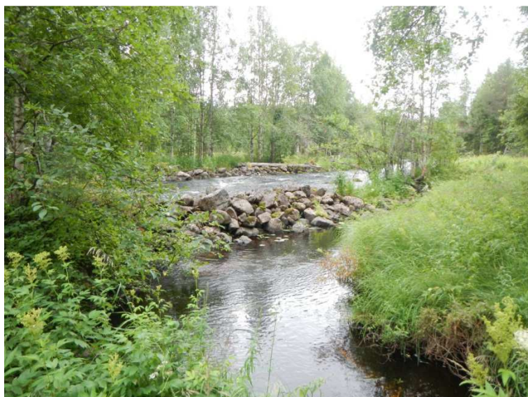
Kuva 12. Uittoruuhun eteläpää on erotettu koskesta kivirakenteella.
