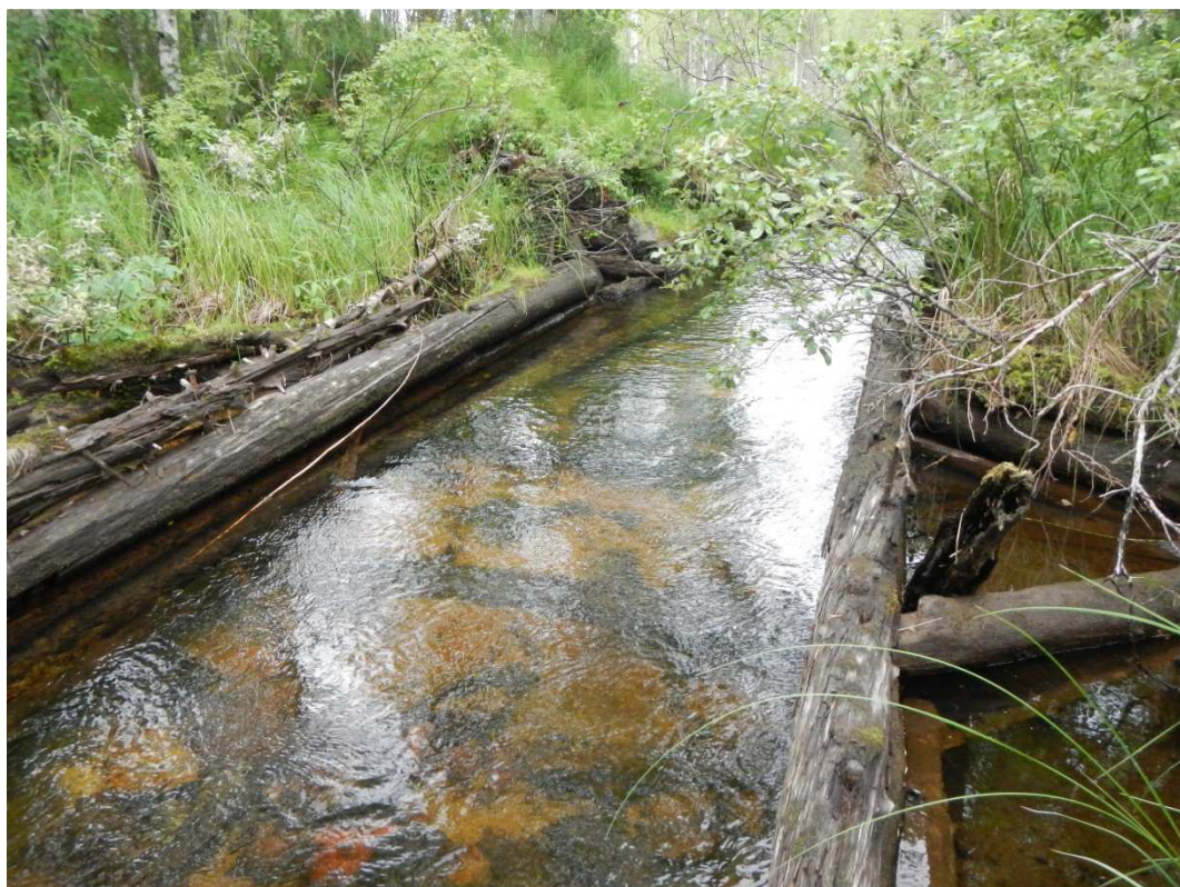
Kuva 20. Kohteen Välijoki 1 rakenteita.
