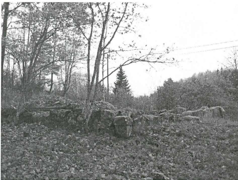
Kuva 6. Kestikievarin perustus, kuvattu eteläkaakosta.
