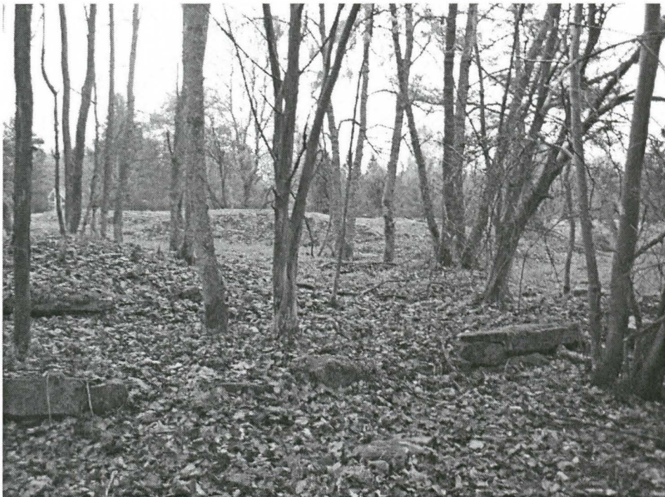
Kuva 2. Kuvan 1 rakennuksen perustan itäpää. Kuvattu kaakosta.
