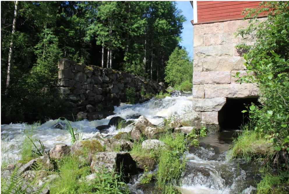
Kuvan oikeassa laidassa näkyy Immilän myllyn juoksutuskanavan aukko. Kosken toisella rannalla sijaitsi Arrajoen mylly. Kuvattu länteen.
