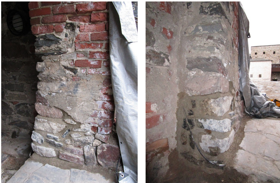
KUVAT 4 ja 5. Valmis portinpieli muuraustöiden jälkeen.
