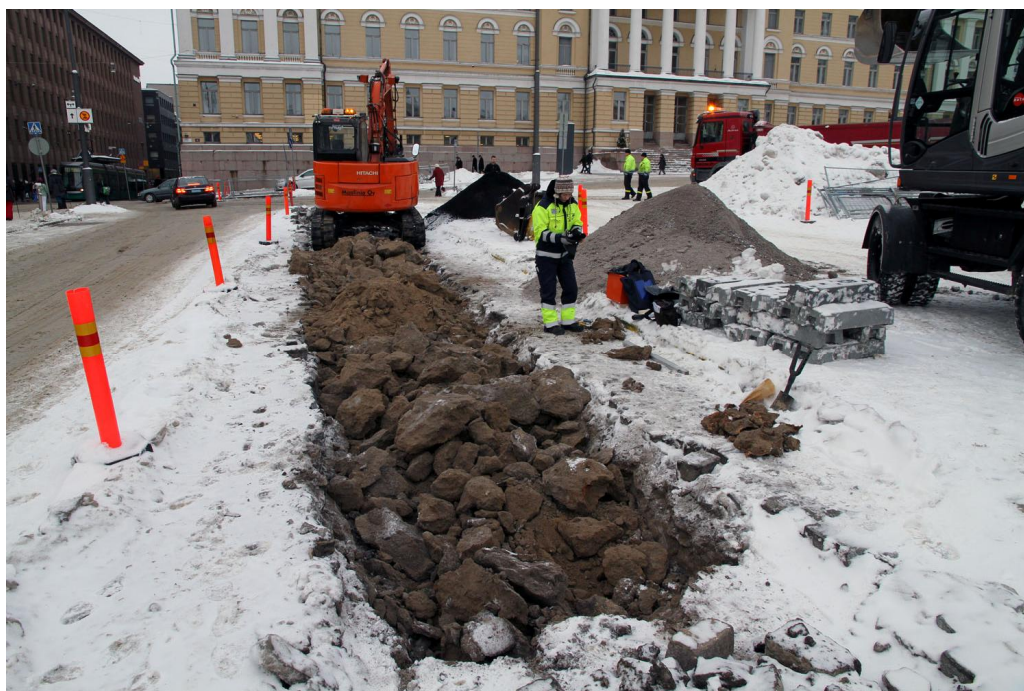
Kuva 20. Hautausmaan aluetta idästä kuvattuna, taustalla yliopiston päärakennus. Kaivinkone on piikkannut routaisen kerroksen. Kuva on tutkimuksista tammikuulta 2011. Markku Heikkinen/HKM.
