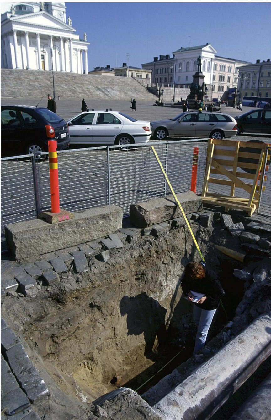
Kuva 17. Kaukolämpökaivannon itäisimmän osan dokumentointia vuonna 2002, kuvassa Jaana Mellanen. Kuva lounaasta. Markku Heikkinen/HKM.
