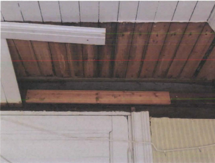
Kuva 5. Lahonnut osa laudasta korjattiin uudella puulla.
