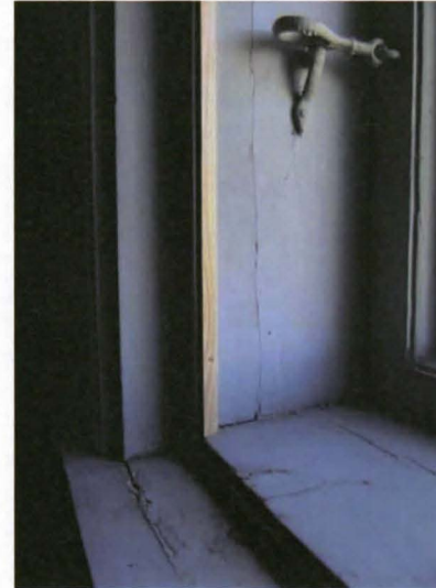
Kuva 54. Lisähuulloslista ja uudet tiivisteet
