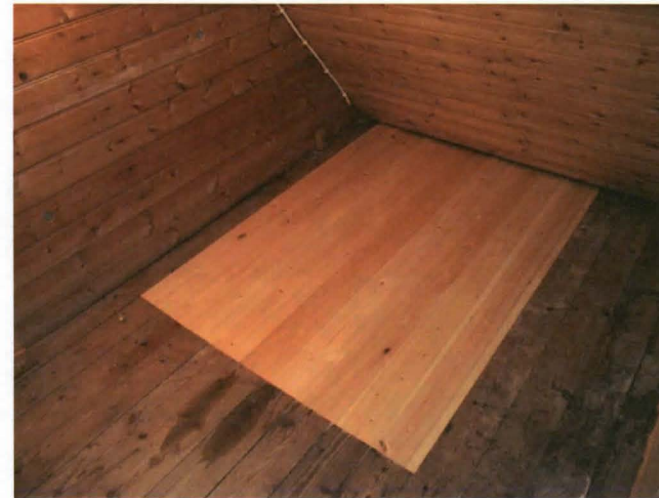
Kuva 61. Uudet lattialankut asennettu.
