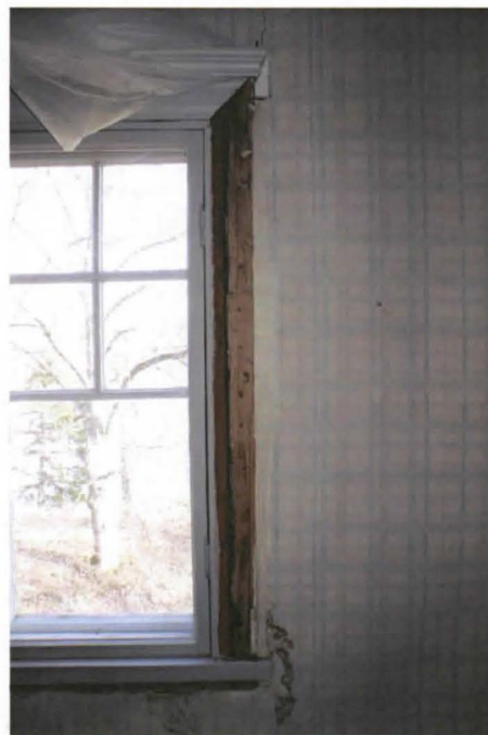
Kuva 13. Tätien huoneen suuremman ikkunan ala- ja sivuvuorilista irrotettu.
