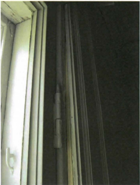
Kuva 19. Tätien huoneen vääntyneen vuorilistan ja karmin väliin tehtiin puupaikkaus.
