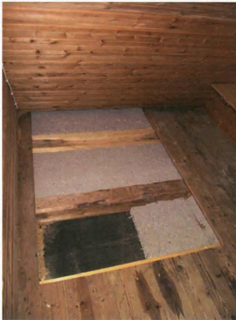
kuva 59. Vanha eristepuru poistettiin ja tilalle laitettiin ekovillaa.
