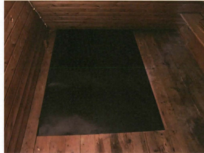
Kuva 60. Ekovillan päälle laitettiin tervapaperi.
