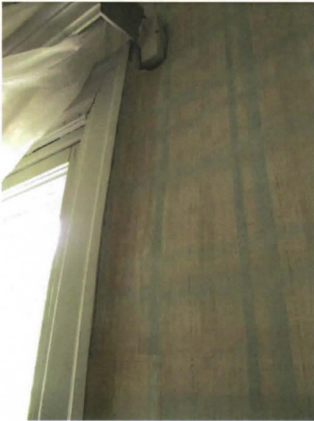
Kuva 18. Tätien huoneen irrotetun sivuvuorilistan päälle kääntövä tapetti paikattiin värjätyllä japaninpaperilla.
