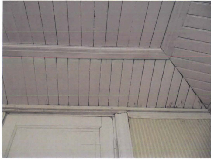
Kuva 6. Vanhat paneelit on palautettu paikoilleen.
