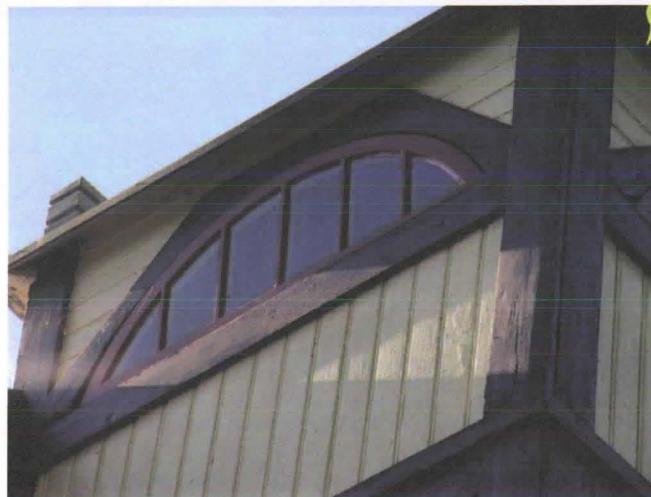
Kuva 63. Ikkuna ennen suoristamista.
