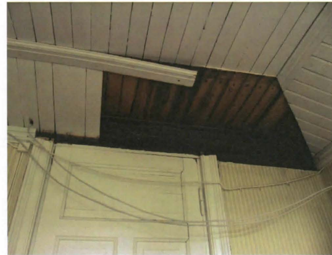
Kuva 2. Katon paneeleja irrotettiin tutkimuksia varten.
