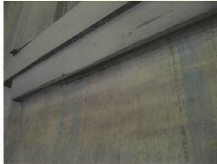
Kuva 20. Irrotetut tapetit liisteröitiin paikoilleen vuorilistojen palauttamisen jälkeen.
