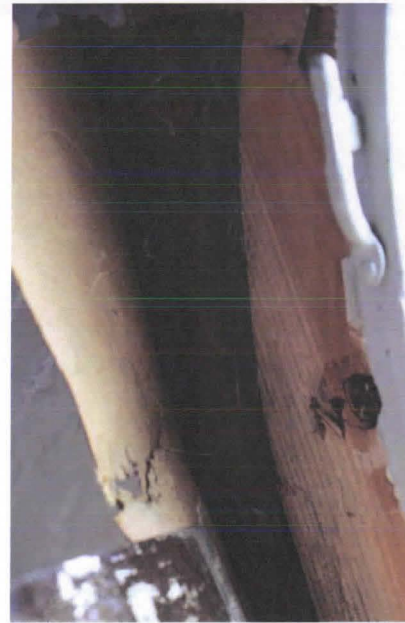
Kuva 17. Ikkunapuitteiden ja karmien väliin lisättiin tarvittaessa pellavarivettä avattuihin kohtiin.
