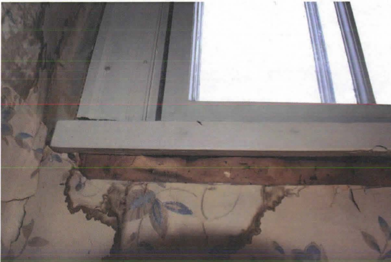
Kuva 16. Piian kamarin ikkunan vuorilista irrotettu.
