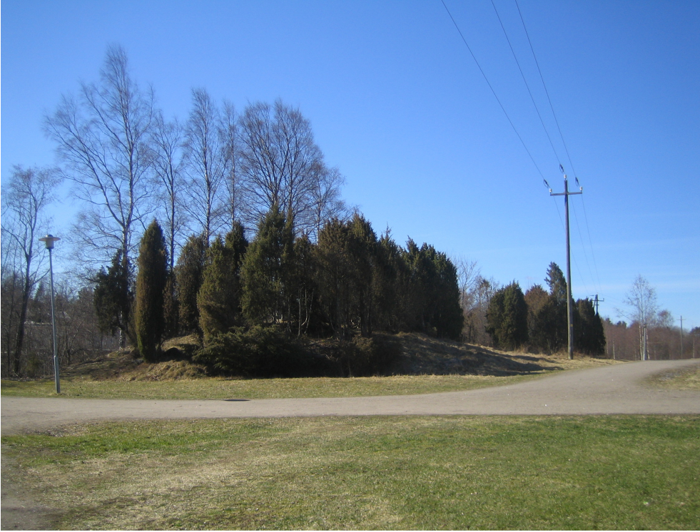
Kuva 9. Muuntajanpönnkä. Kuva T. Vasko.
