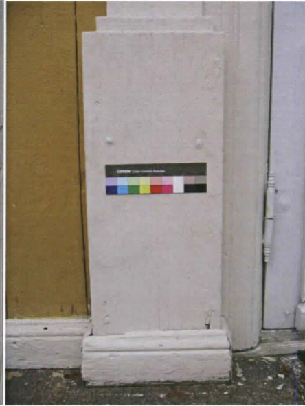
Kuva 7. Pilasteri edestäpäin restauroinnin jälkeen. Kuvaaja: Essi Seppälä
