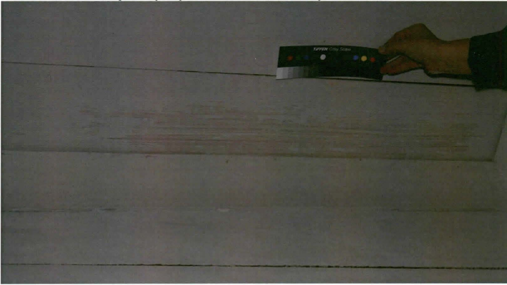
Kuva 66. 2. kerroksen porrassyöksen kattolauta ennen käsittelyä
