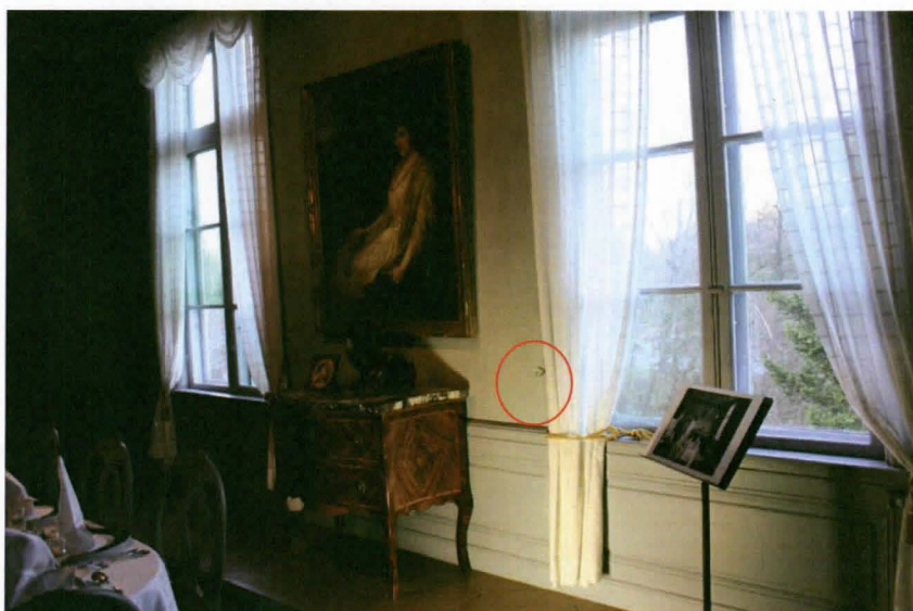
Kuva 70. Vauriokohta ikkunan vieressä. (Kuva L. Niinipuu)
