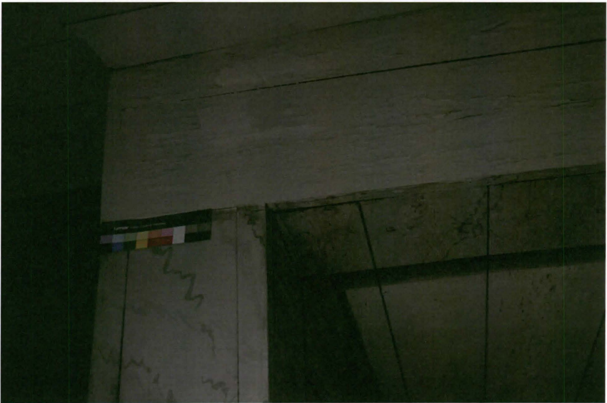
Kuva 60. 2. kerroksen porrassyöksen keskiön puoleinen osa 1 (kuva: J.Kutilainen)
