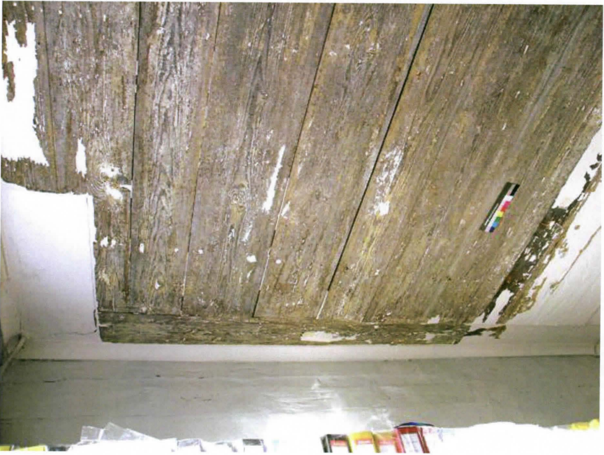
Kuva 55 Esiin otettua kattopintaa
