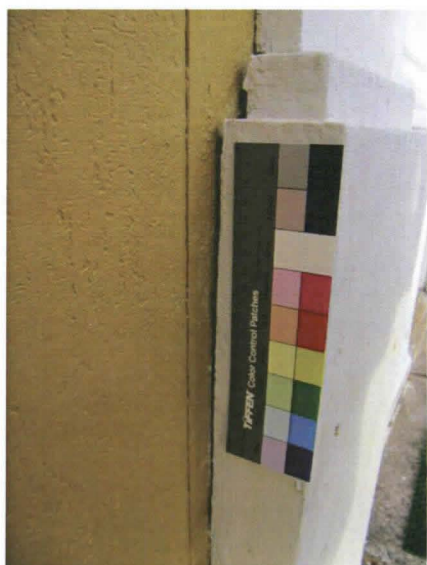
Kuva 4. Pilasteri vasemmalta puolen. Tässä kuvassa pilasteria on jo naputettu nuijalla sisään. Kuvaaja: Essi Seppälä
