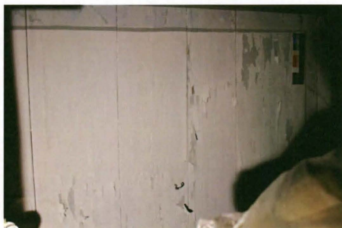
kuva 43. kuva ennen pesua
