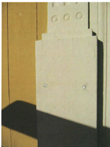
Kuva 5. Pilasterin alaosaan lyödyt takonaulat pohjamaalattuna. Kuvaaja: Essi Seppälä
