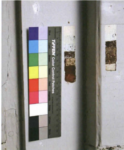
Kuva 15. Väriportaikko ennen karmin välimaalausta. Kuvaaja: Milla Valonen
