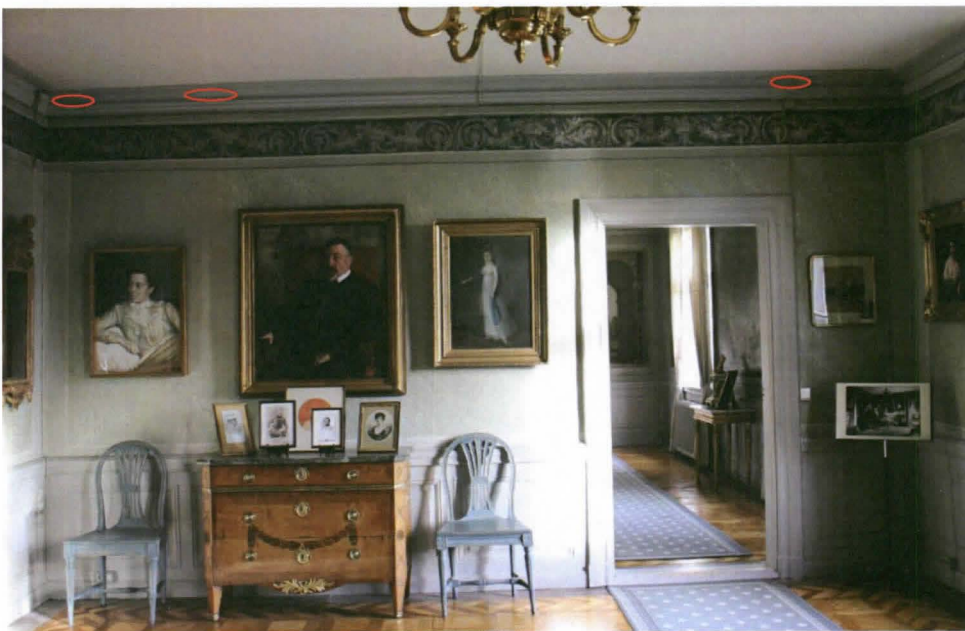
Kuva 27. Itäisen seinän vauriokohdat. (Kuva L. Niinipuu)
