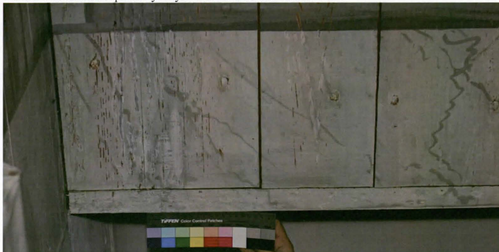
Kuva 64. 2.kerroksen porrassyöksyn keskiön alareuna retusoituna 1.
