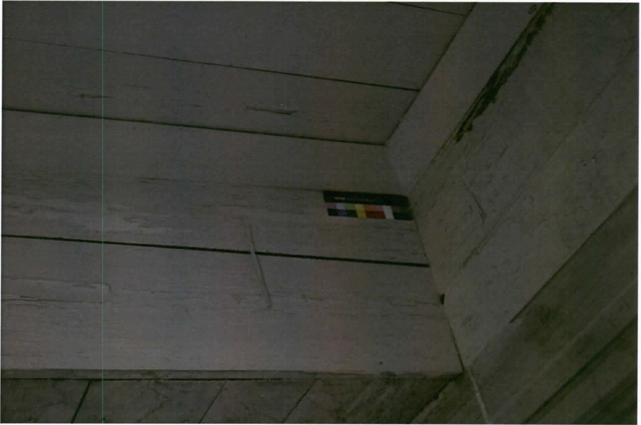
Kuva 61. 2. kerroksen porrassyöksyn keskiön puoleinen osa 2 (kuva J.Kutilainen)
