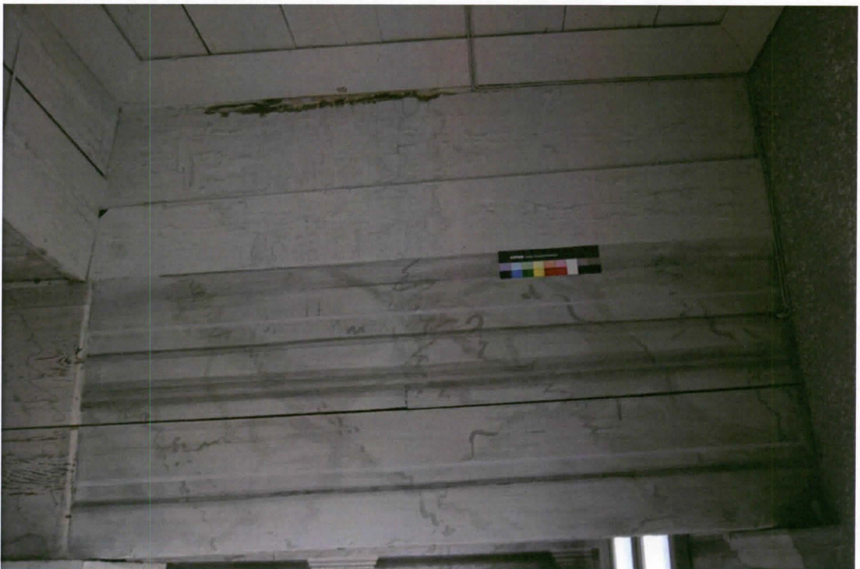
Kuva62. 2. kerroksen porrassyöksyn portaiden yläpuolinen osa (kuva J.Kutilainen)
