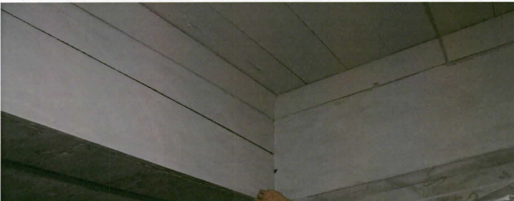
Kuva 67. 2. kerroksen porrassyöksen yläosa maalauksen jälkeen
