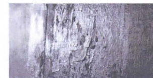
Kuva maalipinnan voimakkaasta kiillosta sivuvalossa.
