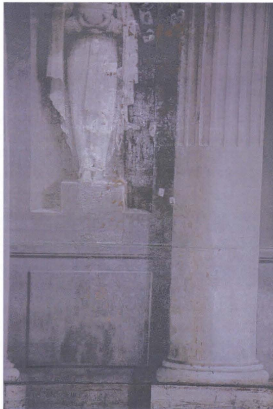
Maalauksen alaosa ennen konservointia. Pinnassa voimakkaita kiiltoja.
