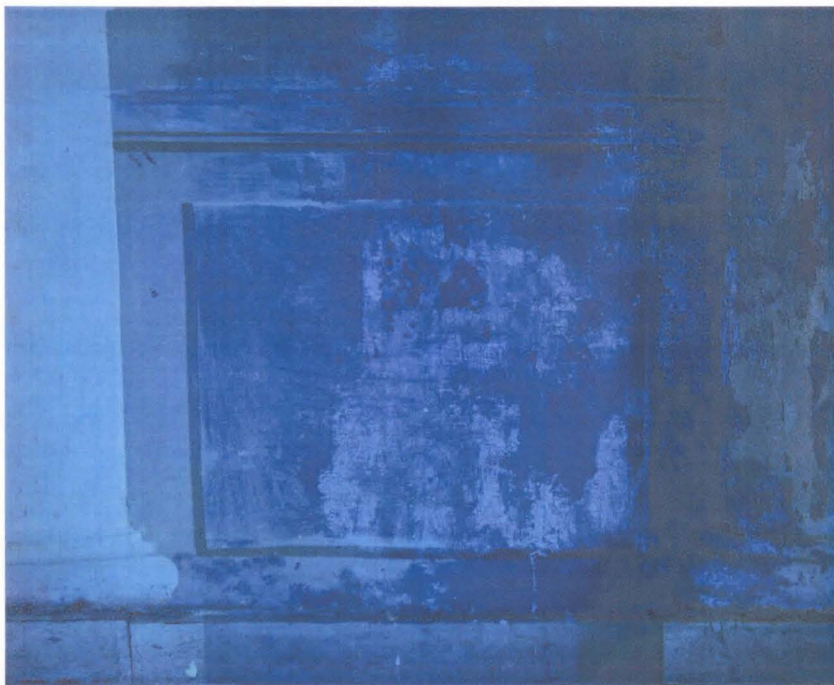
Alapaneelin pinnassa näkyviä vanhoja retusointeja tummalla. Vaaleana fluorosoivat alueet ovat todennäköisesti synteettistä liimaa.
