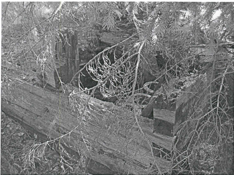
Kuva 17. Dävitsviken (1). Pumppaamon jäännökset, saaren puolella. Kuvattu lounaasta.
