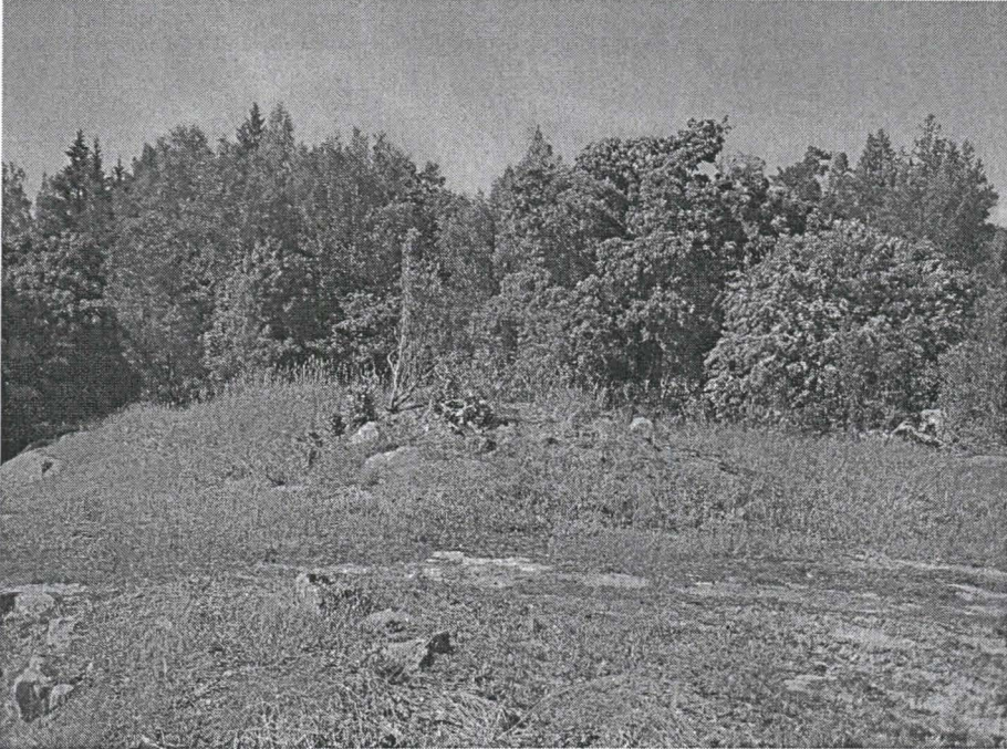
Kuva 1. Ömeros (2). Rakennuksenperustus kallion laella, kaakosta kuvattuna.
