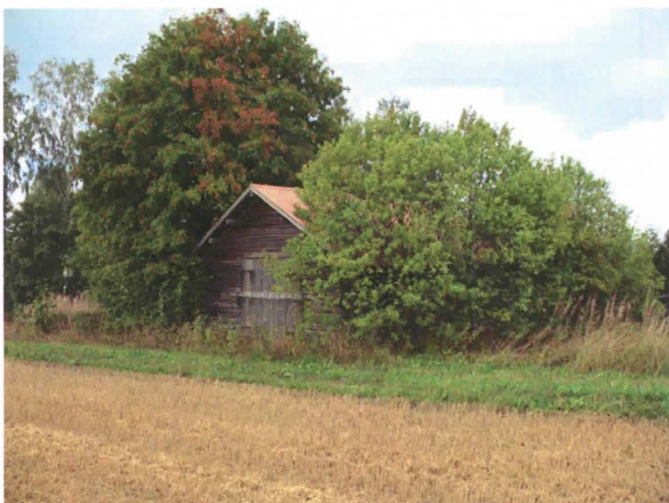
Kuva 1. Lato sijaitsee peltosaarekkeessa.
