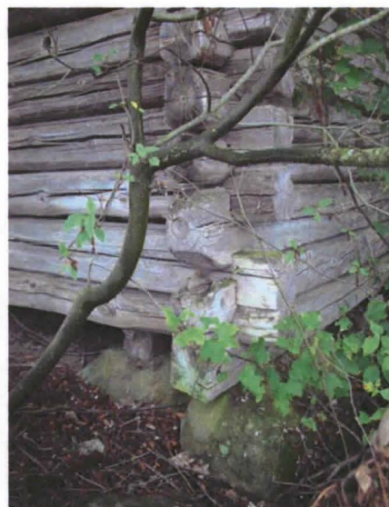
Kuva 2. Ladon nurkkasalvokset ja perustukset.
