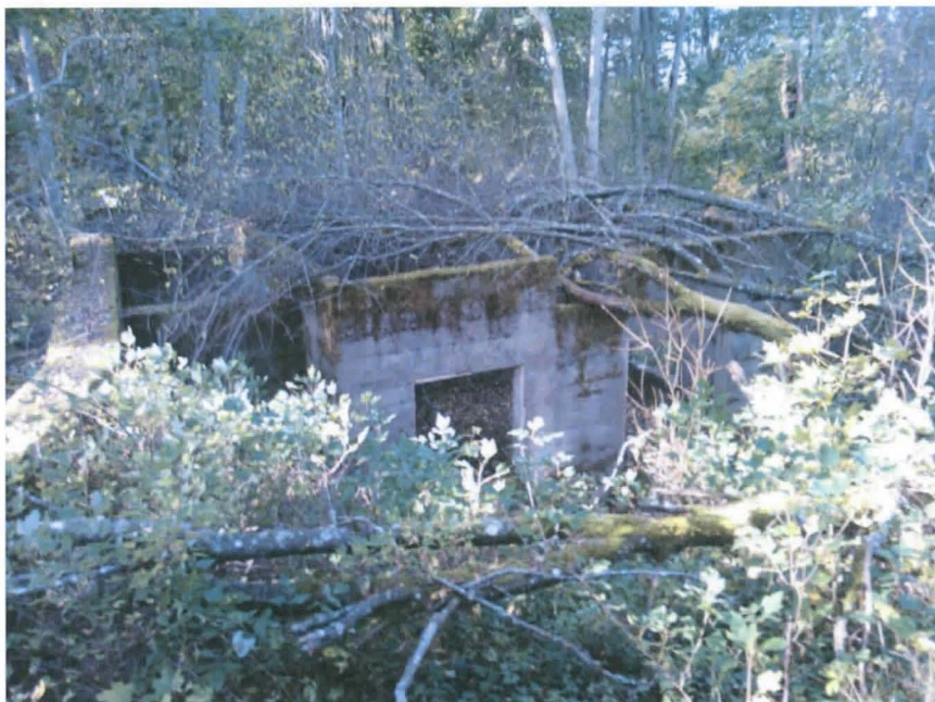
AKDG 3836:36. Raunioitunut voimalaitos joen pohjoisrannalla, pohjoisesta. Kuvaaja: Petro Pesonen.
