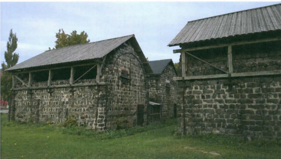
AKDG 3836:28. Kuonaharkkoista rakennettuja taloja (uuneja) Taalintehtäällä. Kuvaaja: Satu Koivisto.
