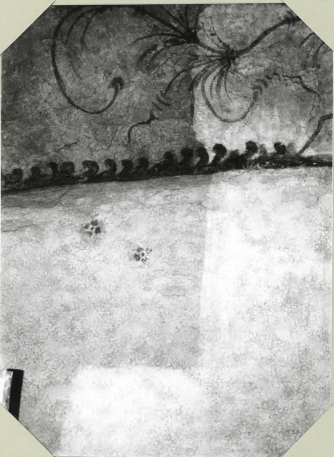
puhdistusrajat näkyvässä -puhdistusmassalla
