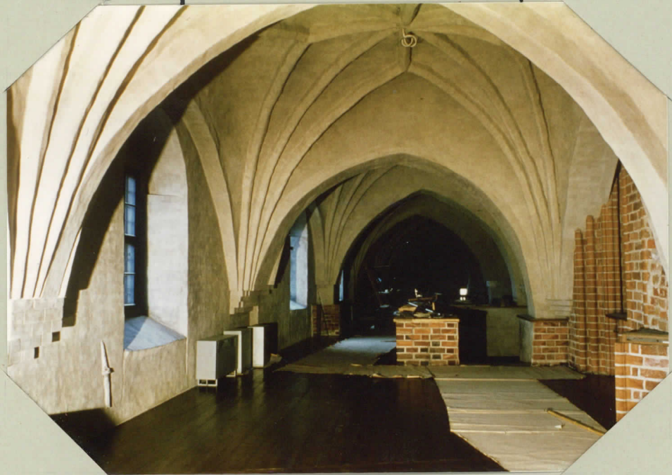
etelälehteri korjauksen ja puhd.jätk.
