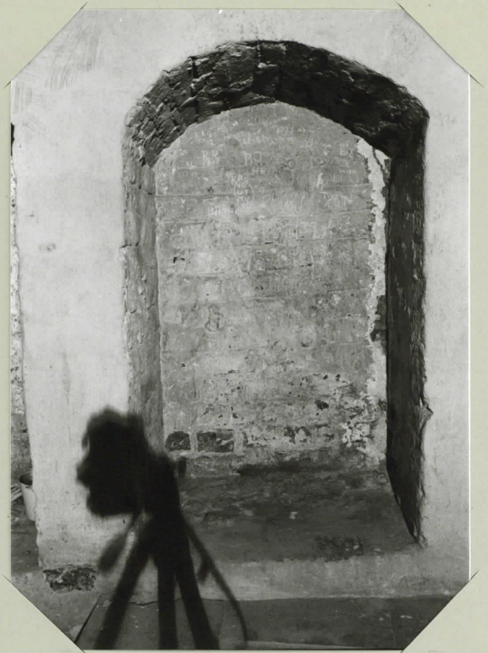
halkeama injektoitu pikasementillä
