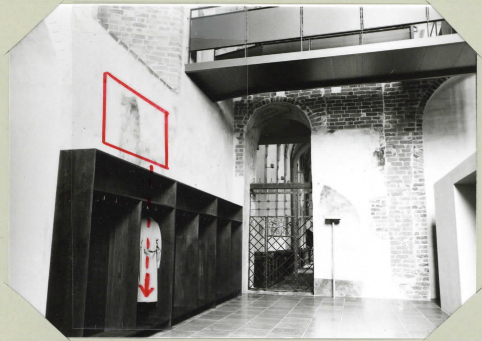
pohjois - itäseinää; rappauspintaa kiinnitetty ja häivytetty
