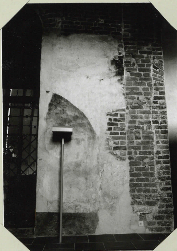
itäseinän rappauspinta kiinnityksen ja häivytyksen jälkeen
