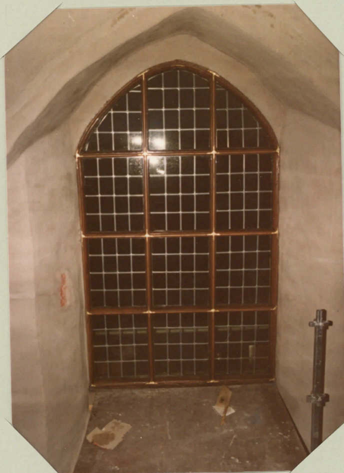
keskiläivän ikkuna korjattuna
