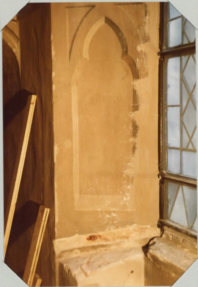
UUTTA LAASTIPAIKKAUSTA IKKUNARAUTOJEN UUSIMISEN JÄLKEEN GALLERIA - KÄYTÄVÄSSÄ
