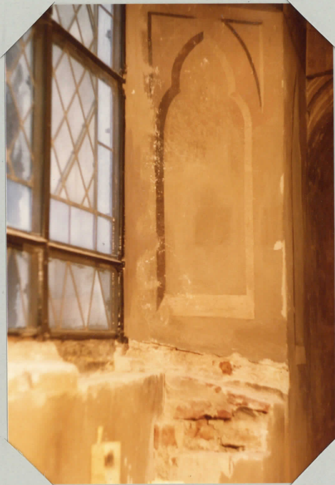
UUTTA LAASTIPAIKKAUSTA IKKUNARAUTOJEN UUSIMISEN JÄLKEEN GALLERIA - KÄYTÄVÄSSÄ
