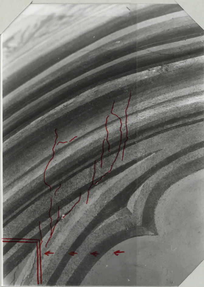
HIUSHALKEAMIA ETELÄISEN YLÄFRESKON YLÄPUOLELLA
