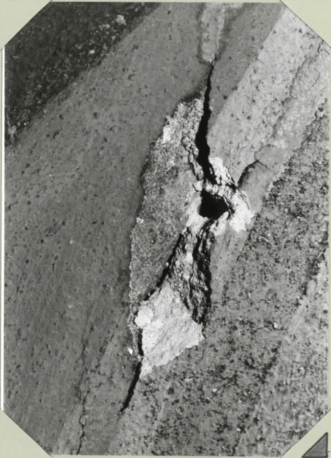
SEINÄN HALKEAMAAN PORATTUJA INJEKTOINTIREIKIÄ ETEL.YLÄFRESKON YLÄPUOLELLA
