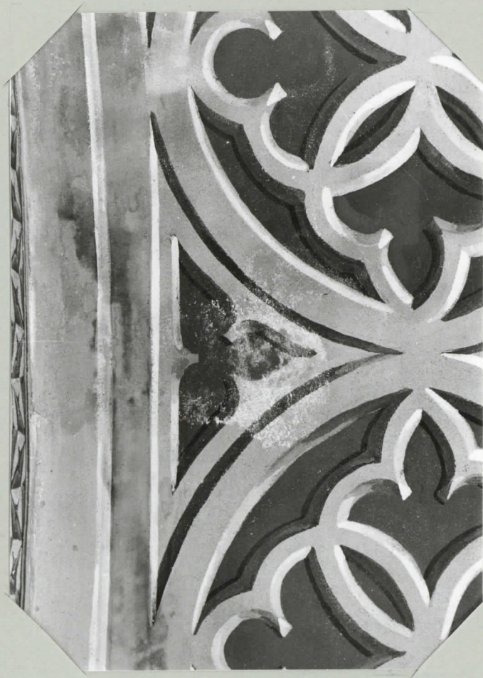
SUOLA - JA KOSTEUSVAURIOITA 4. FRESKOSSA
