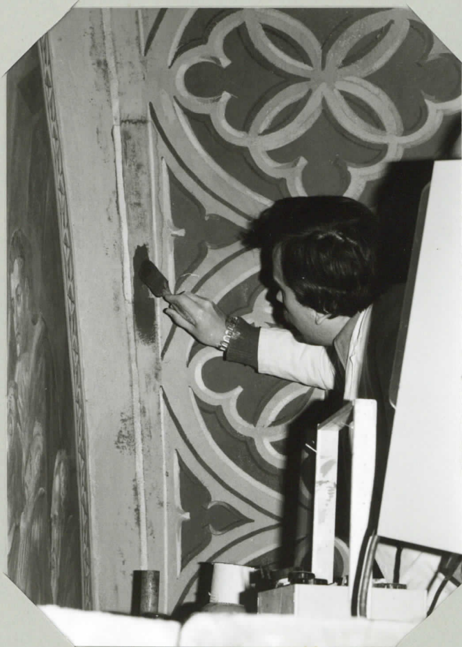
KOSTEUSVAURIOIDEN HÄIVYTYSTÄ KALKKIVÄREIN, SITÄ ENNEN VAURIOALUEET KÄSITELTY LIIVATELIUOKSELLA
