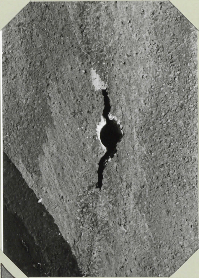
SEINÄN HALKEAMAAN PORATTUJA INJEKTOINTIREIKIÄ ETEL.YLÄFRESKON YLÄPUOLELLA
