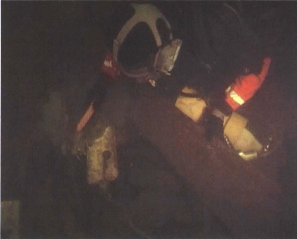
Kuva 9. Hapettuneen sinkkianodin "uudelleenaktivoiminen" harjaamalla oksidikerros pois anodin pinnalta (Kuva Pekka Paanasalo, Museovirasto)
