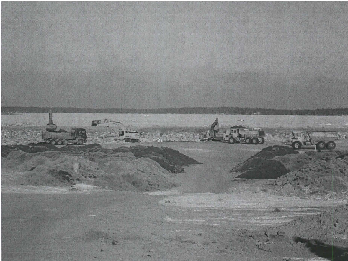
Muddrings- och bevakningsarbetet pågår i område C. Fotografi av Kari Pihlajanmäki, Servicecentret för samhällsteknik, Karleby stad.
