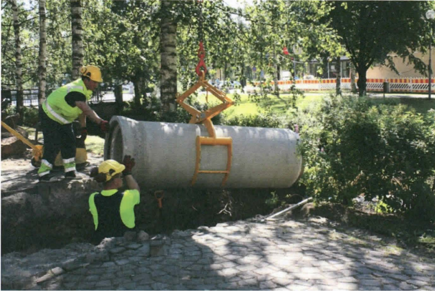
AKDG 3901:6. Hulevesiputkea asennetaan paikalleen Kaupunginojan varteen, luoteesta. Kuvaaja: Petro Pesonen.
