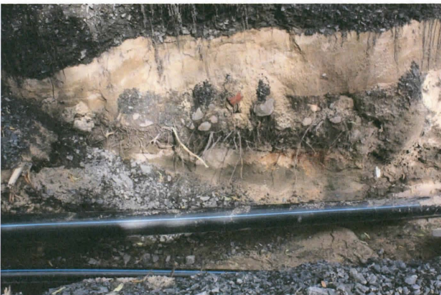
AKDG 3901:15. Puiston pohjoislaidan kaivannon profiilissa on pintamullan alla paksu hiekkakerros, sitten purkukerros ja alla puhdas pohjahiekka, lounaasta. Kuvaaja: Petro Pesonen.
