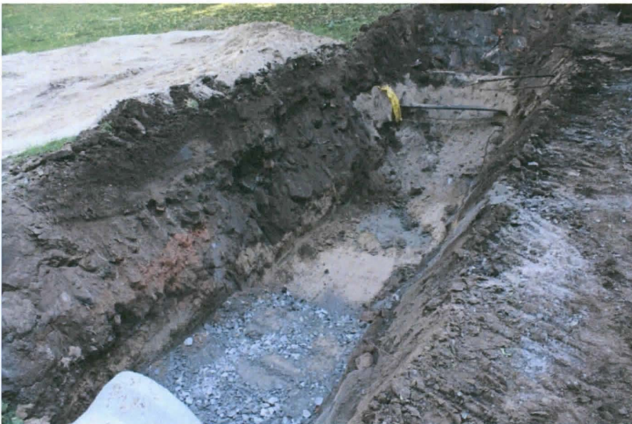
AKDG 3901:10. Hulevesiputken asennustapa, kaakosta. Kuvaaja: Petro Pesonen.
