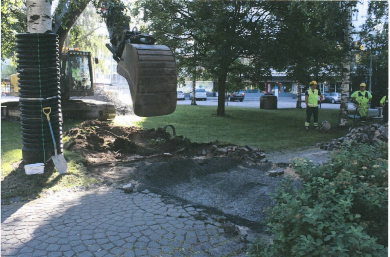
AKDG 3901:1. Kaivua aloitetaan poistamalla katukiveystä Kaupunginojan läheltä linjauksen lounaispäässä. Kuvattu lounaasta. Kuvaaja: Petro Pesonen.
