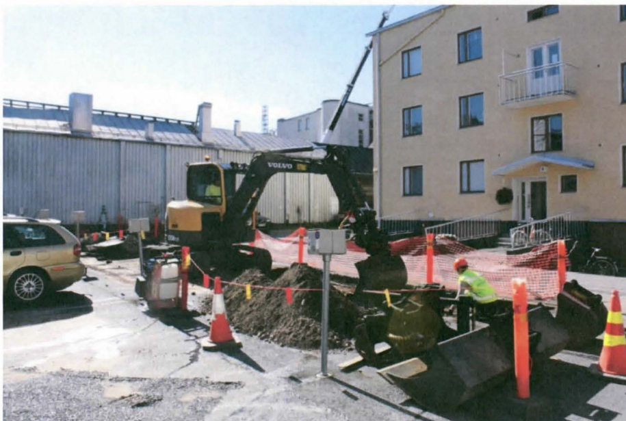
AKDG 3908:28. Koejaa 4 kaivetaan, luoteesta. Kuvaaja: Petro Pesonen.
