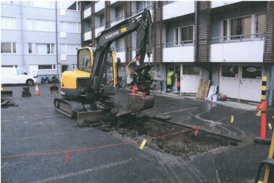
AKDG 3908:2. Asfalttia kuoritaan koeojasta 1, kaakosta. Kuvaaja: Petro Pesonen.
