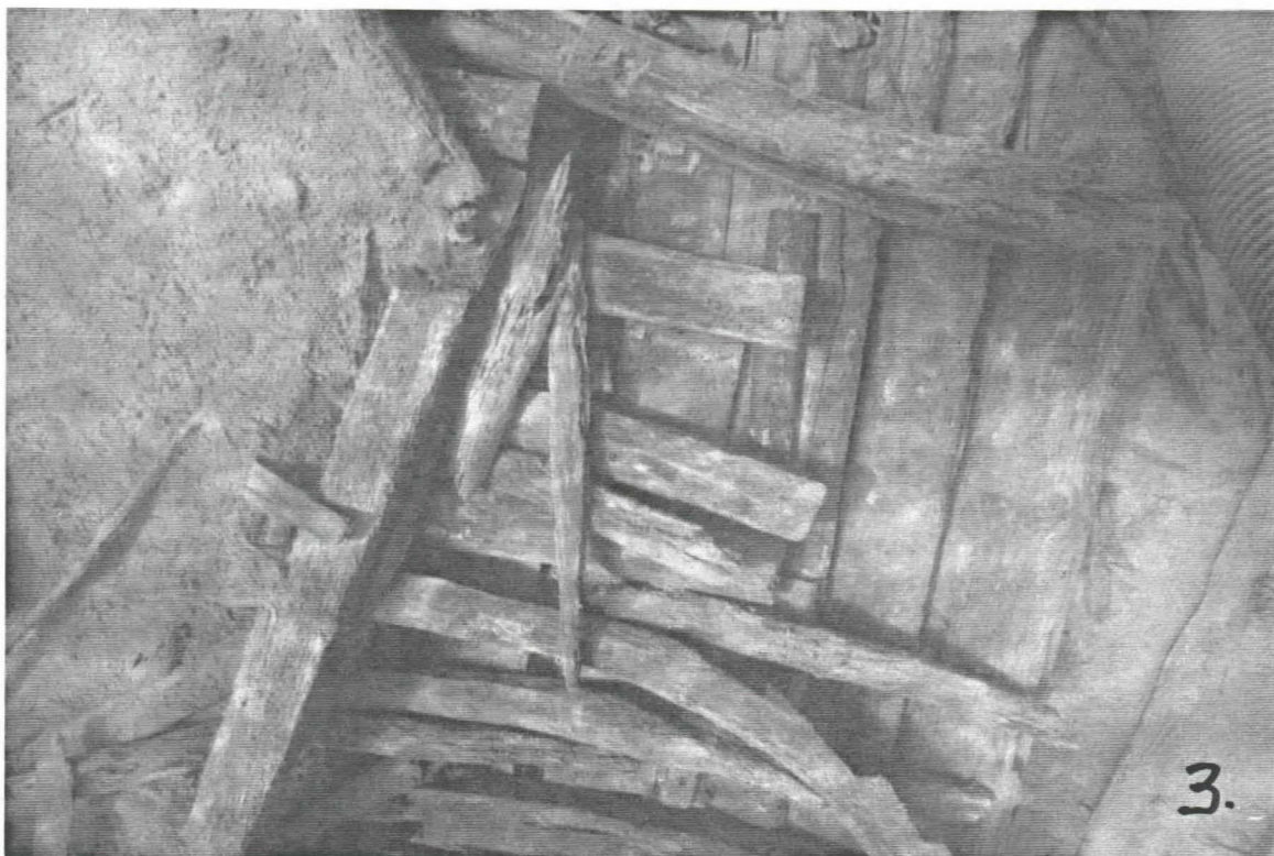
Kuva 3: Hyllyn keskivaiheilta puhdistettua oikeaa reunaa. Pohja rakennettu limilaudoituksella.
