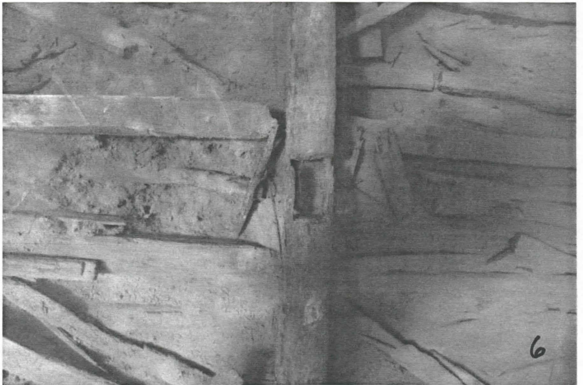
Kuva 6: Sama paikka lähempää kuvattuna.
