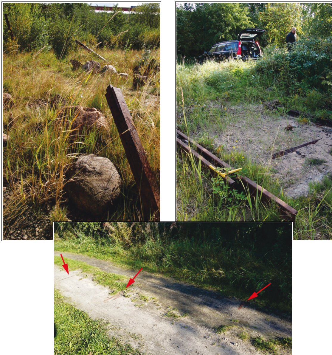
Kuvat 15-17. Laivanlaskuun käytetyn kiskorakenteen jätteet Varvinrannassa.
