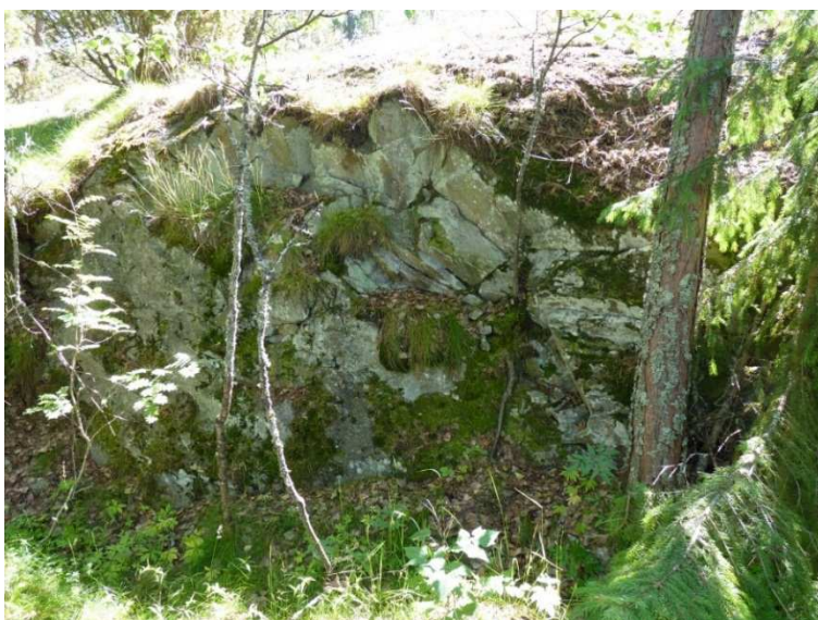
Kuva 128. Vanhaa louhintapintaa notkelman eteläpuolisessa kallioseinämässä Kuva pohjoisesta.
