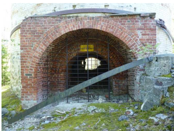
Kuva 154. Kilamon kalkkiuunin piipun alaosa. Kuvattu lännestä.
