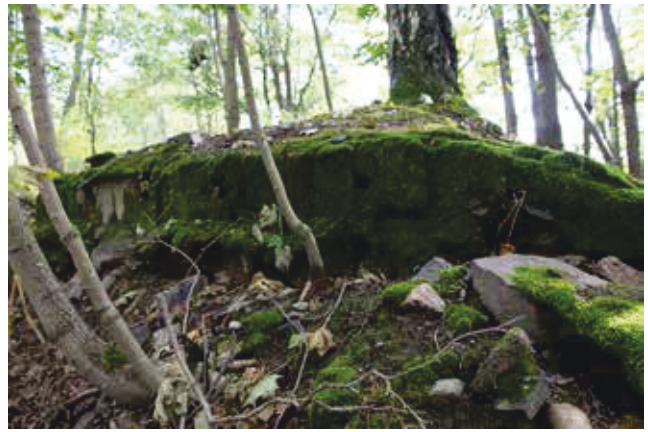
50. Rakenne 4, kellarimaisen rakenteen betonivalua, yksityiskoh- ta. NW-SE. 12.9.2014. Paula Kouki.
