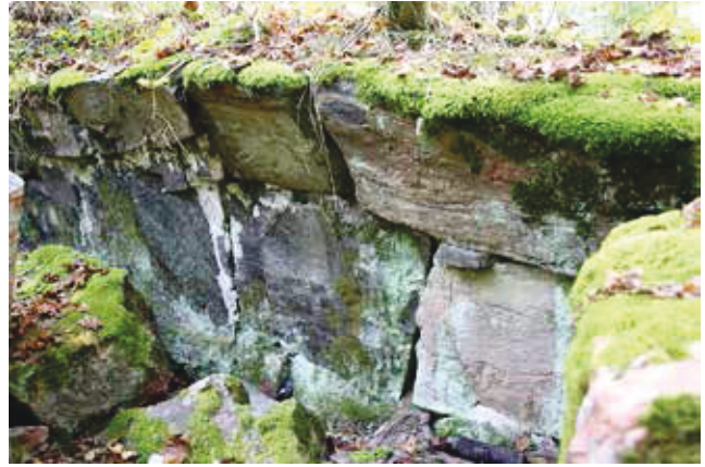
83. Rakenne 11, kellarin raunio puron rannalla Puustellinmäen länsiosassa, yksityiskohta holvauksesta. 15.9.2014. Paula Kouki.
