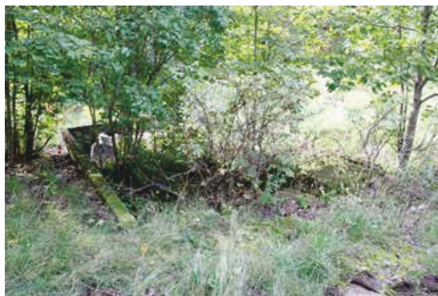
20. Rakenne 12, betonista valettu rakennuksen kivijalka. NE-SW. 9.9.2014. Paula Kouki.
