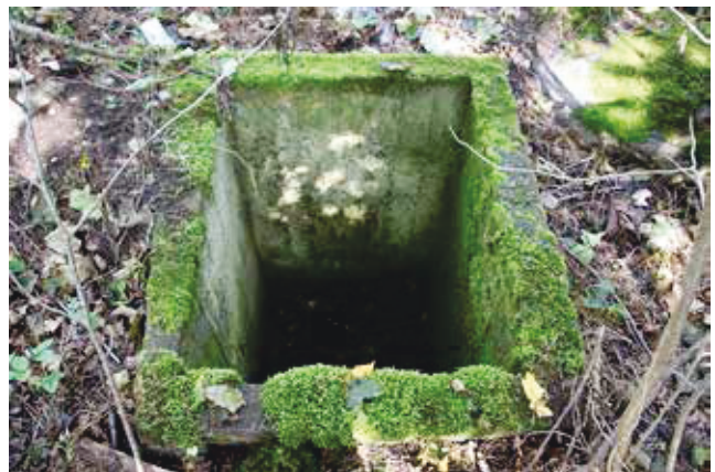
52. Betonista valettu kaivo välittömästi Rakenne 6:n pohjoispuo- lilla. SE-NW. 12.9.2014. Paula Kouki.
