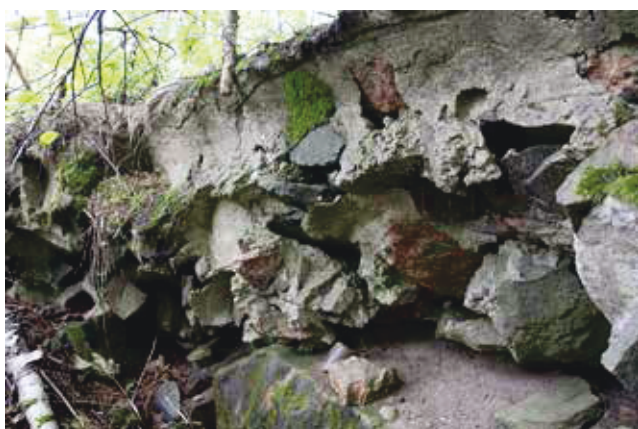
55. Rakenne 6, yksityiskohta: kivistä ja betonista valettua rakennetta. 12.9.2014. Paula Kouki.
