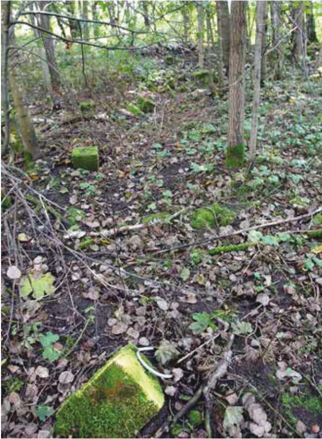
59. Rakenne 5, betonista valettuja anturoita, rakenteen itäreuna. N-S. 12.9.2014. Paula Kouki.
