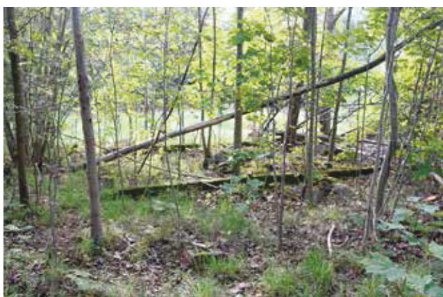
19. Rakenne 13, betonista valettu rakennuksen kivijalka. NE-SW. 9.9.2014. Paula Kouki.
