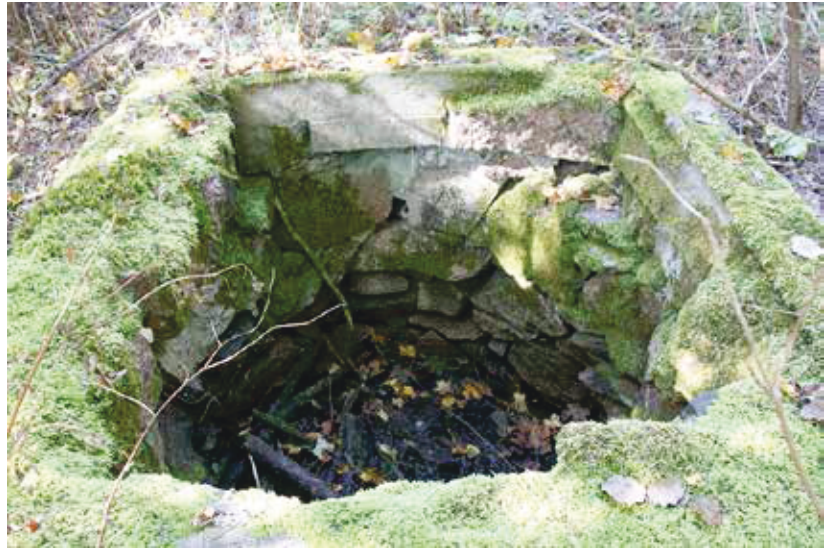
➔ Kuva 15: Rakenteen 2 pohjoispuolella sijaitseva kaivo.
