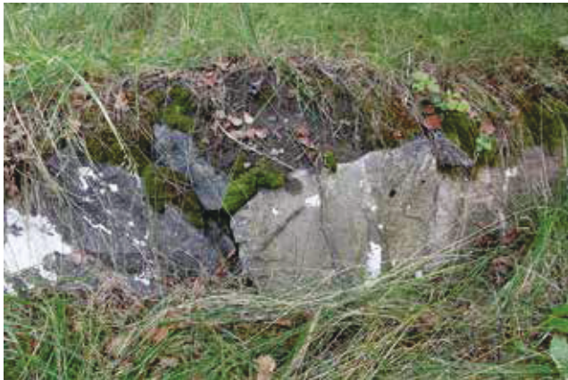
42. Rakenne 7, yksityiskohta: kalkkilaastin jäänteitä puustellin kellarin seinässä. S-N. 12.9.2014. Paula Kouki.
