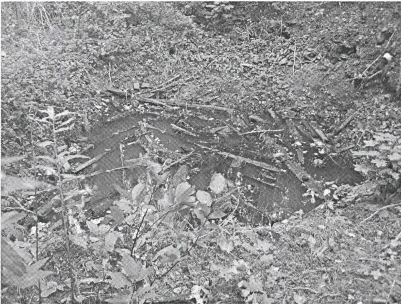
Kuva 4. Yksityiskohtakuva kaivoskuilusta. Pintaosiltaan roskaantunut mutta ilmeisesti täyttämätön kuilu ("no. 13" eli kartoituksissa huomioimaton, noin 40 m. syvä maanomistajan suorittaman luotauksen perusteella). Kuilu on ilmeisesti suunnitellun tiereittilinjauksen 1b linjalla tai sen välittömässä läheisyydessä. (ks. myös kuvat 9 ja 13). Kuilu sijaitsee tunnetusta kuilusta no. 12 länteen ja on matala, vetinen painanne maastossa.
