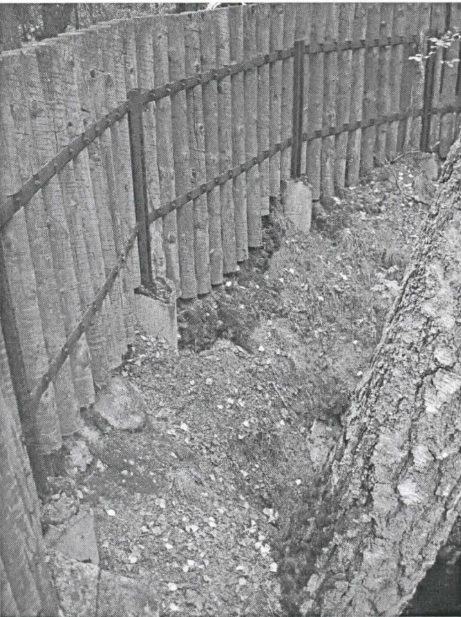
Kuva 12. Suoja-aidan metallirakenteet. Yksityiskohtakuva.
