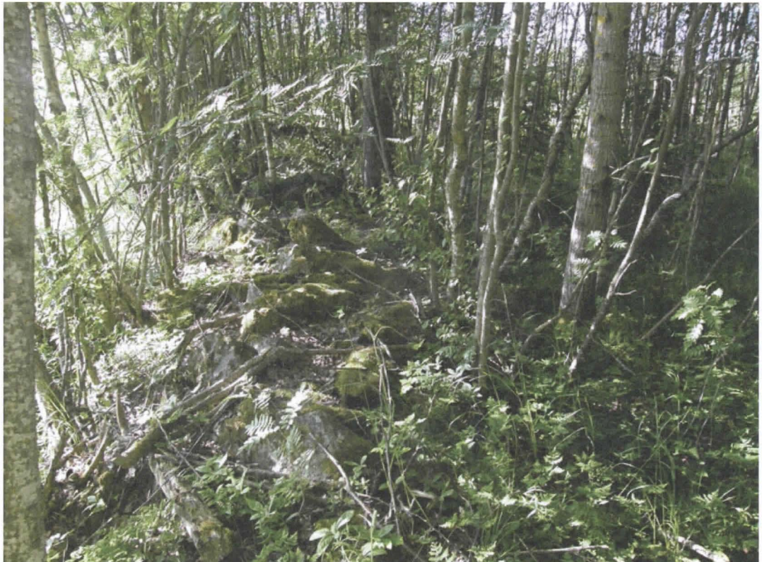
Foto 92. Stenmur, fotograferat från norr.
