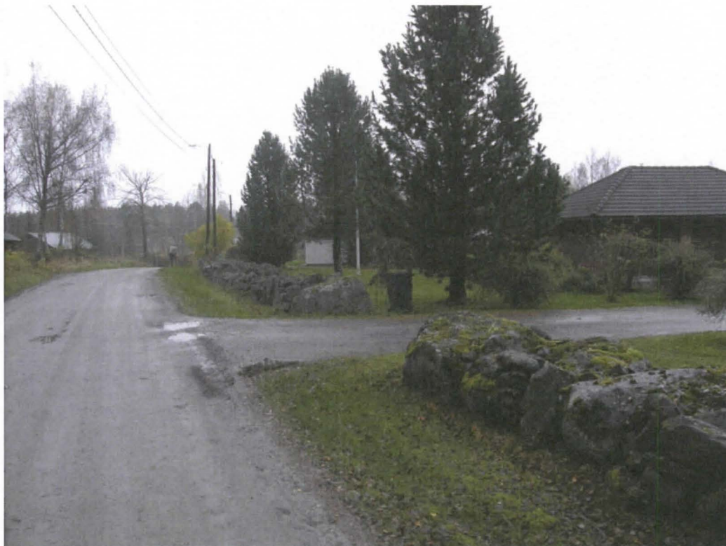
Foto 104. Stenvmur på östra sidan av Markusholmsvägen, fotograferat från sydöst.
