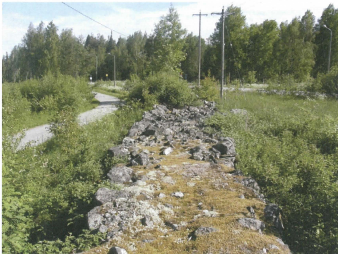
Foto 2. Stenmur, fotograferat från sydväst.
