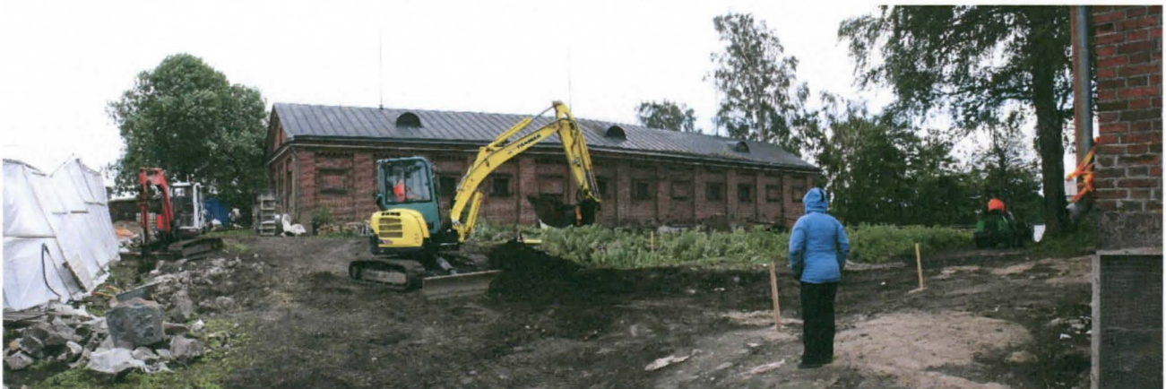
AKDG 3919:2. Kaivutyötä aloitetaan kivijalan luoteisnurkassa, luoteesta. Kuvaaja: Satu Koivisto.
