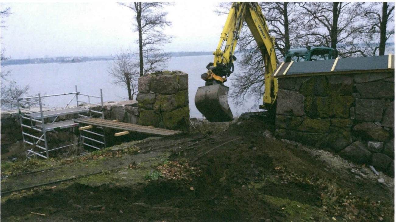
AKDG 3919:23. Kaapelikaivantoa tehdään varaston H5 pohjoispuolella, kaakosta. Kuvaaja: Petro Pesonen.
