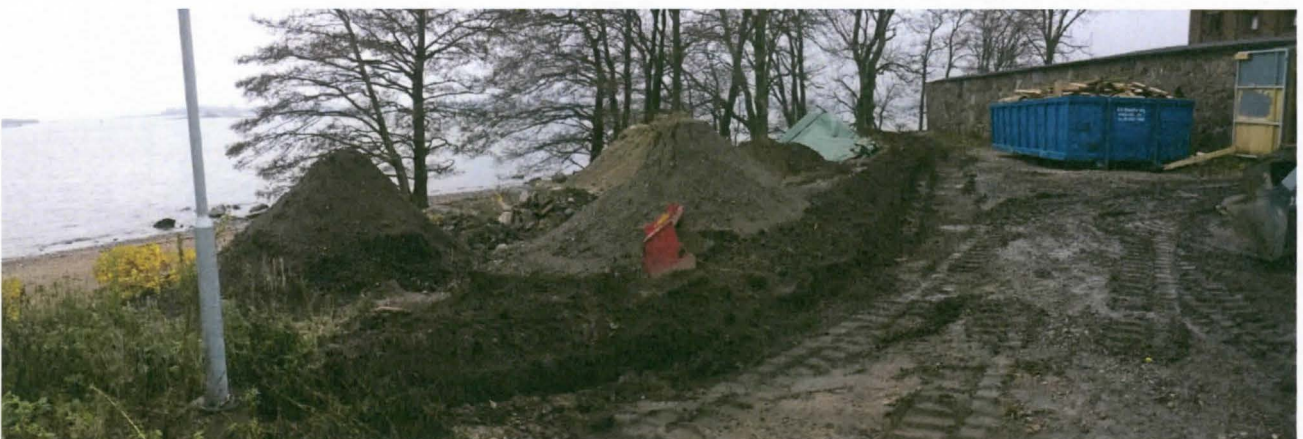
AKDG 3919:25. Saaren eteläosaan tehty kaapelikaivanto, idästä. Kuvaaja: Petro Pesonen.
