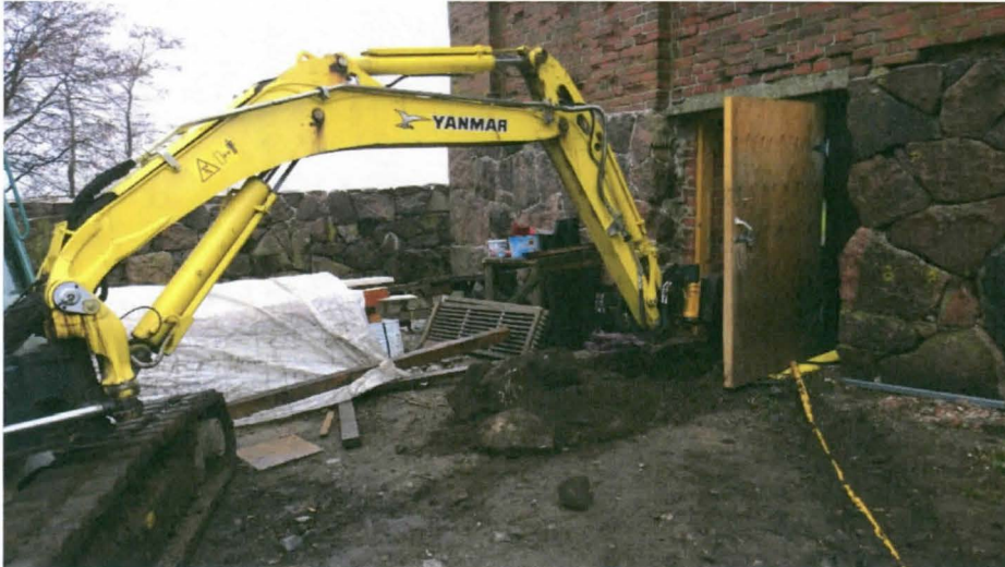
AKDG 3919:19. Rakennuksen H5 oviaukon edustalla kaivetaan, kaakosta. Kuvaaja: Petro Pesonen.
