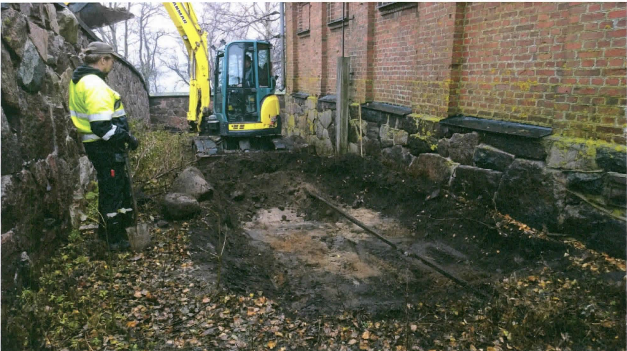
AKDG 3919:17. Kaivanto rakennuksen H3 itäseinustalla, pohjoisesta. Kuvaaja: Petro Pesonen.
