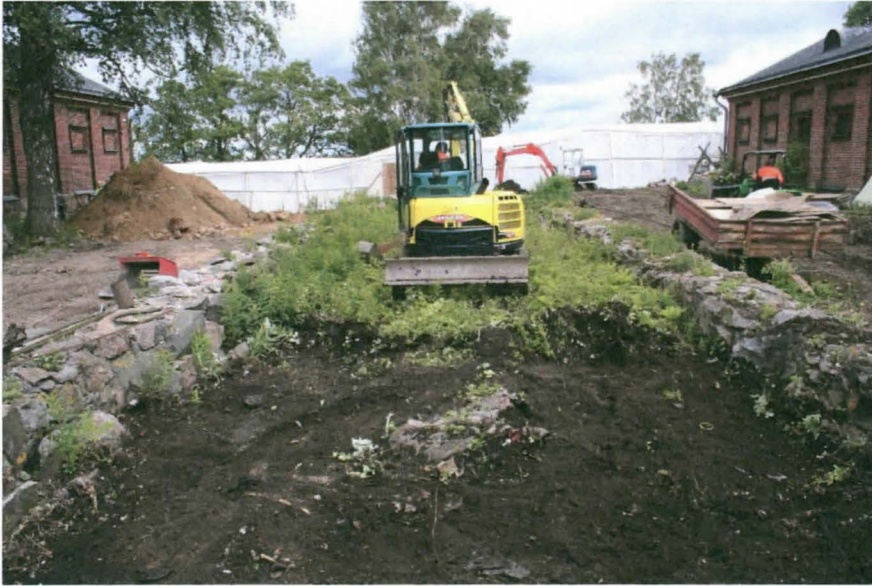
AKDG 3919:6. Kivijalan sisäosan kuorintaa, etelästä. Kuvaaja: Satu Koivisto.
