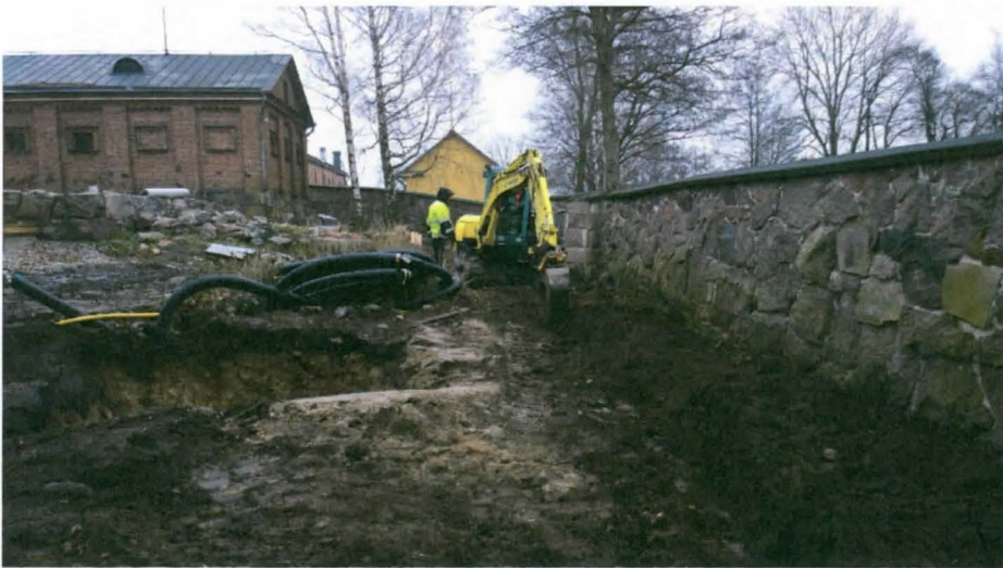
AKDG 3919:26. Kaapeli-kaivantoa muurin sisäpuolella, lännestä. Etualalla jätevesisäiliön kaivanto. Kuvaaja: Petro Pesonen.
