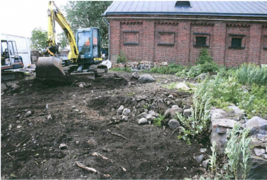
AKDG 3919:3. Vanhan kivijalan pohjoisreunalta paljastunutta ramppia, lännestä. Kuvaaja: Satu Koivisto.
