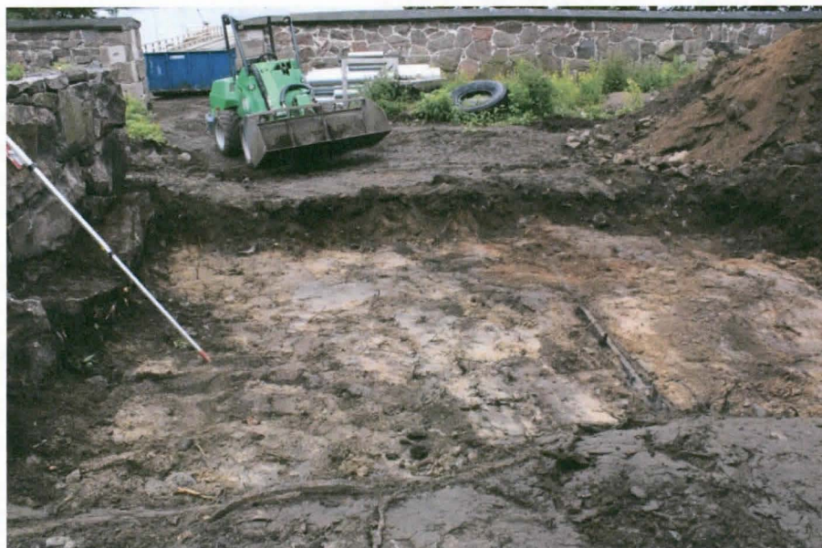
AKDG 3919:16. Lounainen kaivalue valmiina, pohjoisesta. Kuvaaja: Petro Pesonen.
