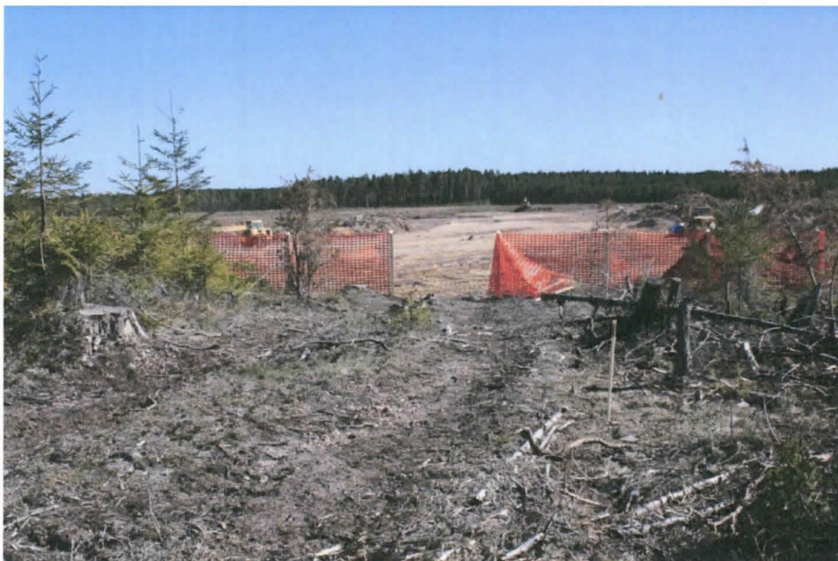
AKDG 3918:2. Työmaa käynnissä tulevalla läjitysalueella, lännestä. Kuvaaja: Petro Pesonen.
