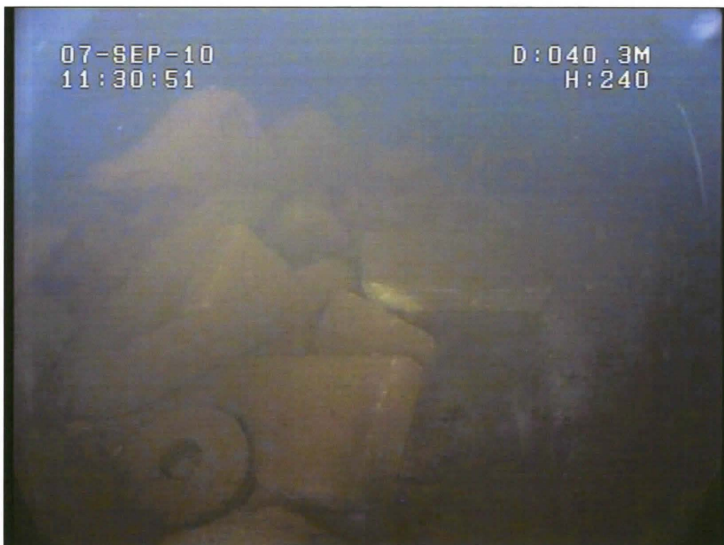
Seurantapiste 6. Pieni ruumanluukku, sisäpuolelta (tässä SB puolen sinkkiharkot). MA201014: 46 – 11:30:51 (DVD:n 4. videopätkä).
