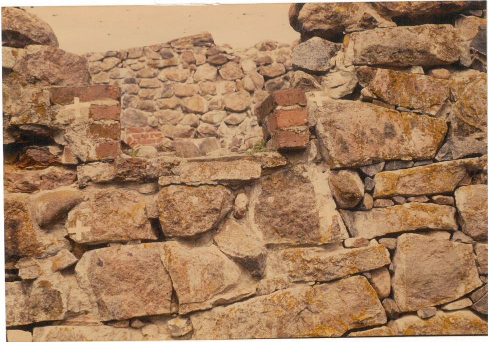
3018. Mittaravalo- kura S-huoneen etl. ulko- seinän ikkuna- aukon ympäri- työstä. Suunta: etelä.
