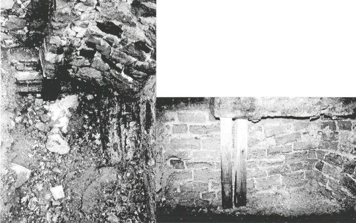
Alueen itäpää pohjaan kaivettuna ja itäpää puhdistettuna
