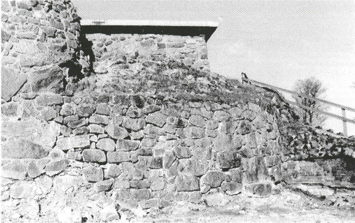
Esilinna III:n länsimuurin pohjoisosa
