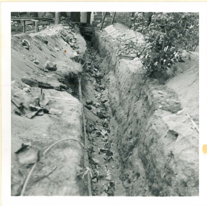
Sakaristosta koilliseen kaivettu lämpöjohtokanava
