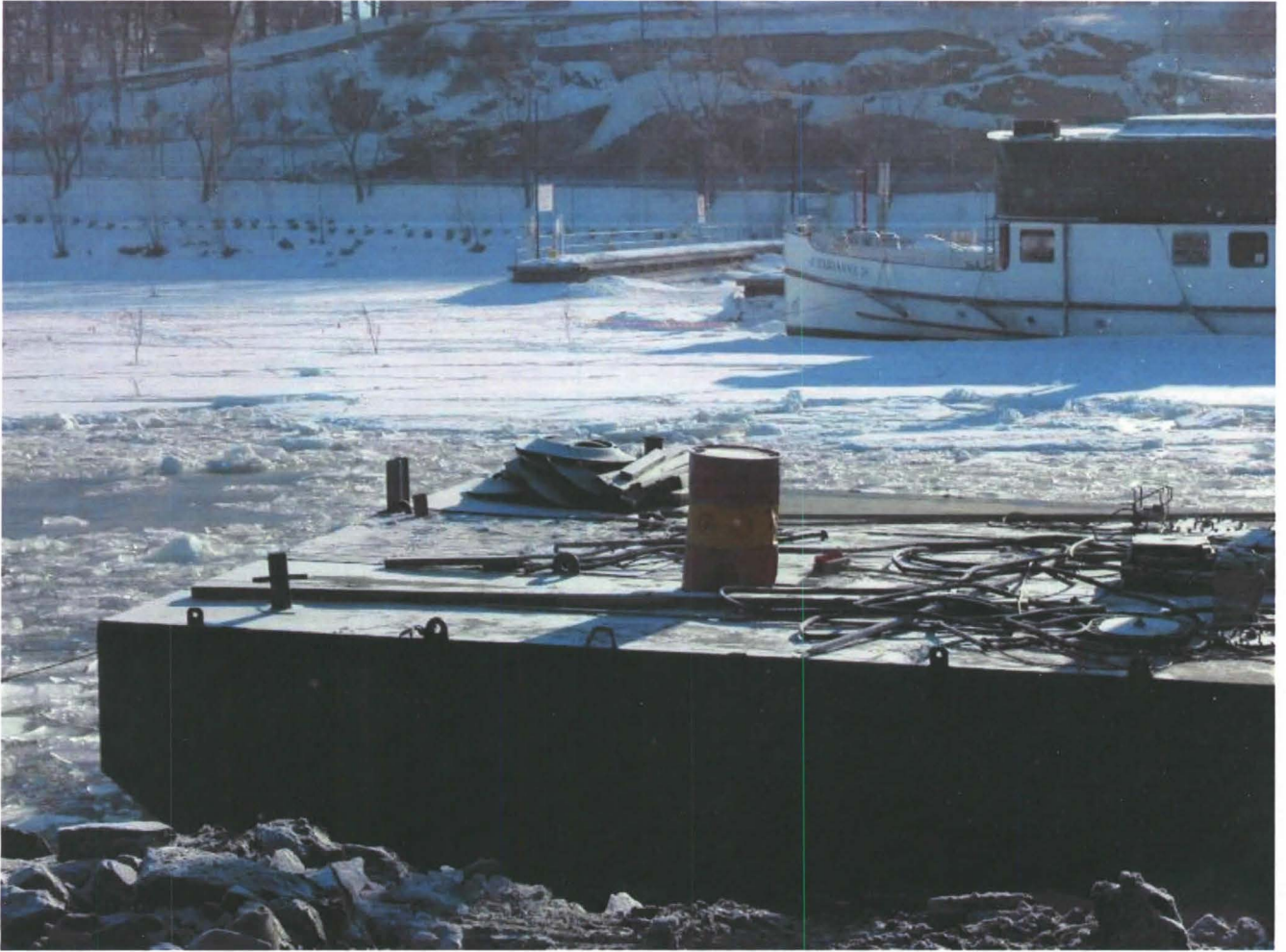
3. Kaaripuiden löytöpaikalle rakennetun polttoaineen jakeluaseman rakenteita maaliskuussa 2004.
