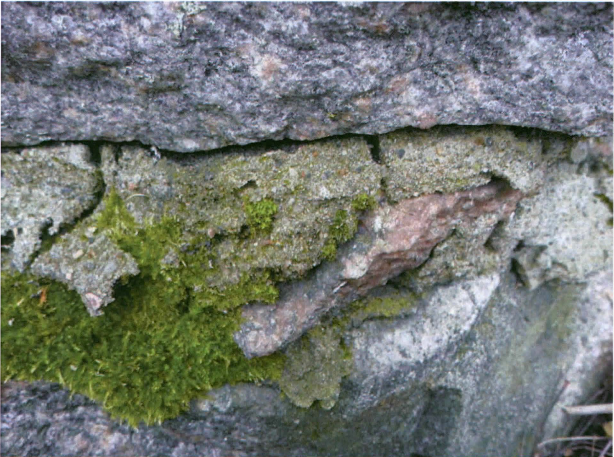
Kuva 18: Kohde 13. Detalji: kaakkoispäädyn perustuspylvään sementtiä.
