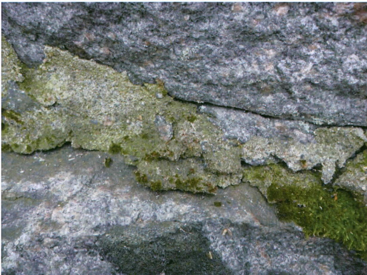
Kuva 17: Kohde 13. Detalji: kaakkoispäädyn perustuspylvään sementtiä.
