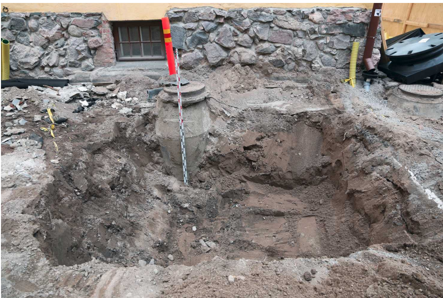
Kuva 130. Puun istutuskuopan pohjois-, itä- ja eteläprofiilit. Kuopan pohjoispuoliskossa latan takana sijaitsevan rasvanerotuskaivon vasemmalla puolella on tummempaa hiekkaa ja rakennusjätettä. Tämä johtuu koska kohtaan oli kaivettu aiemmin rakennustöiden aikana puunistutuskuoppa, joka täytettiin myöhemmin. Rasvanerotuskaivon eteläpuolella on yhtenäistä vaaleanruskeaa täyttöhiekkaa liittyen eteläpuolisen maanalaisen tallin ja kaivojen rakentamiseen 1980-luvulla. Oikealla on jätevesikaivo. Kuvaussuunta E. 8.10.2014.
