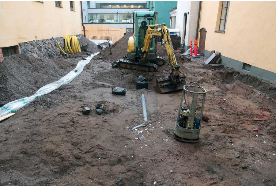
Kuva 85. Sadevesikaivot ja -viemäriputki on asennettu. Kuvaussuunta S. 22.9.2014.
