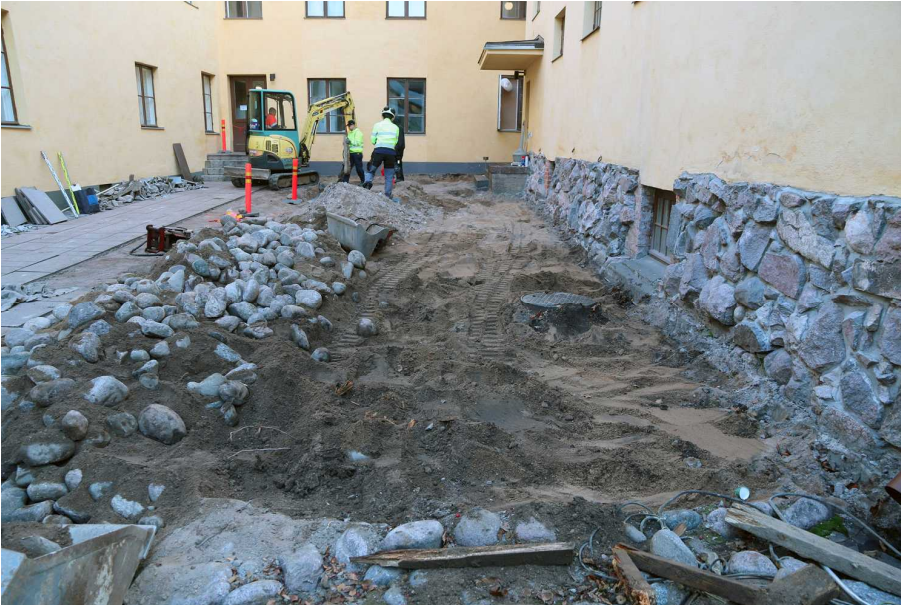
Kuva 90. Pihan itäisivulta on poistettu mukulakivet. Kuvan oikeassa alanurkassa on jätevesikaivo ja taaempaa rasvanerotuskaivo. Kuvan keskellä edessä on poistetun puun kohta. Kuvaussuunta N. 15.9.2014.
