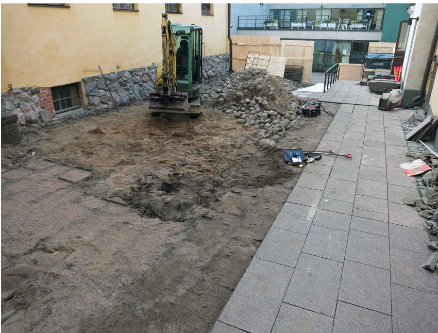
Kuva 33. Pihan keskiosaan tulevien sadevesikaivojen kohdalle tehtiin kuvan keskelle pohjoinen koekuoppa (kartoitustaso 2). Sen länsireuna meni jo kuvassa poistettujen laattakivien itäreunan kohdalla. Sen länsiosassa meni avonaisen sadevesikourun linja (näkyvä kuvassa taaempana kivien alla) ja valotolppien kaapeli. Kuvaussuunta SE. 12.9.2014.
