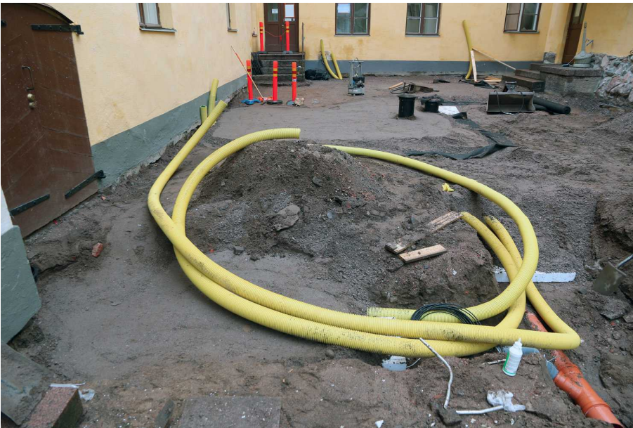
Kuva 110. Edelliseen kohtaan on asennettu kaapeleiden suojaputkia. Kuvaussuunta N. 25.9.2014.
