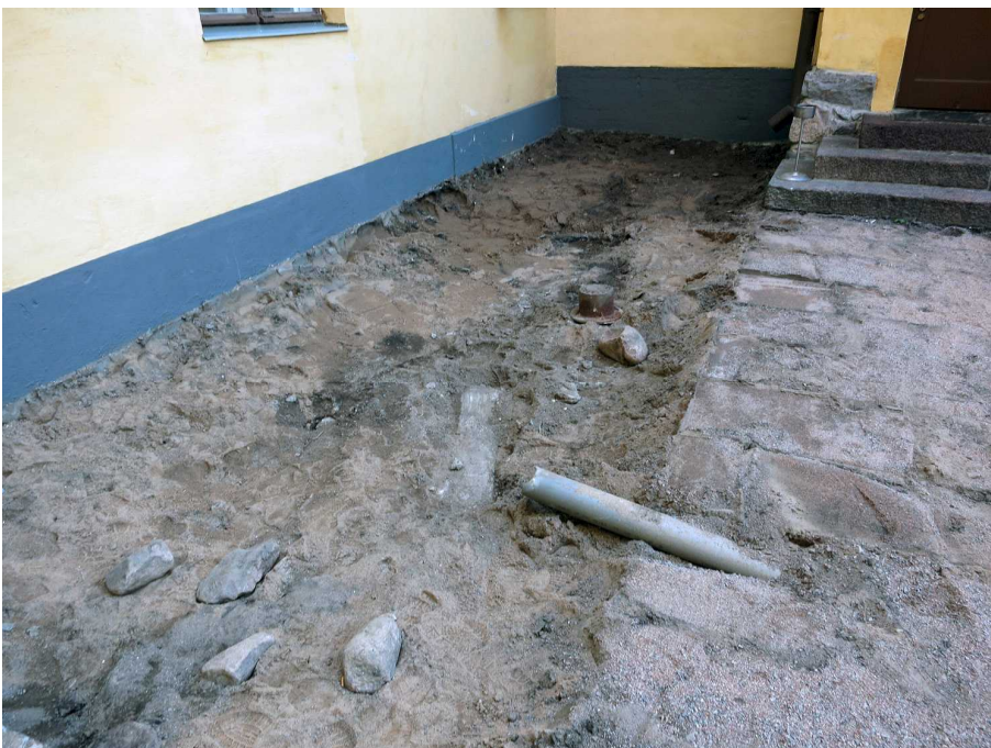
Kuva 11. Pihan pohjoisosasta on poistettu etupäässä mukulakivet, laattakivet ja betoniset sadevesikourut ja jonkin verran mukulakivien alapuolista hiekkaa. Edessä näkyy laattakivikäytävän alitse mennyt sadevesiviemäriputki. Kuvaussuunta NE. 12.9.2014.
