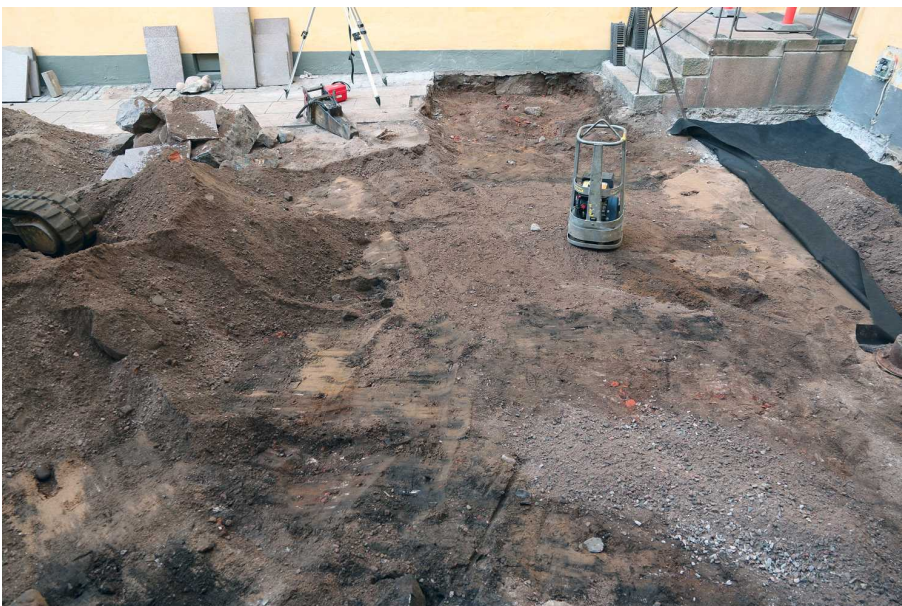
Kuva 31 Edellinen kohta. Pihan rakennekerron tarvitsema syvyys on melkein tavoitettu. Edessä pohjalla on sekoittunutta hiekkaa rakennusjätteineen ja tummine kerroksineen. Taaempänä on yhä laattakerroksen alapuolista uudempaa soraa ja sekoittunutta hiekkaa. Kuvaussuunta W. 19.9.2014.
