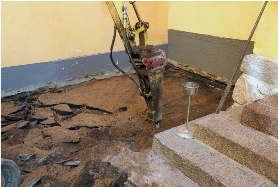
Kuva 13. Pihan koilliskulmassa yhtenäisen hiekkakerroksen alta tuli esiin paksu asfalttikerros, jota piikataan kuvassa rikki. Kuvaussuunta NE. 15.9.2014.
