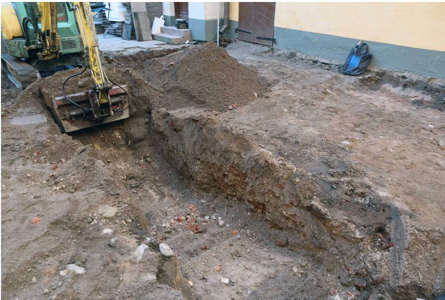
Kuva 105. Sadevesikaivoista kaivettiin putkea varten pitkä ja aikaisempaa syvämpi ja leveämpi kaivanto, keskilinjän kaivanto, N-S – suunnassa pihan eteläosaan. Kaivannon alaosassa näkyi vain rakennusjätettä. Ylempänä oli tummempaa hienompaa ainesta. Vanhemman pihakiveyksen irtokivikerrosta ei ollut alueella. Kuvaussuunta SW. 24.9.2014.
