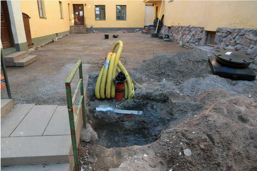
Kuva 134. Pihan eteläosa kohdassa, johon tuli sähkökaivo. Kuvaussuunta N. 17.10.2014.
