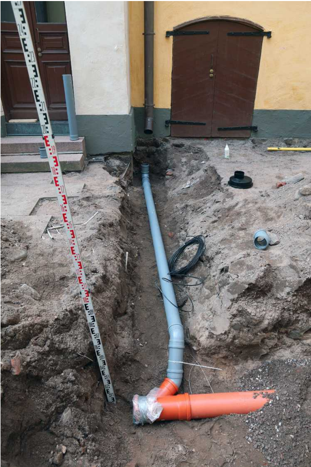
Kuva 120. Länsireunan sadevesiputkikaivantoon on asennettu viemäriputki. Kuvaussuunta W. 24.9.2014.
