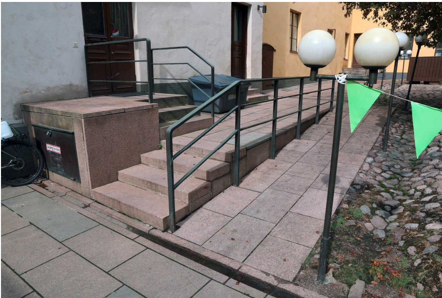
Kuva 4. Pihan lounaisosan portaat, kulkuluiska, valaisinrivi ja avonainen sadevesikouru. Valkoiseen Helleniuksen sivurakennukseen johtaa kaksi portaikkoo ja sisäänkäyntiä. Kapeamman keltaisen rakennuksen eteläpäässä on sisäänkäynti Helleniuksen länsisiiven kellariin. Pihan eri portaita ei purettu. Kuvaussuunta NW. 26.8.2014.
