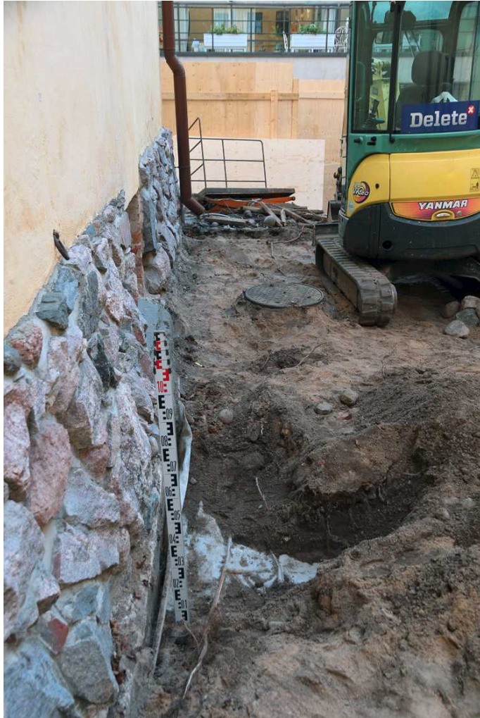
Kuva 92. Pihan itäsiivu rasvanerotuskaivon pohjoispuolella. Sumpun seinän juurella oli seinää vasten 30 korkeudelta ja 40 cm:n syvyydessä 75 cm leveydeltä plastiikka. Plastiikan takana seinässä oli tasainen betonisilote. Kuvaussuunta S. 15.9.2014.
