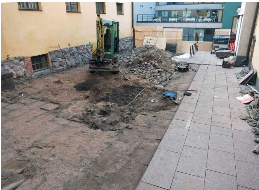
Yleiskuva pohjoisesta koekuopasta mukalakiveyksen vaalean laskuhiekkakerroksen poiston jälkeen. Esillä on tumma kerros, jossa on irtonaisia mukalakivä (kartoitustaso 3). Kuvaussuunta SE. Kuva: Heini Hämäläinen. HKM/Helsinki, Hellenius 2014:35.
