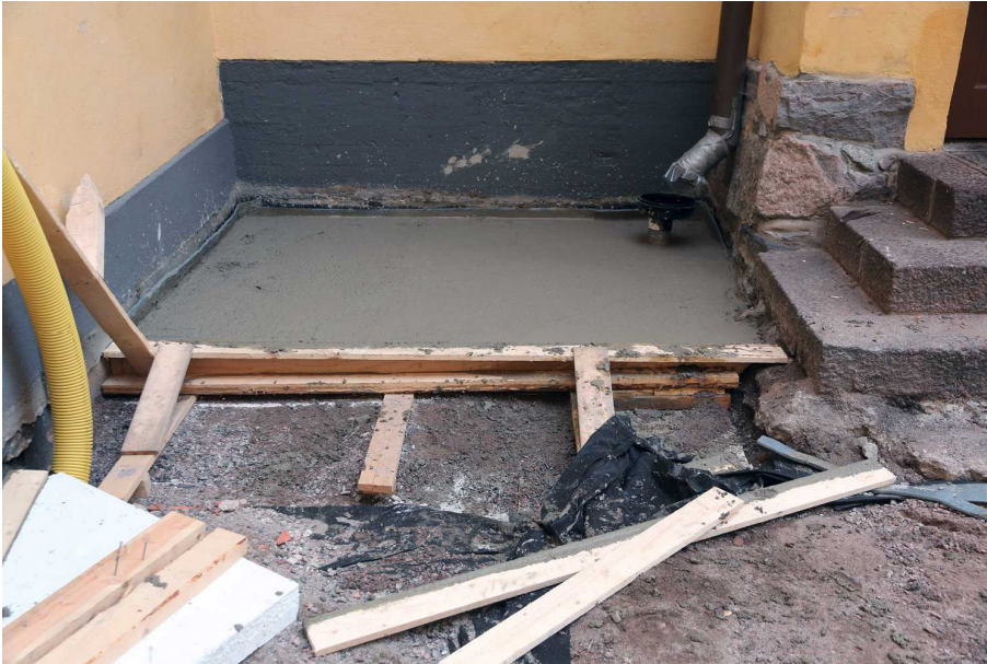
Kuva 29. Koilliskulman portaikon pohjan betonointi kuivumassa. Kuvaussuunta E. 3.10.2014.
