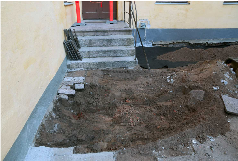
Kuva 21. Luoteisnurkan portaikon edusta käytävän laattakivien ja niiden melko paksun laskusorakerroksen poiston jälkeen. Seinän vierustalla oli kapea kaista nupupihakiveystä. Kuvaussuunta N. 19.9.2014.
