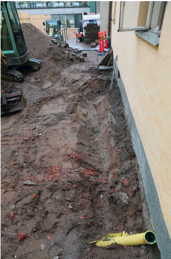
Kuva 87. Pihan länsireunaan sähkökaapeleiden suoja-putkien takia kaivettu syvämpi ura. Havaintopiste 3 sijaitsi myöhemmin etumaisen ikkunan kohdalla. Kuvaussuunta S. 22.9.2014.
