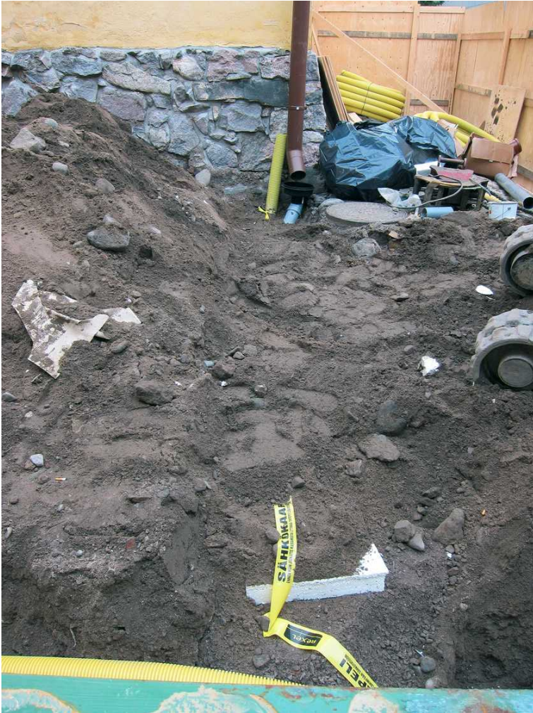
Kuva 126. Sadevesiputki on asennettu ja peitetty. Kuvaussuunta E. 26.9.2014.
