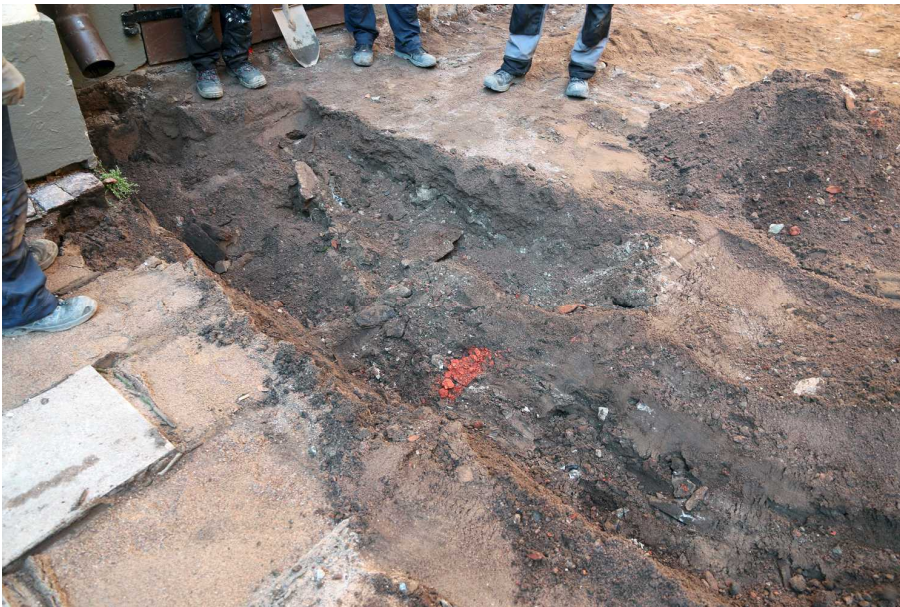
Kuva 116. Pihan länsireunan sadevesiviemärikaivantoa kaivetaan hiekkaiseen rakennusjätterrokseen. Kuvaussuunta NW. 24.9.2014.
