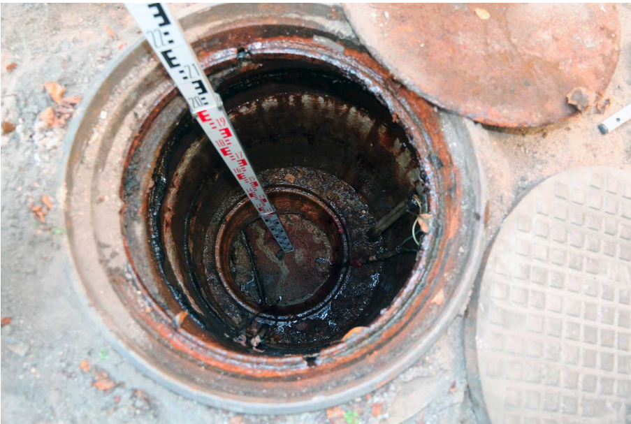
Kuva 121. Pihan kaakkoisosan rasvanerotuskaivo. Kuva päältä, kuvaussuunta W. 16.9.2014.
