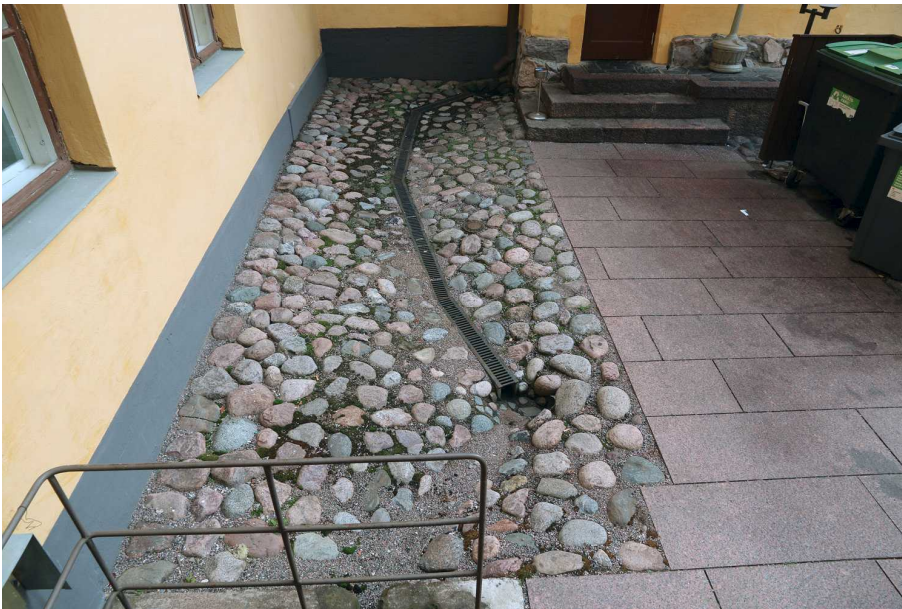
Kuva 7. Pihan pohjoisosassa oli mukulakiveys, jonka keskellä oli metalliritilöiden alla kaareva sadevesikouru. Pihan koilliskulman Sumpun portaille johti laatoitettu reitti, jonka eteläpuolella oli jätelaatikot. Kuvan vasemmassa alakulmassa on nostotason kaiteet. Kuvaussuunta E. 26.8.2014.
