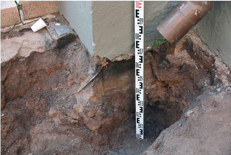
Kuva 118. Edellinen tilanne. Syöksytorven rännikaivon kohta rakennuksen kulmassa. Kuvaussuunta SW. 24.9.2014.
