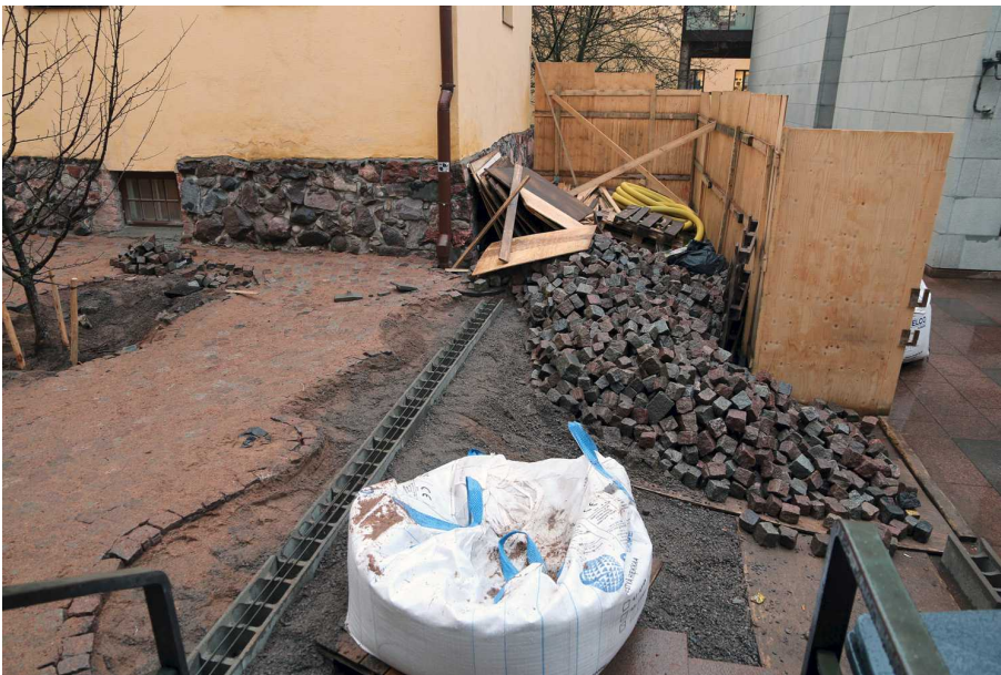
Kuva 140. Pihan eteläreuna. Kiveämätön alue jäi vielä tehtäväksi seuraavassa työvaiheessa. Kohdalle tuli tilapäinen puinen kulkuluiska. Kuvaussuunta E. 6.11.2014.
