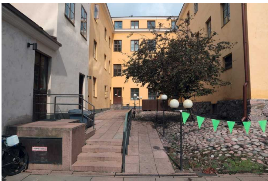
Helleniuksen piha ennen pihan korjausta. Kuvaussuunta N. Kuva: Markku Heikkinen, HKM/Helsinki, Hellenius 2014:3.
