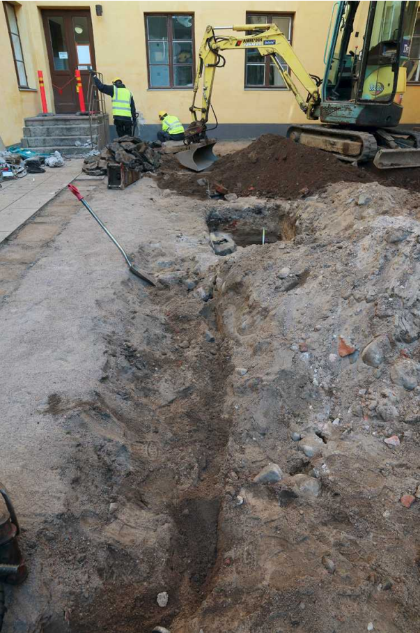
Kuva 94. Pohjoisen koekuopan lounaispuoli. Syvemmän kohdassa on sijainnut avonainen vesikouru. Kuvaussuunta N. 16.9.2014.
