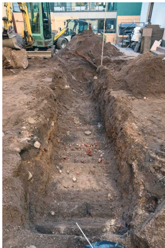
Keskilinjän kaivanto pihan keskiosassa pihan entisen kulkuluiskan alkuun saakka, jota ennen rakennusjätekerrokset vaihtuivat tasalaatuisiksi täyttöhiekoiksi. Kuvaussuunta S. Kuva: Markku Heikkinen. HKM/Helsinki, Hellenius 2014:108.
