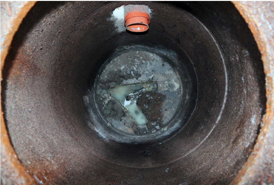
Kuva 123. Sisäkuva edellisestä. Uutta sadevesiviemäriputkea varten on tehty aukko kaivon seinään. Kuvaus päältä, kuvaussuunta W. 3.10.2014.
