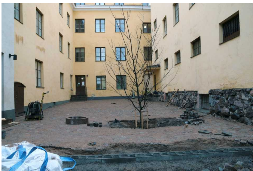
Pihan kiveys on valmistumassa. Edessä näkyy kiveyksen etelärajan rakenteet Sumpun eteläseinän linjalla. Kuvaussuunta N. Kuva: Markku Heikkinen. HKM/Helsinki, Hellenius 2014:140.
