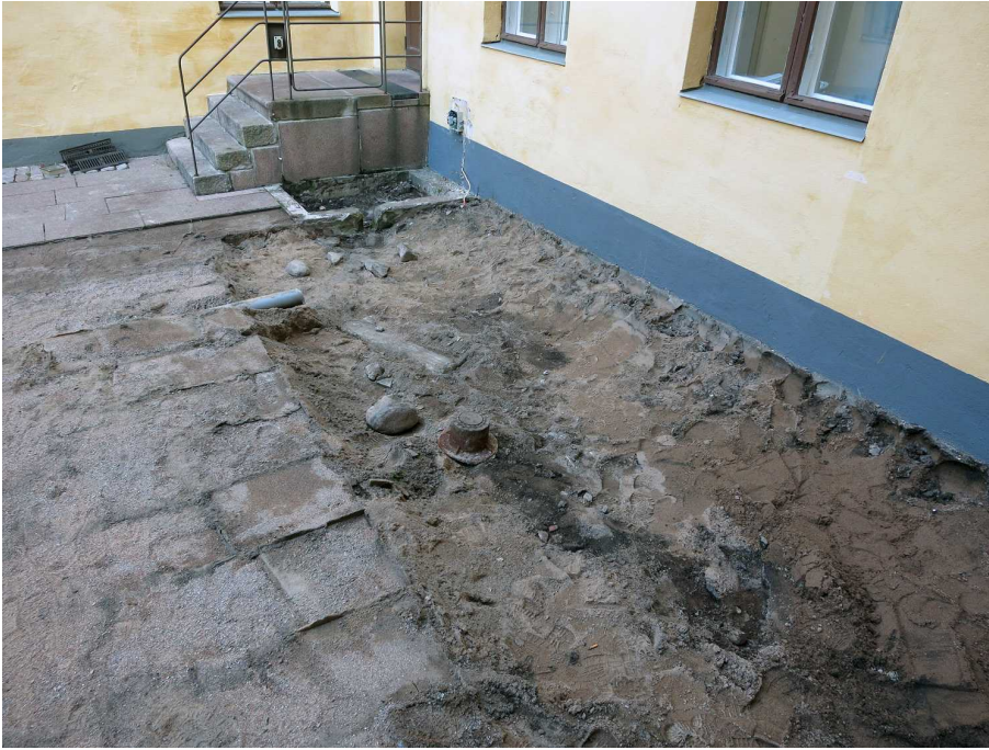
Kuva 12. Edellinen tilanne. Portaiden vieressä näkyy betoninen rakenne, joka oli nostotason perustukset. Kuvaussuunta NW. 12.9.2014.
