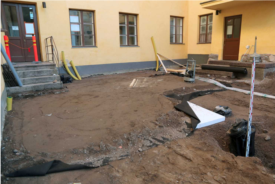
Kuva 86. Oikealla näkyvät sadevesikaivot. Soran ja kankaan alla olevat styroksilevyt laitettiin vain sadevesiviemäriputken kohdalla. Pihan pohjoisosaan on laitettu sorat. Kuvaussuunta NE. 24.9.2014.
