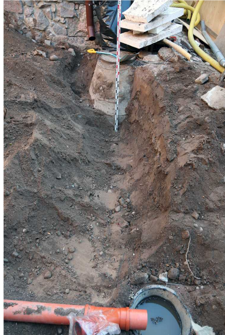
Kuva 127. Sadevesiputkilinja on kaivettu uudelleen esiin ja laajennettu etelään päin muuttuneiden suunnitelmien takia. Kuvaussuunta E. 2.10.2014.
