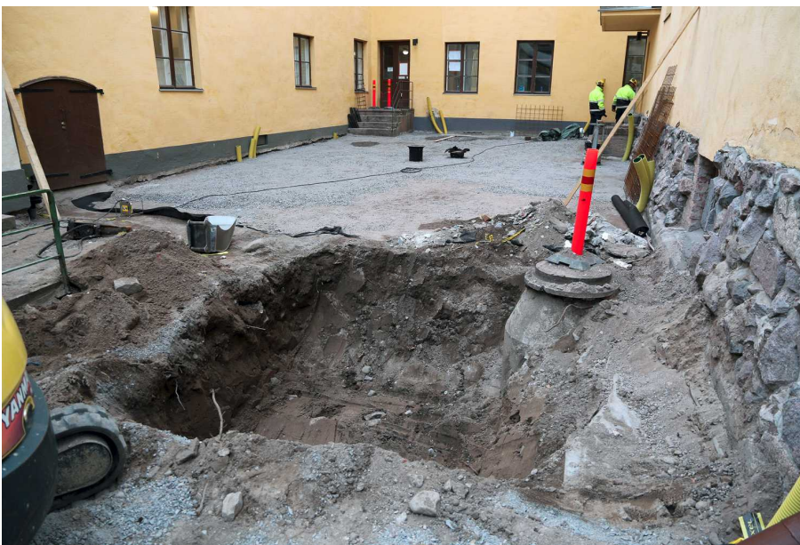
Kuva 129. Pihan kaakkoisosan tulevaa puuta varten on kaivettu suuri istutuskuoppa. Kuvaussuunta NNW. 8.10.2014.
