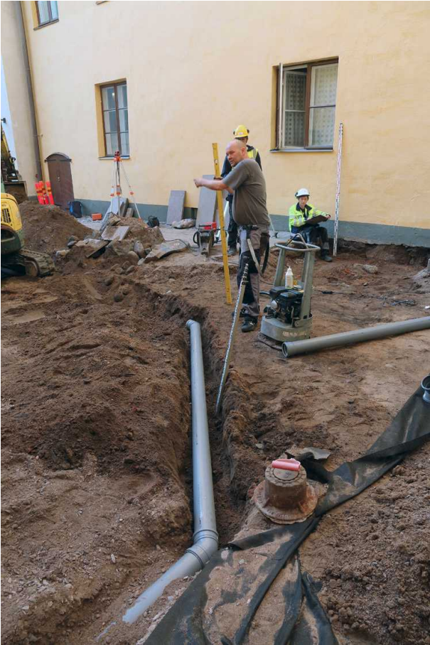
Kuva 27. Sadevesiviemäriputkea asennetaan edellisen kohdan lounaispuolelle. Kuvaussuunta SW. 19.9.2014.
