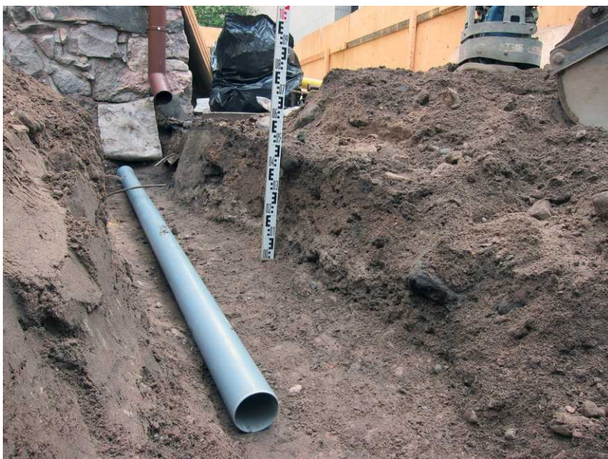
Kaakkoisen sadevesiviemäriputken kaivanto. Havaintopiste 7. Kuvaussuunta E. Kuva: Heini Hämäläinen. HKM/Helsinki, Hellenius 2014:125.
