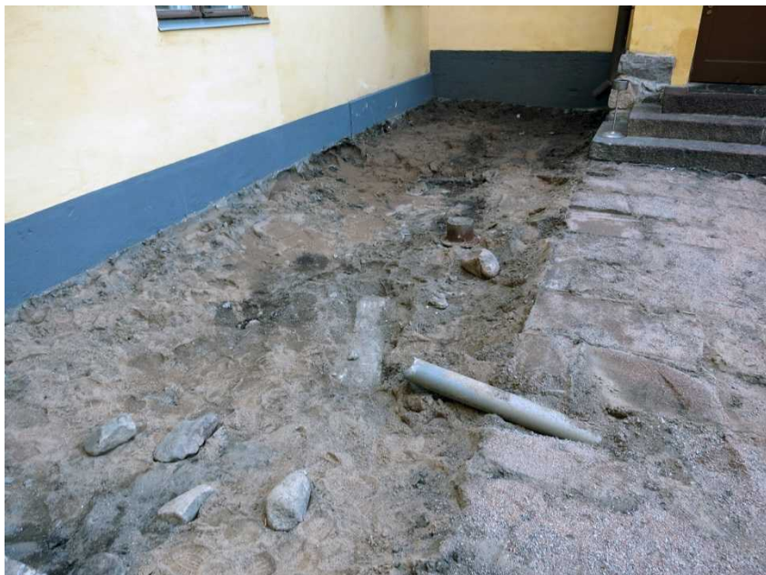
Pihan pohjoisosasta on poistettu mukulakivet, laattakivet ja betoniset sadevesikourut ja jonkin verran mukulakivien alapuolista hiekkaa. Edessä näkyy laattakivikäytävän alitse mennyt sadevesiviemäriputki. Kuvaussuunta NE. Kuva: Heini Hämäläinen. HKM/Helsinki, Hellenius 2014:11.
