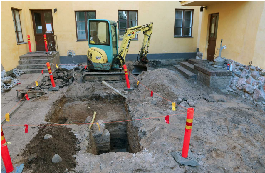
Kuva 76. Pohjoinen koekuoppa ja pohjoinen laajennusosa. Kuvaussuunta N. 16.9.2014.
