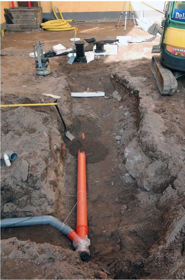
Kuva 109. Keskilinjän kaivantoon on asennettu sadevesiviemäriputki. Taustalla näkyy sadevesikaivot. Vasemmassa alanurkassa on pihan länsireunan sadevesiputken kaivanto ja viemäriputki. Kuvaussuunta N. 24.9.2014.
