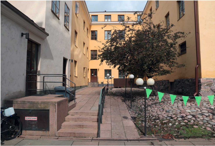
Kuva 3. Helleniuksen piha ennen korjaustöitä. Lähes kaikki kuvassa näkyvät pihan pintarakenteet ja kalusteet poistettiin kuten myös kuvan puu. Kuvaussuunta N. 26.8.2014.
