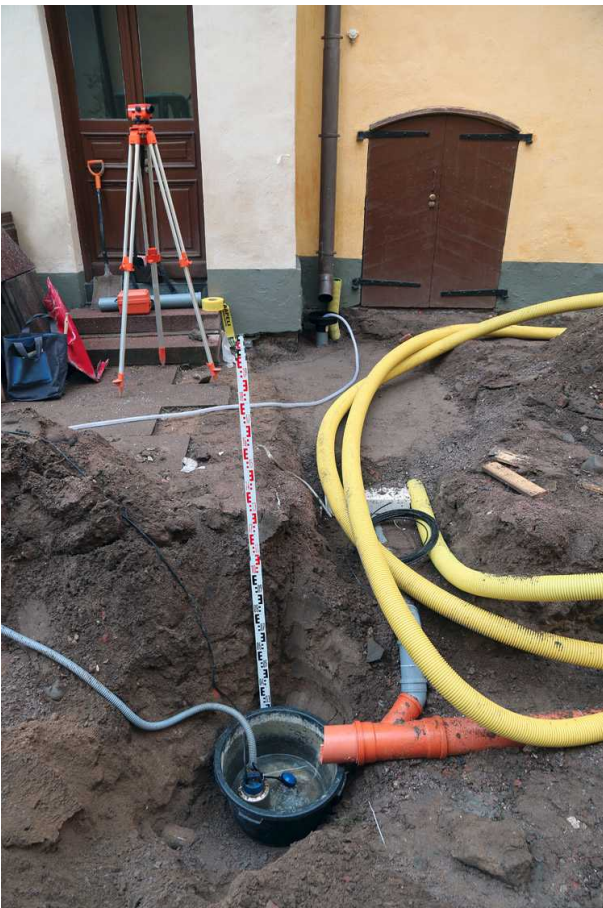
Kuva 112. Tilapäinen "kaivo" pumppuineen. Kuvaussuunta W. 25.9.2014.
