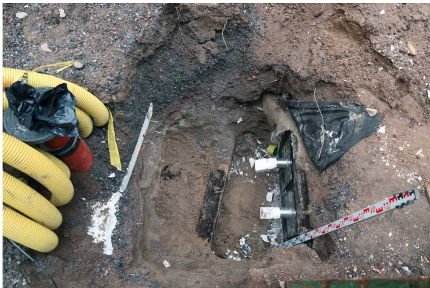
Pihan sähkökaivon kohta. Latan kohdalla näkyy kaupungintalon alla olevan autotallin betoniseinä. Seinään on tehty kaksi reikää linjoja varten. Kuvan keskellä on veistetty hirsi, jonka alla oli toinen. Ne liittyvät alueen rakentamiseen 1980-luvulla. Kuvaus päältä, Kuvaussuunta E. Kuva: Markku Heikkinen. HKM/Helsinki, Hellenius 2014:136.
