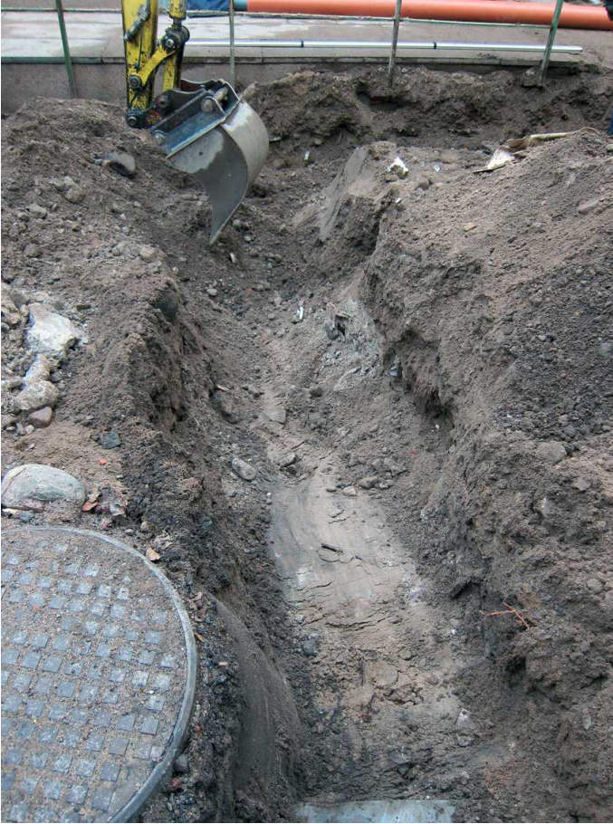
Kuva 124. Pihan kaakkoiskulman sadevesiviemäriputken kaivanto uudehkoissa täyttömaissa. Kuvan vasemmassa alanurkassa on vanha jätevesikaivo. Kuvaussuunta W. 26.9.2014.
