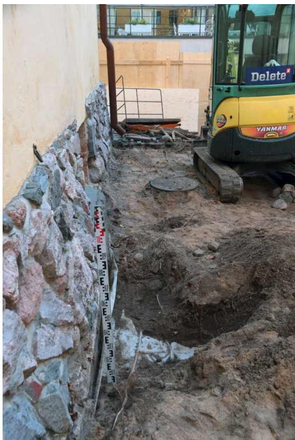
Pihan itäsivu rasvanerotuskaivon pohjoispuolella. Sumpun seinän juurella oli seinää vasten 30 cm korkeudelta ja 40 cm:n syvyydessä 75 cm leveydeltä plastiikka. Plastiikan takana seinässä oli tasainen betonisilote. Kuvaussuunta S. Kuva: Markku Heikkinen. HKM/Helsinki, Hellenius 2014:92.
