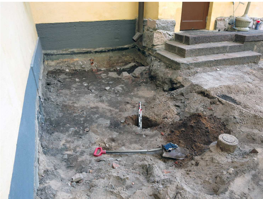
Kuva 19. Pihan köylliskulman syvemmäksi kaivetulle alueelle tehtiin koepisto 1 kerrospaksuuksien selvittämiseksi. Kuvan oikeassa kulmassa näkyy GEO-pisteen kansi. Kuvaussuunta E. 18.9.2014.
