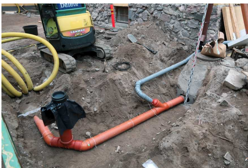
Uusi sadevesiviemäriputkien järjestelmä, jossa vedet ohjataan vanhaan jätevesikaivoon. Alkuperäistä suunnitelmaa putkilinjojen viemistä eteläisen autotallin seinän läpi ei voitu toteuttaa teknisten ongelmien takia. Kuvaussuunta NE. Kuva: Markku Heikkinen. HKM/Helsinki, Hellenius 2014:128.
