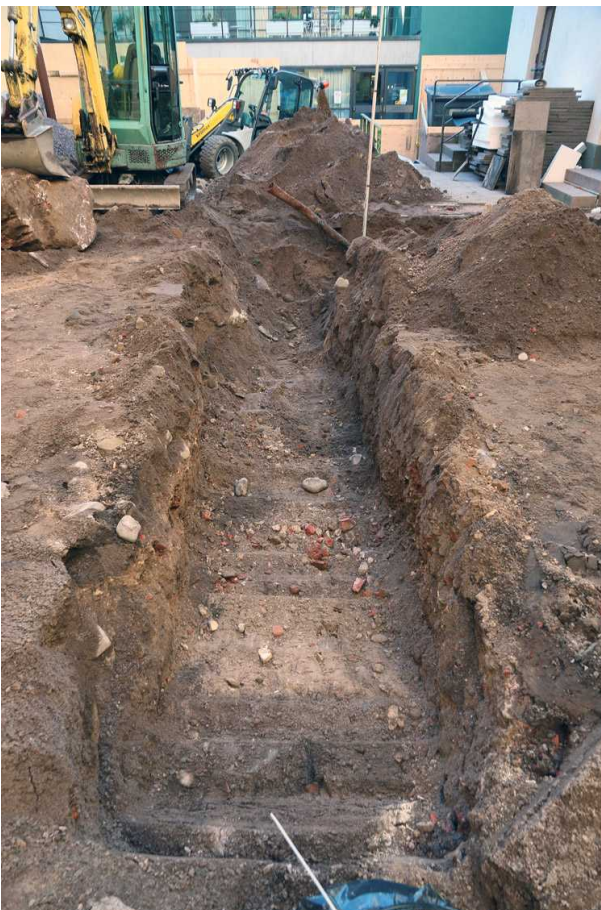
Kuva 108. Keskilinjan kaivanto pihan entisen kulkuluiskan alkuun saakka. Kuvaussuunta S. 24.9.2014.
