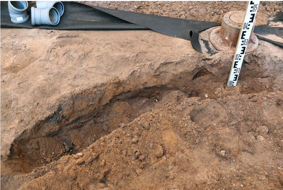
Kuva 26. Sadevesiviemäriputken kaivanto GEO-pisteen luona. Profilissa ylempänä on vielä melko uutta yhtenäistä täyttöhiekkakerrosta. Pihan pinta on sijainnut Geo-pisteen kannen tasolla. Kuvaussuunta N. 19.9.2014.
