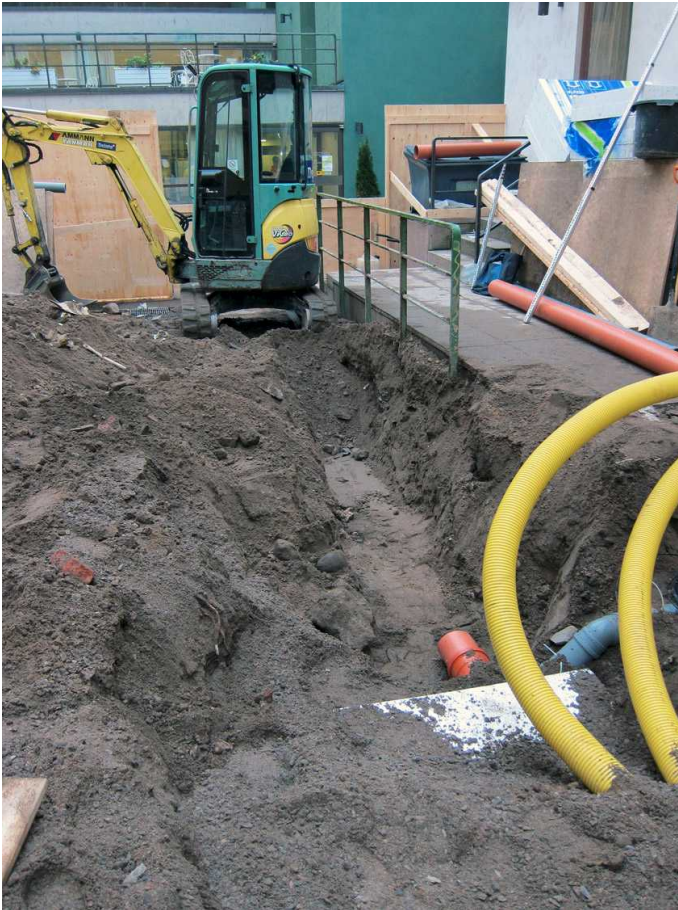
Kuva 113. Keskilinjän kaivanto entisen kulkuluiskan kohdalla pihan eteläosassa. Kuvaussuunta S. 26.9.2014.
