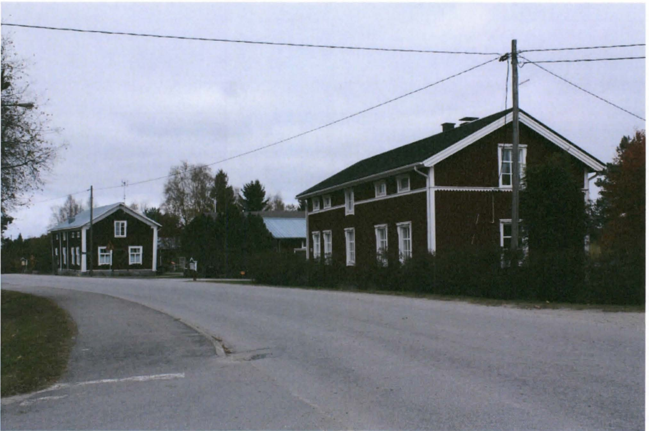
AKDG 3937:2. Knuuttilan raitti, etelästä. Kuvaaja: Petro Pesonen.
