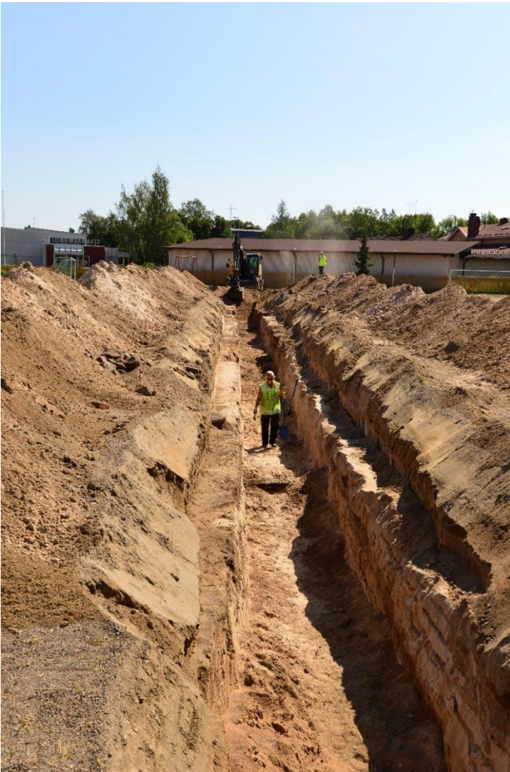
Kuva 5. Koeoja 1 lähes loppuun asti kaivettuna. Koeojan päässä erottuu RUK-museon rakennus ja liikuntahalli. Koeojien seinämät jouduttiin kaivamaan viistosti ja terassoiden hienon hiekkamaan sortumauhan vähentämiseksi. Kuvattu kaakkoon. Kuva: Vesa Laulumaa/ARKE (AKDG 3870:8).
