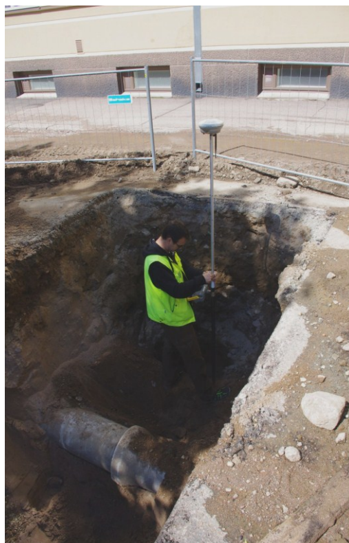
Kuva 7: S. Kivisilta mittaamassa Opistokadun alla kulkevien viemäriputkien sijaintia. E. Kuva: KyM/M. Kykyri.
