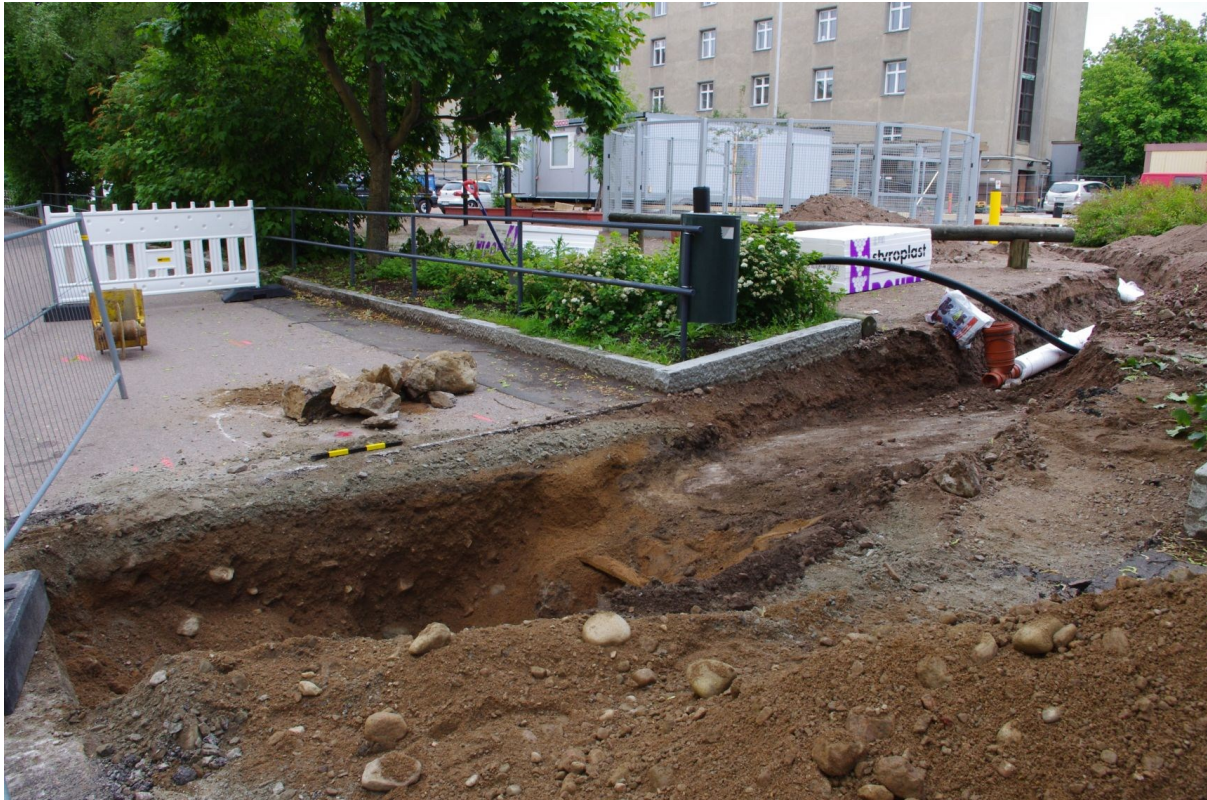
Kuva 9: Viemärikaivanto pohjaan kaivettuna. Oikealla keskellä näkyy peruskallion pintaa. W. Kuva: KyM/M. Kykyri.
