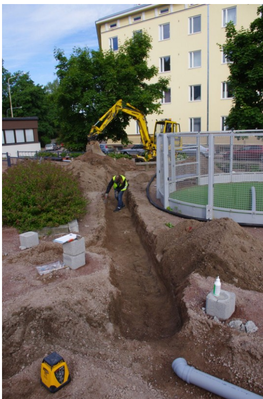
Kuva 6: M. Minkkinen siistimässä ojan keskiosan S-seinämää. E. Kuva: KyM/M. Kykyri.
