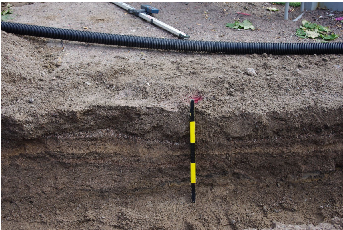
Kuva 10: Viemäriojan kerroksia dokumentoidun maapilarin MP3 kohdalla. SW.
