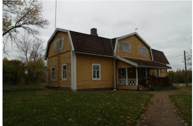
Kuva 26. Oravalan kartanon päärakennuksen vanha siipirakennus. KK2014_22. SW-NE. Kuva Salla Pärssinen.
