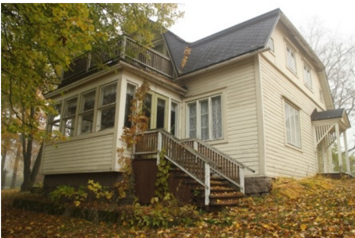
Kuva 61. Karhula Tolkko, päärakennus ja sen alle jatkuva vanha kivijalka. KK2014_57. S-N. Kuva Salla Pärssinen.
