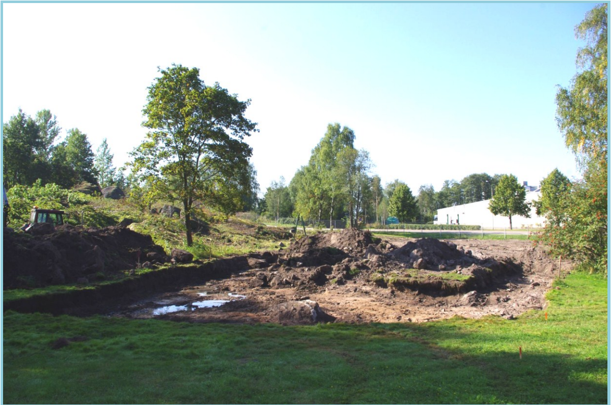
Kuva 22: Lohko V pohjaan kaivettuna. Keskellä kaivamatta jätetty kannas, jonka alueelle maaperä sisälsi erittäin paljon täyttökiveä. Lohkon alueelle idästä kalliopintaa pitkin valunut pintavesi muodosti kaivausalueelle matalan vesilammikon. E. Kuva: KyM/M. Kykyri.
