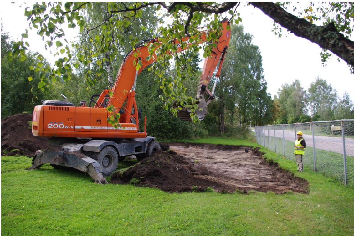
Kuva 7: M. Kykyri valvoo Puistotien vierustalle avatun lohko I:n kaivamista. N. Kuva: KyM/A. Ryökkynen.
