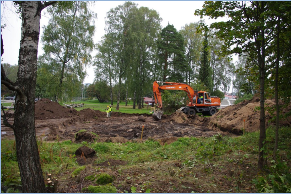
Kuva 19: Lohko IV:ää kaivetaan. M. Kykyri ja A. Ryökkynen valvomassa. S. Kuva: KyM/M. Minkkinen.
