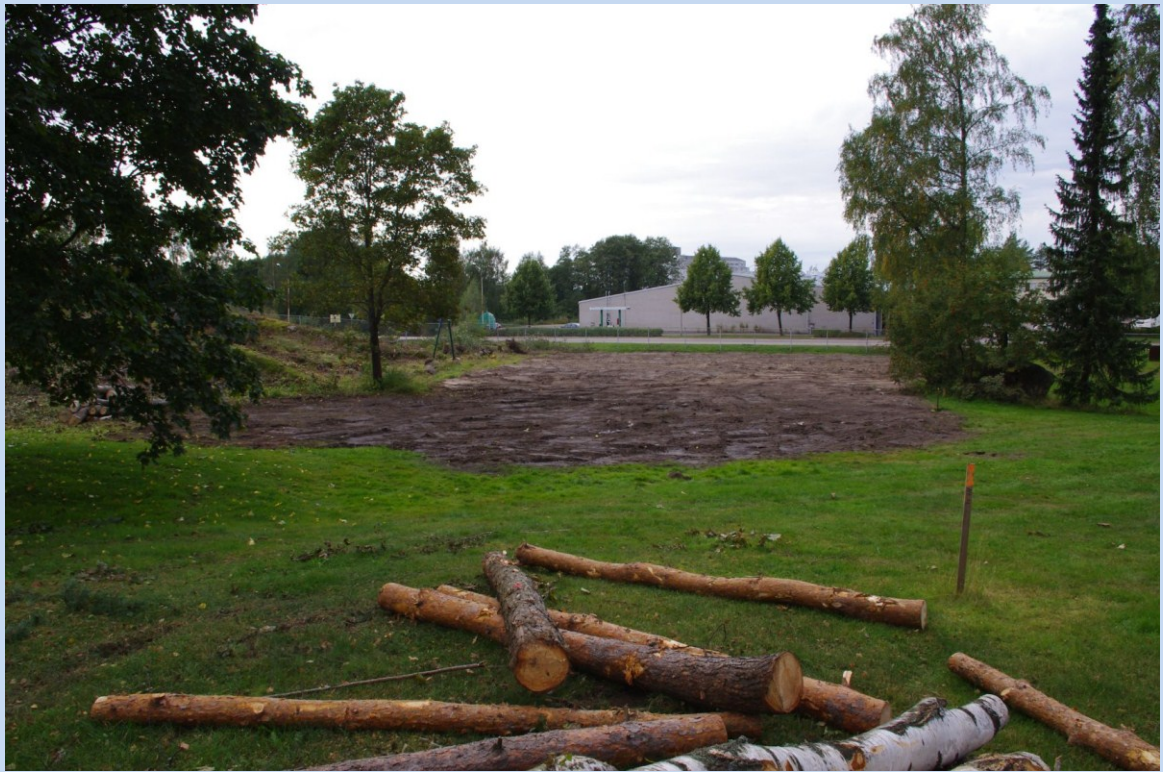
Kuva 26: Kaivausalue peitettynä valvontatyön loputtua, taustalla Puistotie. E. Kuva: KyM/M. Kykyri.
