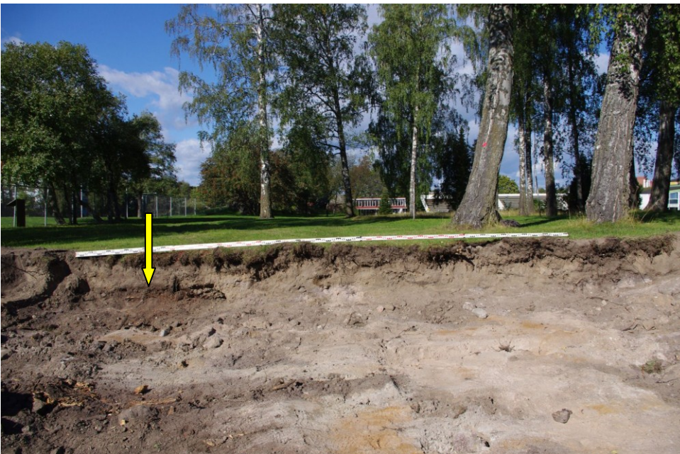
Kuva 14: Lähikuva N-seinämästä ja pohjatason kerroksista. Nuolen kohdalla seinämässä on purkujätekerrosta (krs.1), joka ulottui aina koskemattoman pohjamaan pintaan. S. Kuva: KyM/M. Kykyri.
