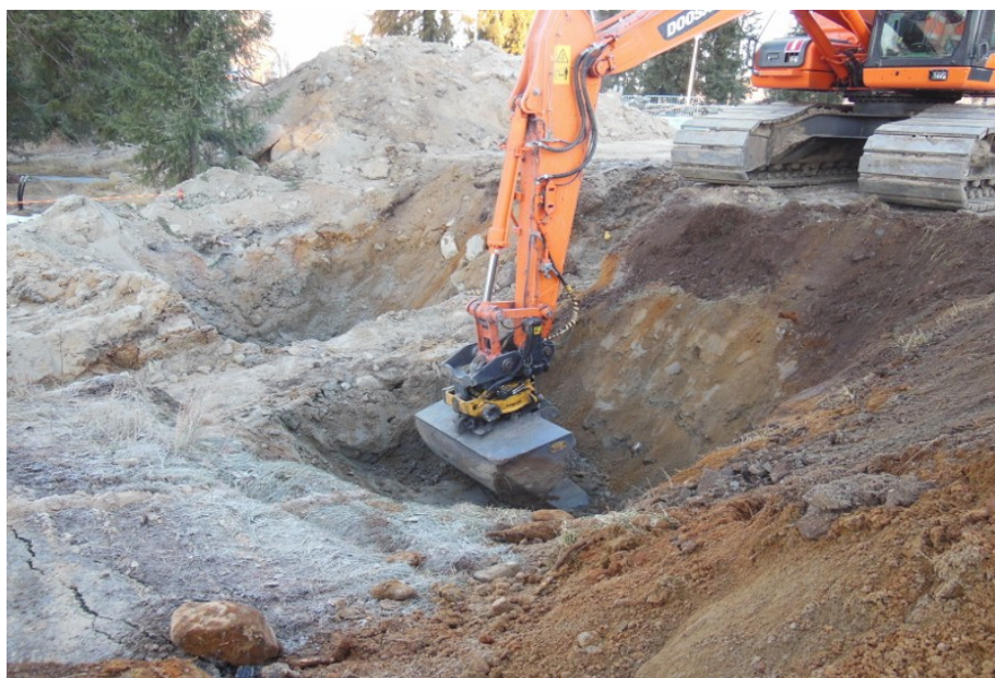
Kuva 11. Porakaivoyksiköiden kuopat lähes pohjassa.
