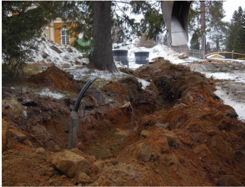
Kuva 14. Porakaivot ovat valmiita yhdistettäväksi. Taustalla näkyvät porakaivoyksiköt ja kirkko.
