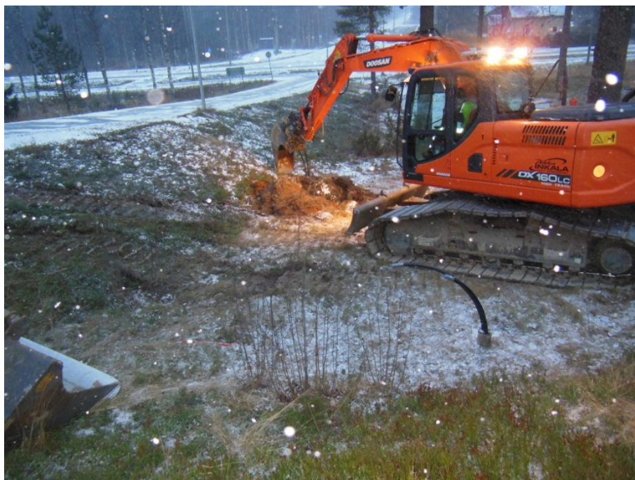
Kuva 12. Aloituskuvaa porakaivoihin liittyvistä kaivannoista.
