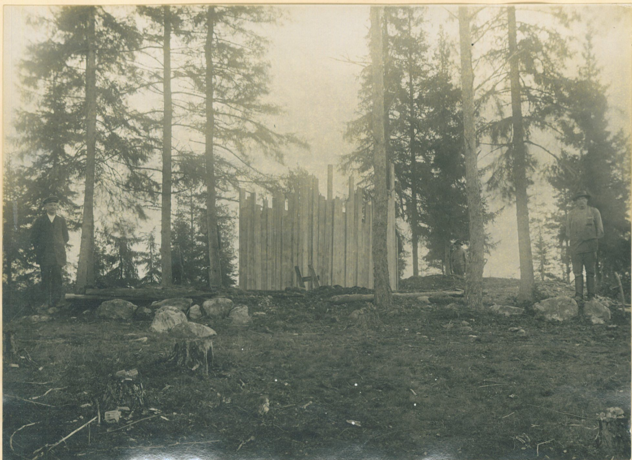
Kuva 2. Hietamäen kappelikirkon kivi- jalalan länsisivu, lännestäpäin valaku- vattuna. Kuvassa näkyvät neljä mies- tä seisovat yksi kussakin kivistalon nurkassa. Kuvan keskellä näkyy laudoilla tuettu kockuoppa. Vasemmalla reunassa on kivistalon päällä kirkon hirsien jäännöksiä. Foto: A.S. 13.9.1918.
