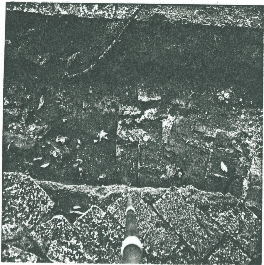
7. Tiililadelmaa 21-22 m:n kohdalla
