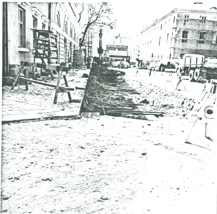
9. Yleiskuva kaivannosta luoteesta kuvattuna
