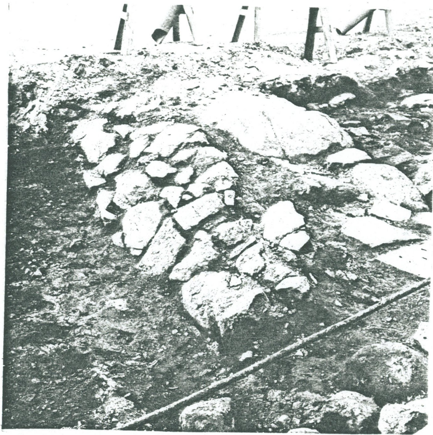
22. Harmaakiviperustuksen kaakkoisseinän ladelmaa
