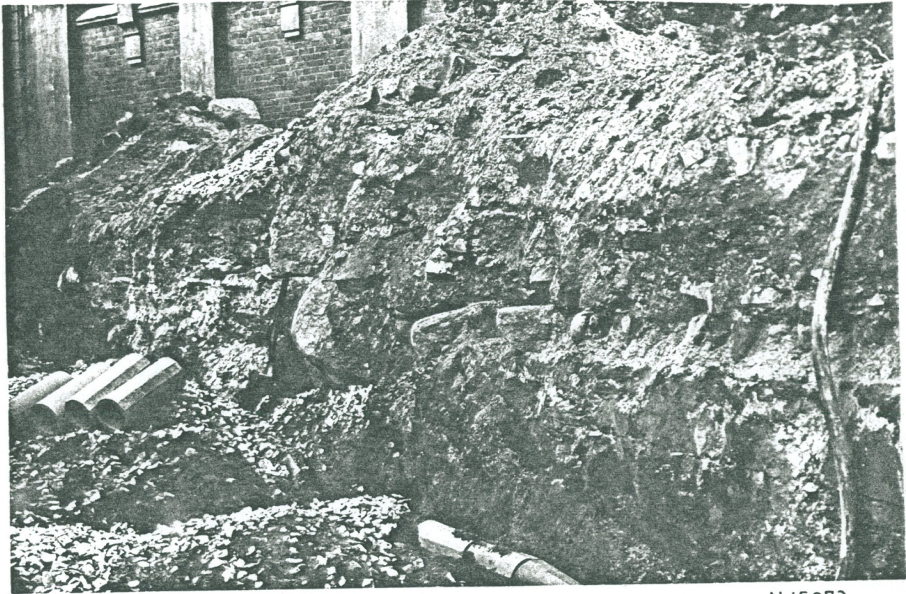
28. Kaivanto 9:n luoteisseinää 9 - 18 m:n kohdalla
