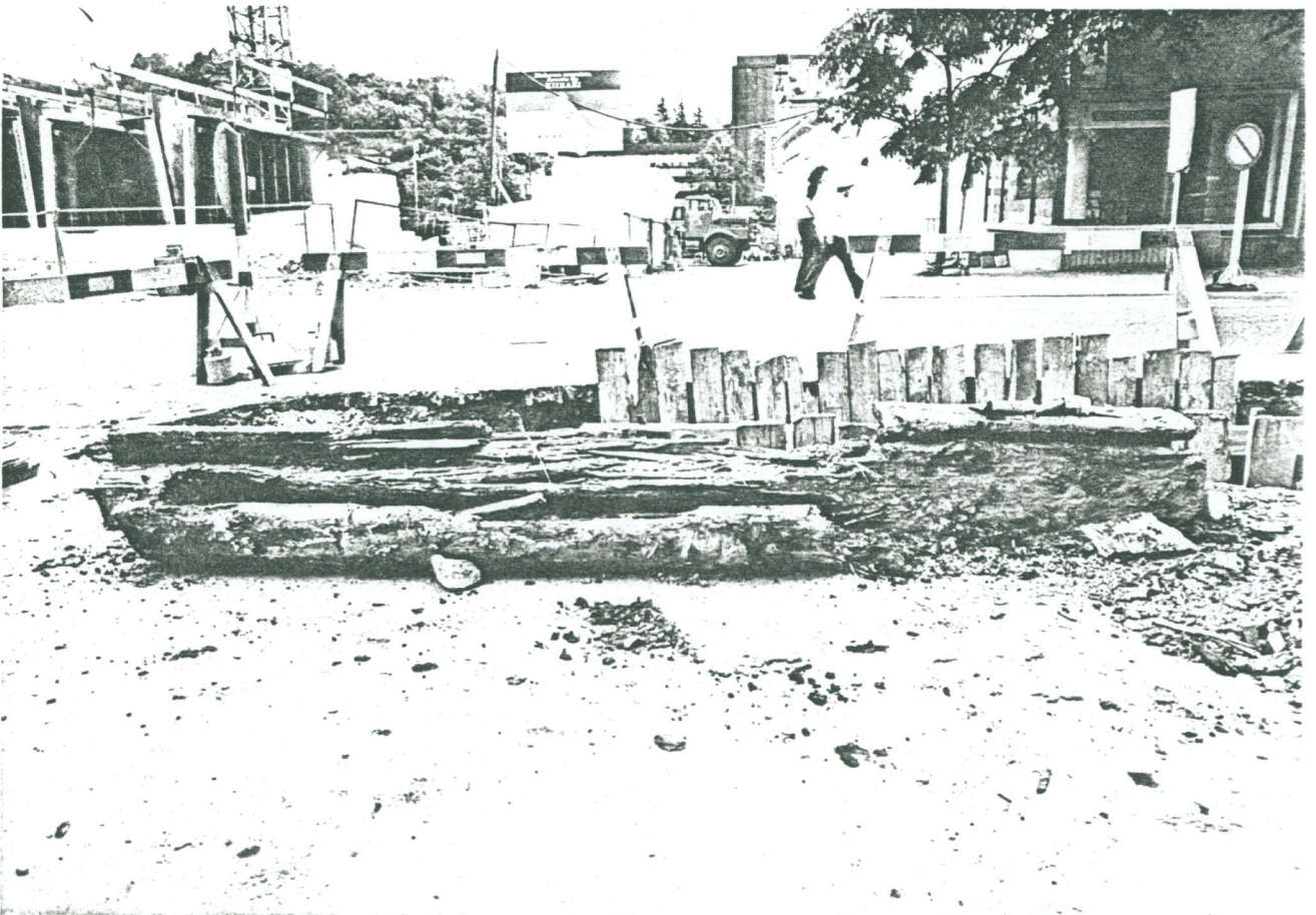
2. Viemäriputket nostettuina kaivannon reunalle.
