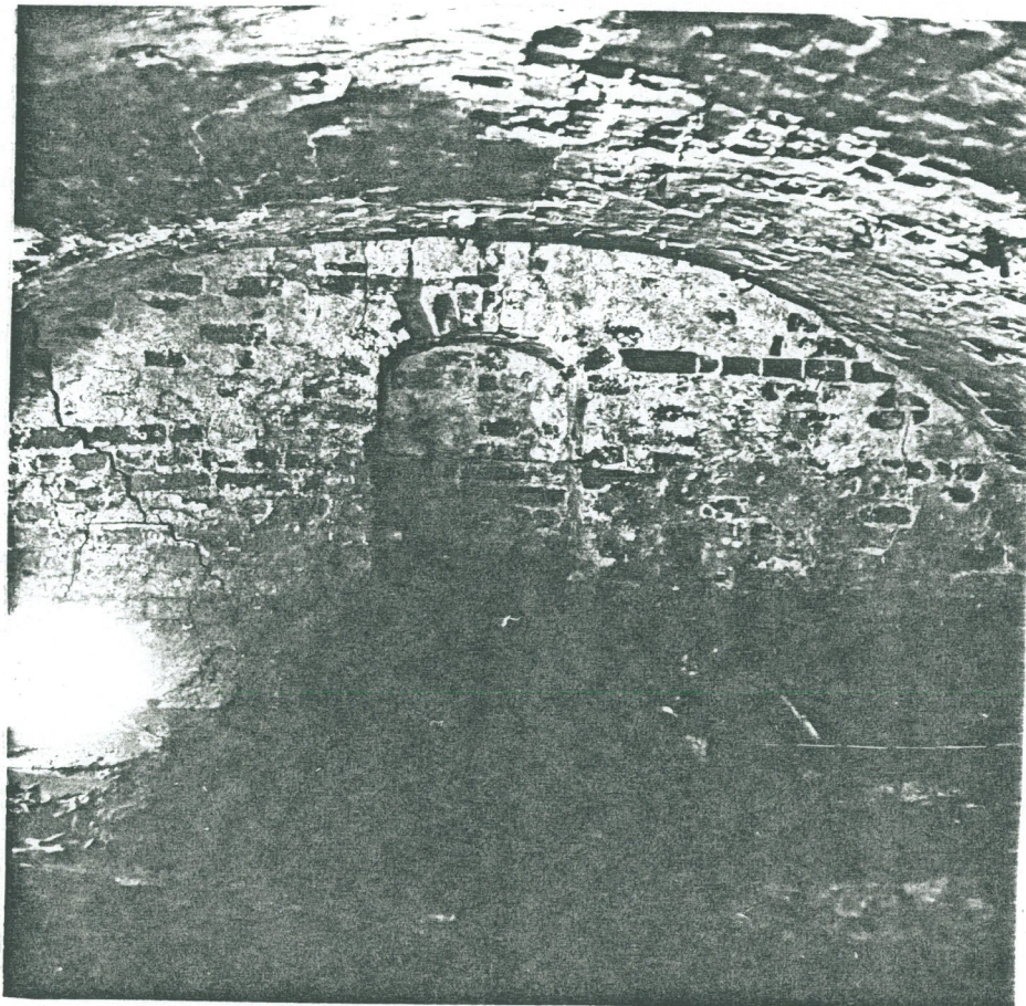
29. Kellarin pihan puoleinen päätyseinä N 48559
