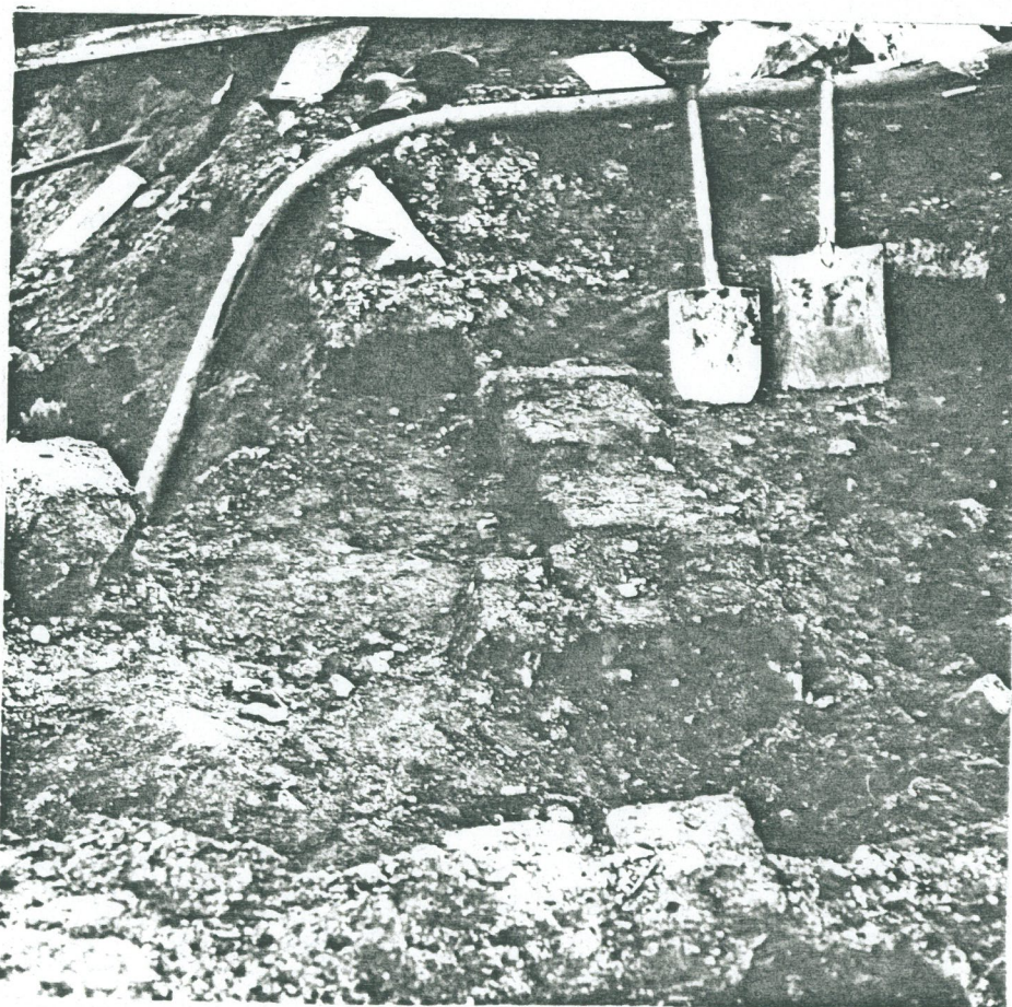
8. Kellarin portaiden tiilimuurauksen ylä- reunaa oviaukon yläpuolelta kuvattuna N48548
