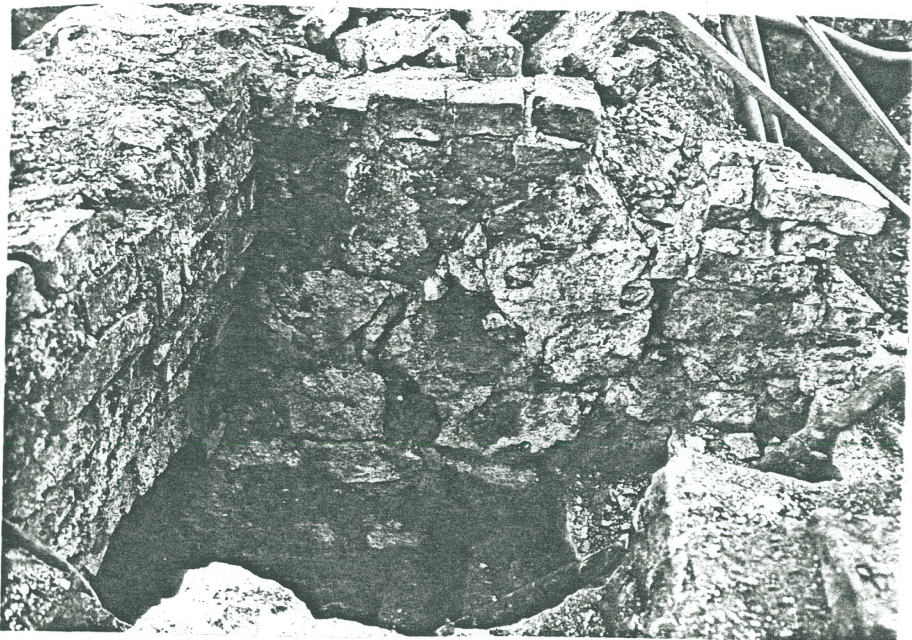
17. Sisäänkäyntiaukon Aninkaistenkadun puoleinen seinämä
