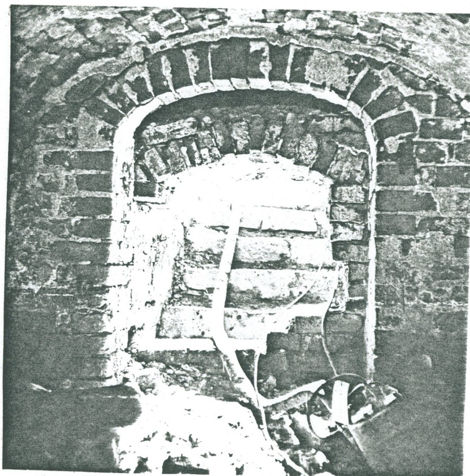
26. Kellarin oviaukko sisältä kuvattuna
