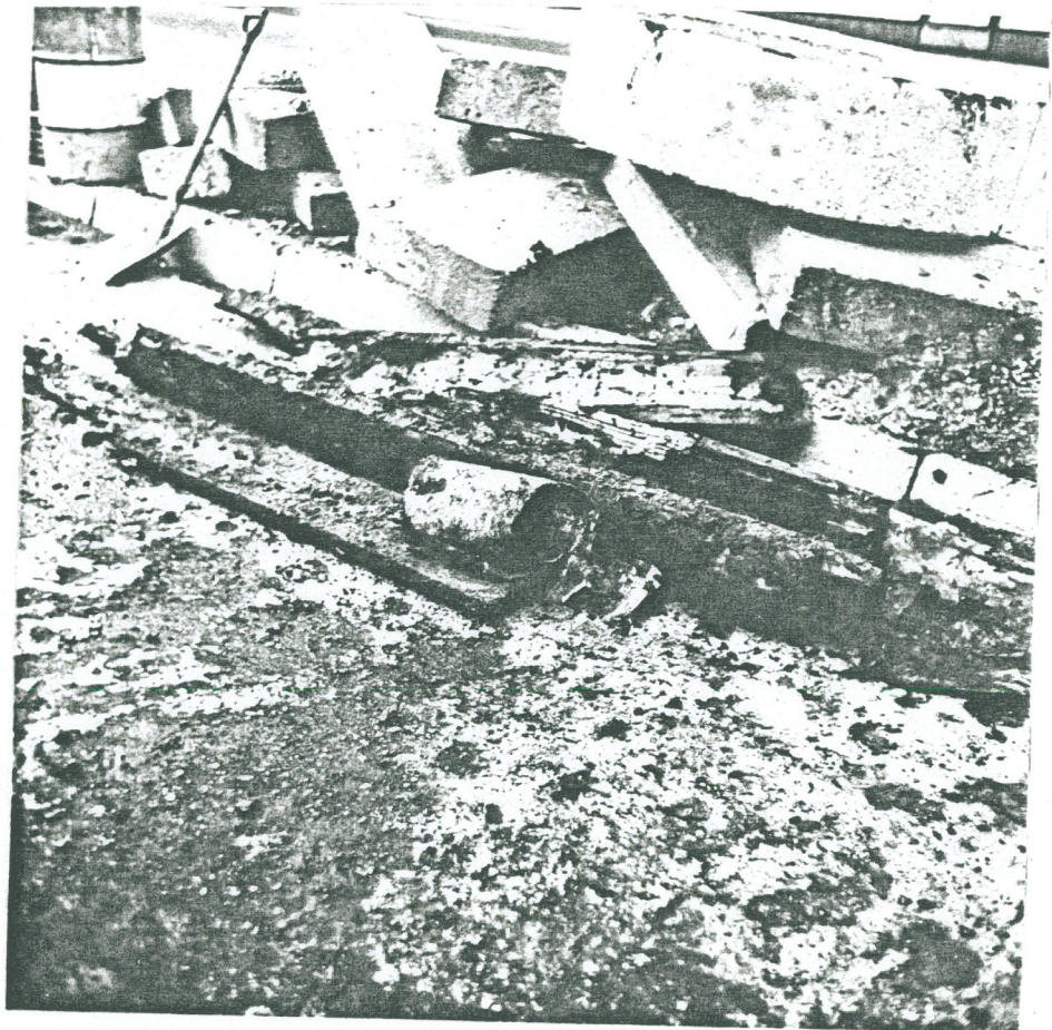
1. Viemäriputki 1:n jäännökset
