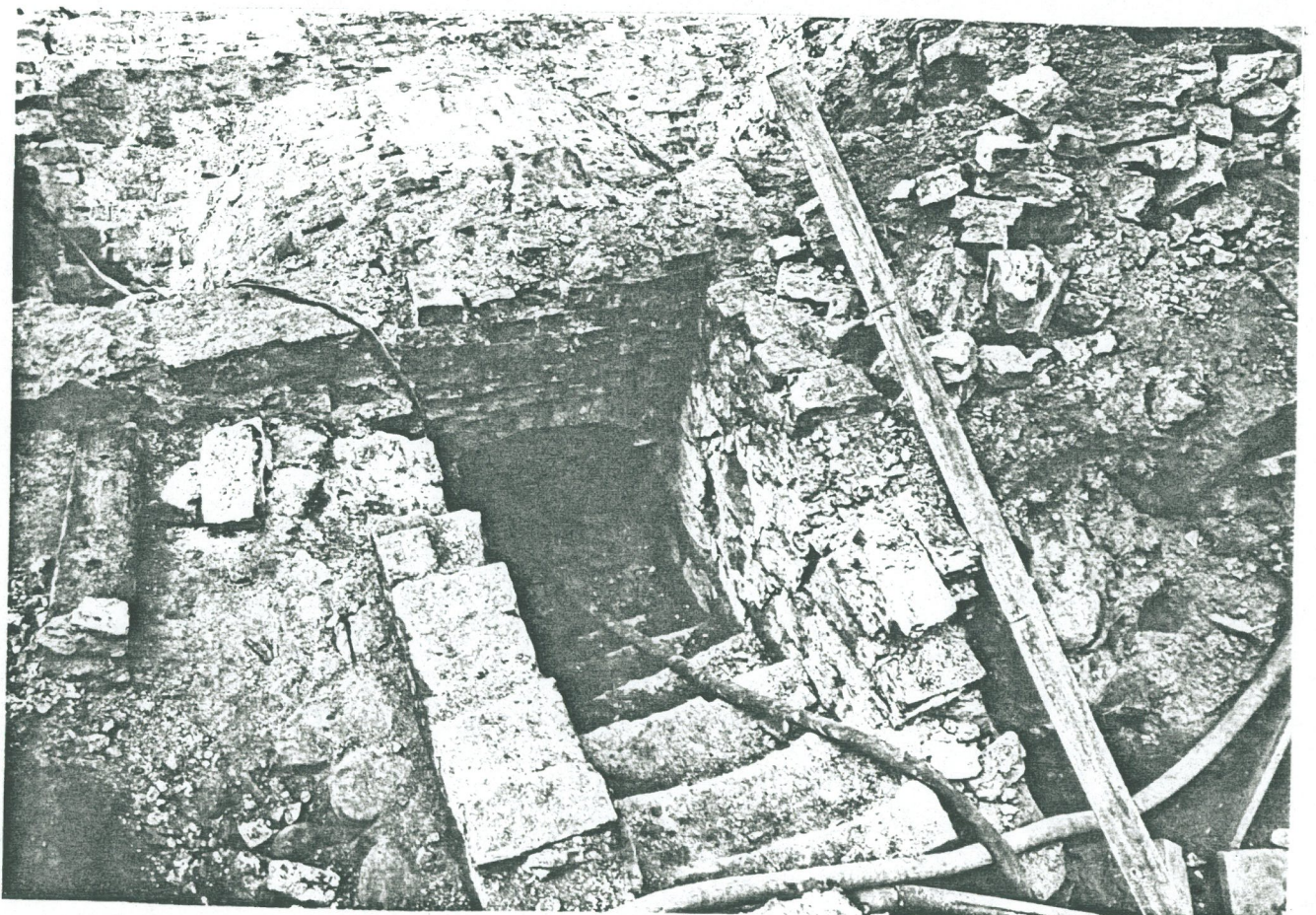
24. Kellarin sisäänkäyntiaukko rakennuksen nurkalta kuvattuna
