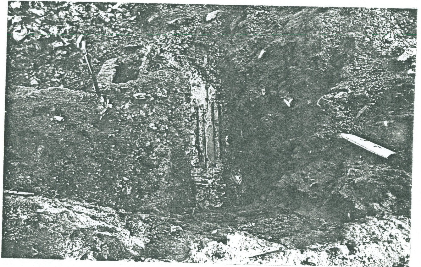
62. Viemäriputki 3 ylhäältä kuvattuna
