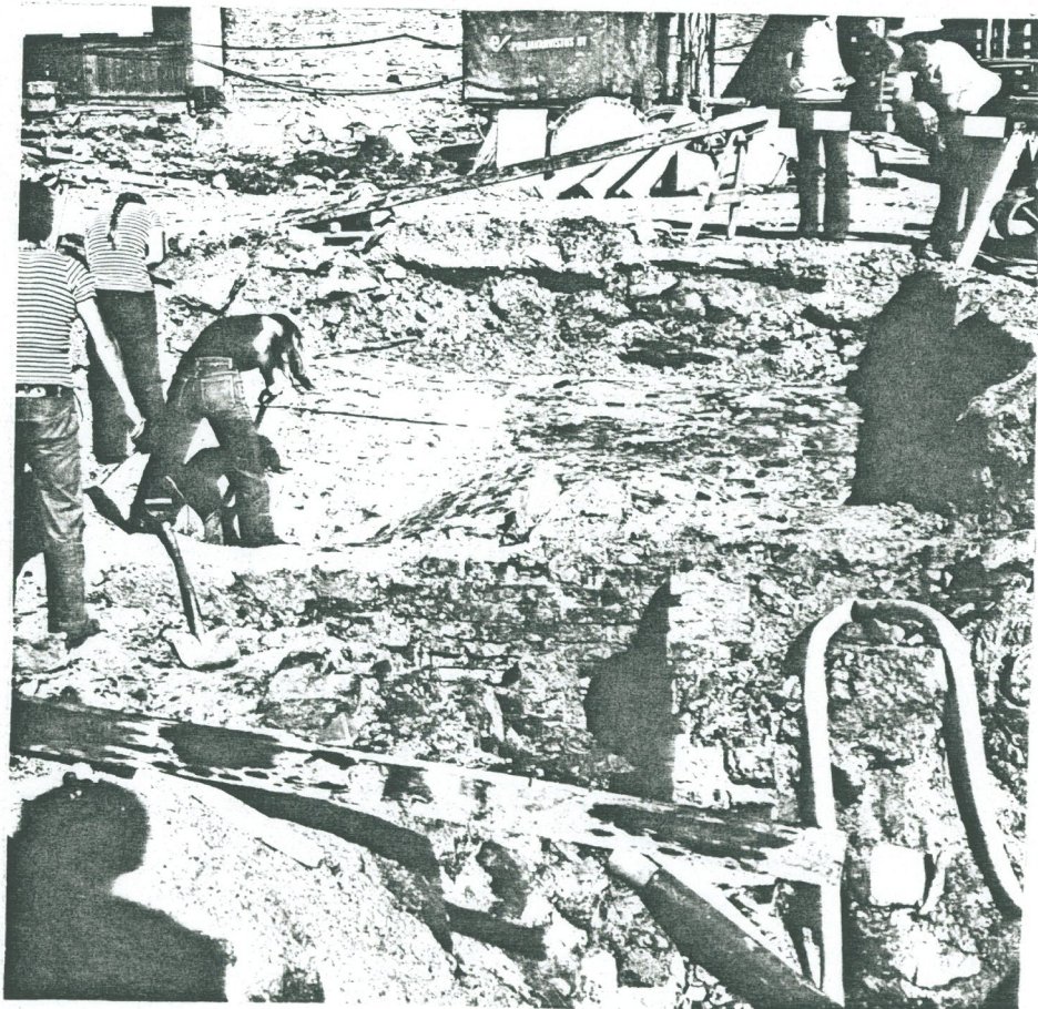
14. Osa holvin kattoa rakennuksen kulmalta N 48553 kuvattuna
