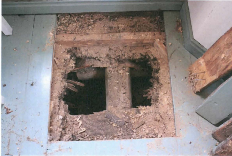
Kuva 12. Kaivaminen oli koekuoppa B:n kohdalla haastavaa suuren etäisyyden lattiatason ja alla olevan maapinnan vuoksi, kuvattu kaakosta. AKDG 3909:11
