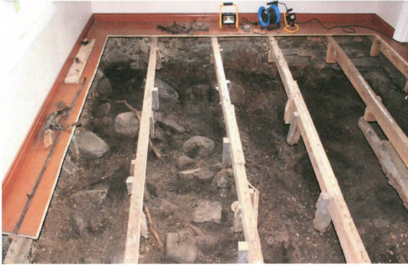
Kuva 15. Kaivausalue 2:n pinta lattian poiston jälkeen, kuvattu luoteeseen. AKDG 3909:14
