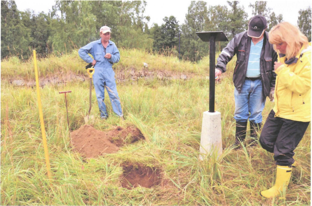
Kuva 5. Itäisen puolibastionin varoituskylttiä (Vk1) asennetaan paikalleen. Kyltin betoniantura jää 2-3 cm korkeudelta maanpinnan yläpuolelle.
