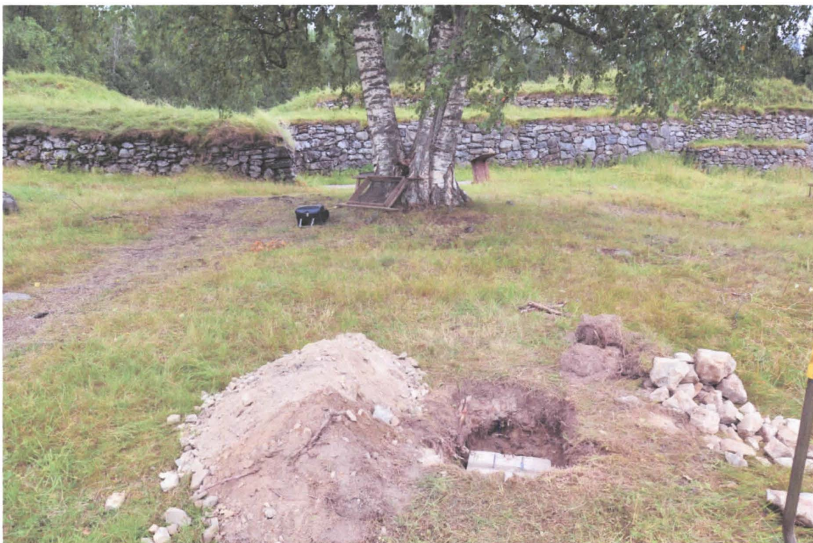
Kuva 3. Sotilaskasarmien opasteen (Op4) betoniantura paikoilleen asennettuna. Taustalla näkyy vuonna 2008 pystytetty uusi pääopaste.
